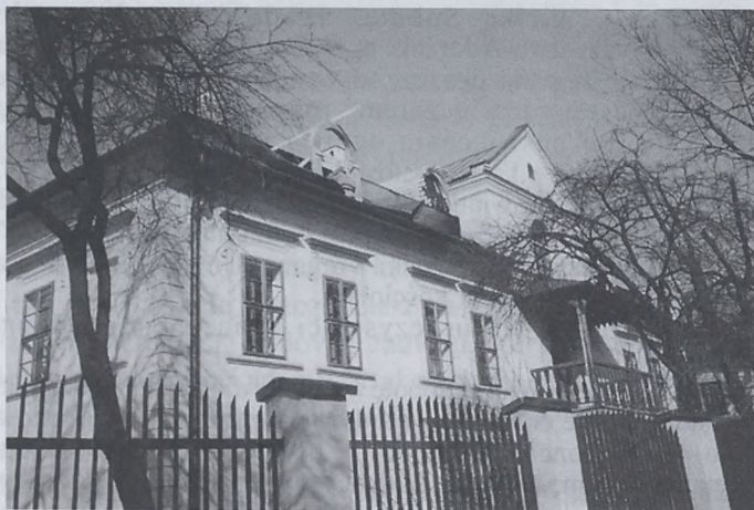
Dworek Łowczego, w trakcie przebudowy poddasza (fot. P. Boroń)
