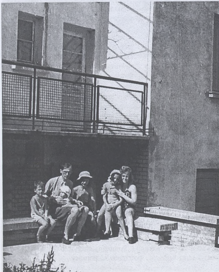
Dom przy ul. Spadzistej 23 (obecnie Hofmana 32)
