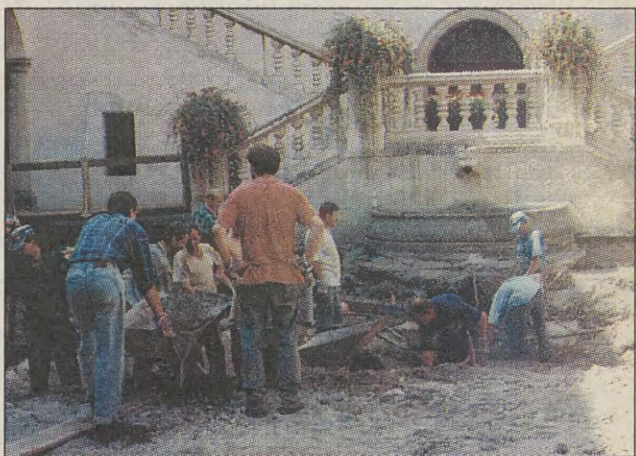
Trwa remont Collegium Medicum przy ul. św. Anny 12. Kładziony jest nowy dach, naprawiany jest dziedziniec. Po zakończeniu prac Kraków będzie miał kolejną perelkę architektoniczną, której przywrócono blask
