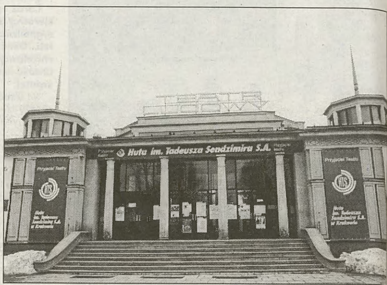
Otoczenie Teatru Ludowego staje się coraz bardziej niebezpieczne.
