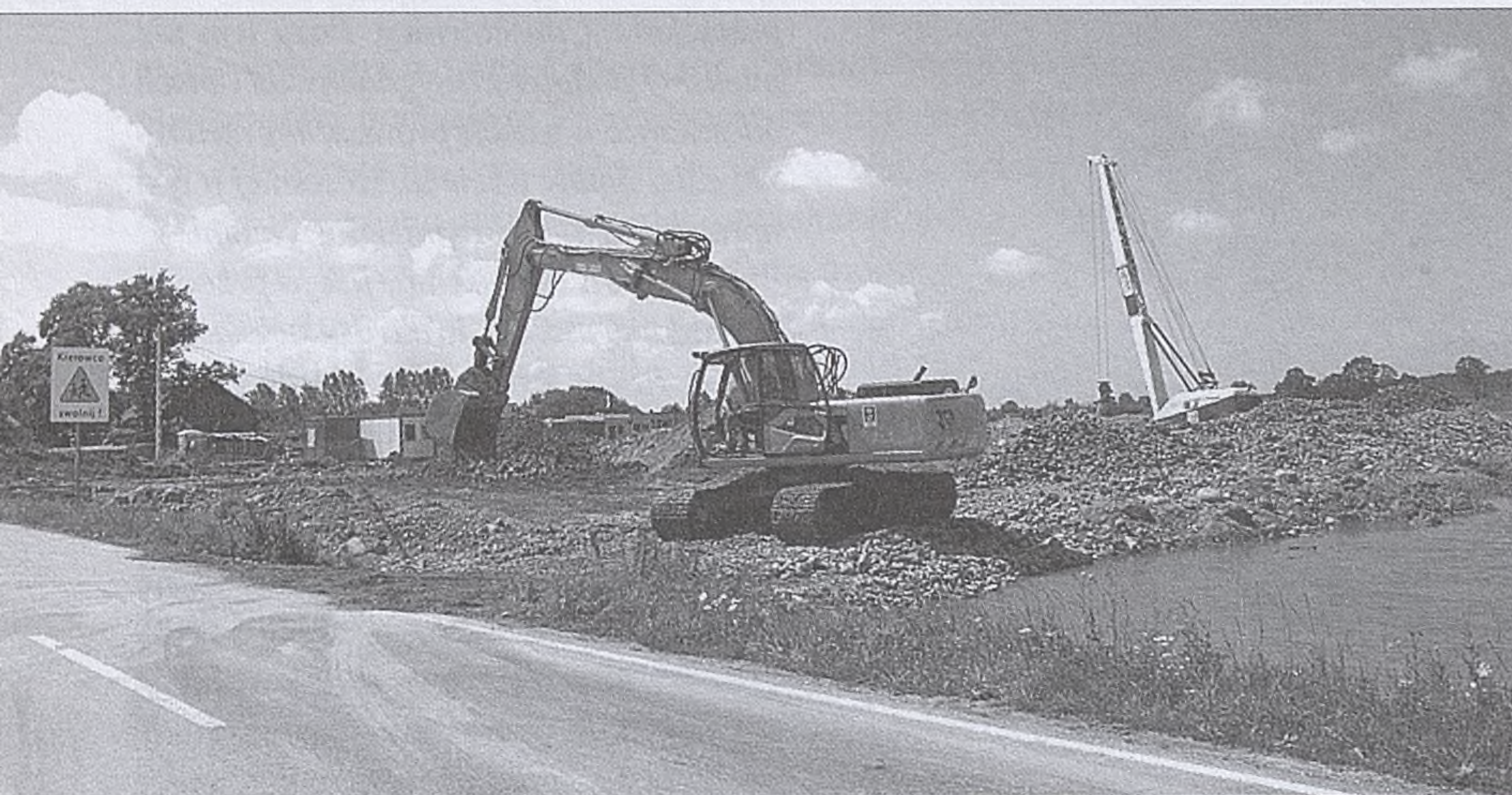
Budowa autostrady w Proszówkach
