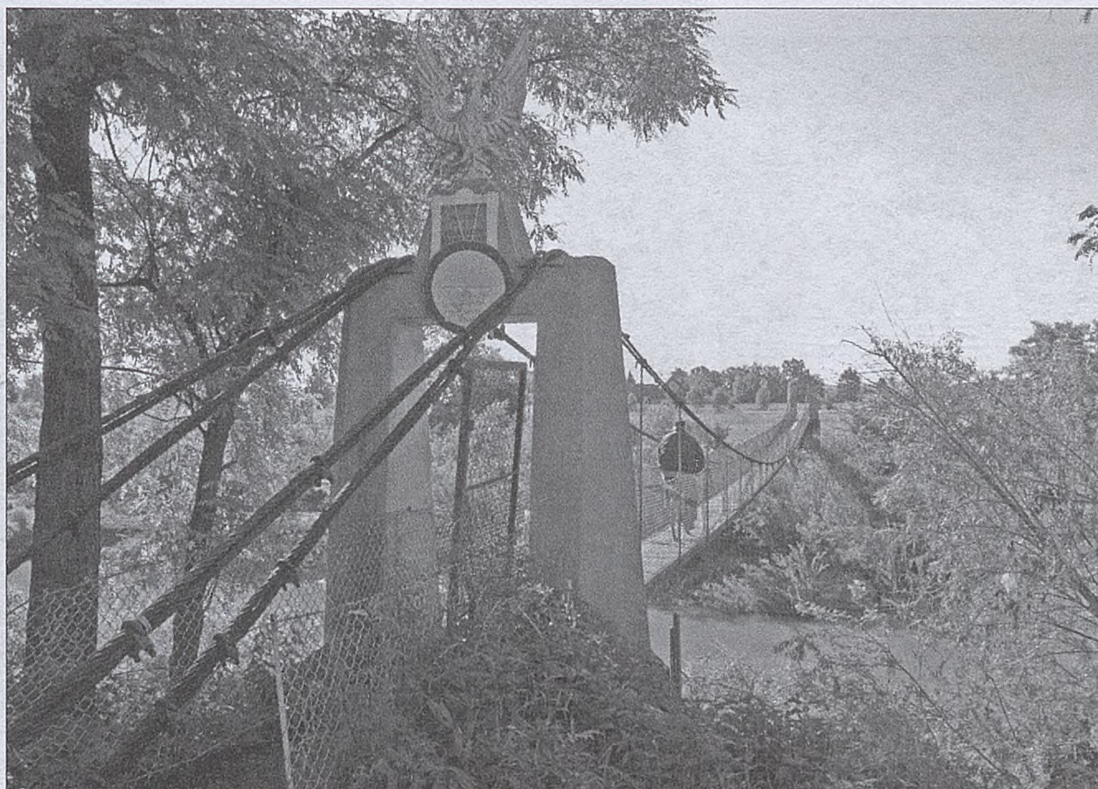
Mimo zakazu, mieszkańcy nadal korzystają z wiszącego mostu
