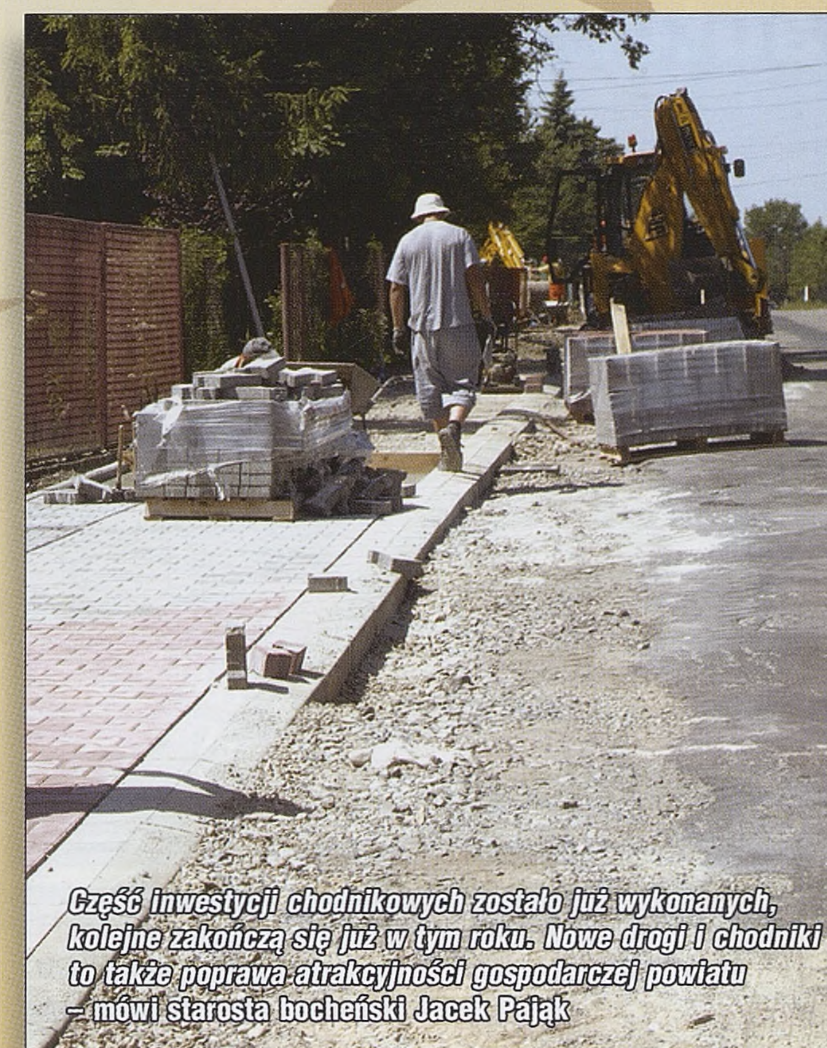
W ramach „ciągu północnego” wykonane zostanie m.in.: 22 km nawierzchni drogowej, ponad 3 km chodników oraz 1,5 km ścieżek rowerowych
