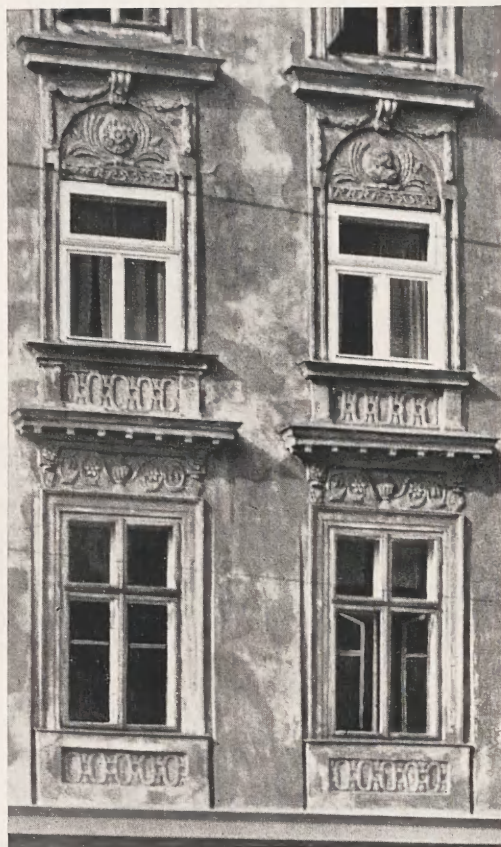
Fig. 27. Część fasady domu «pod Murzyną» przy ul. Florjańskiej l. 1. Fot. W. Łoziński.
