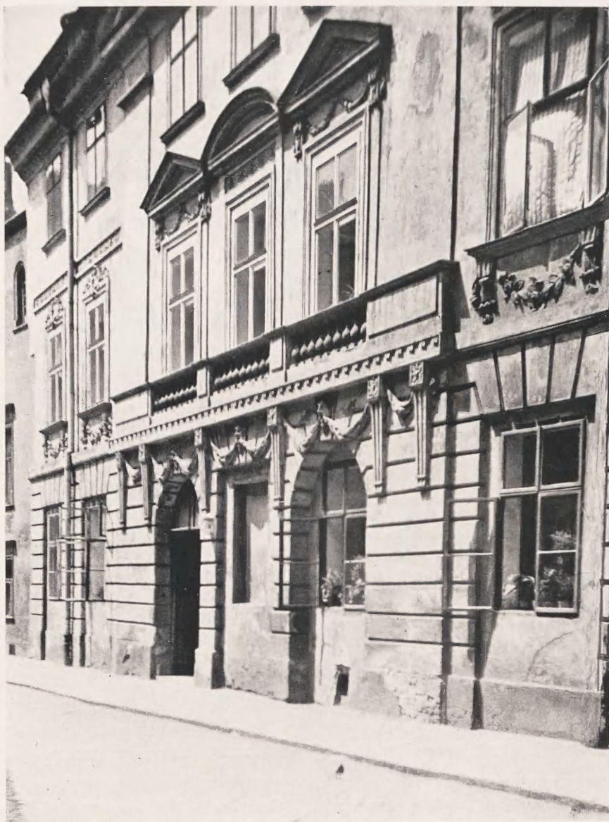
Fig. 5. Dom przy ul. Kanoniczej 1. 19. Fot. W. Łoziński.
