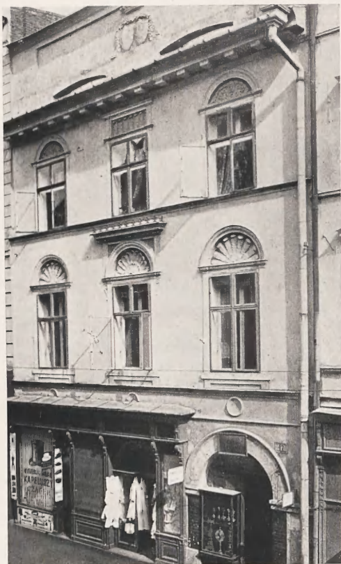
Fig. 28. Dom przy ul. Florjańskiej 1. 47. Fot. F. Klein.
