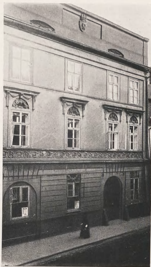
Fig. 29. Dom przy ul. Florjańskiej 1. 53. Fot. F. Klein.
