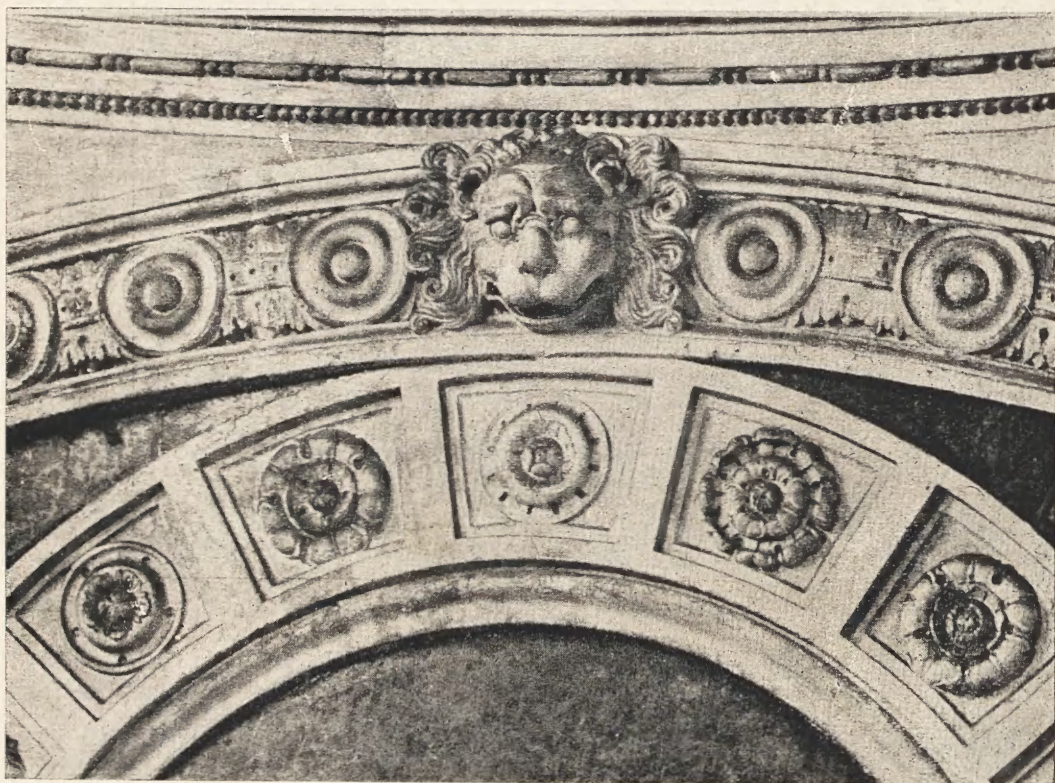
Fig. 38. Fragment ściany tarczowej kaplicy Myszkowskich
