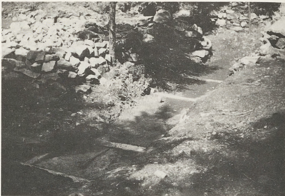
74. Zakład przygotowywania rud na Pysznaj. Wykop rowu płuczek, 1960.
