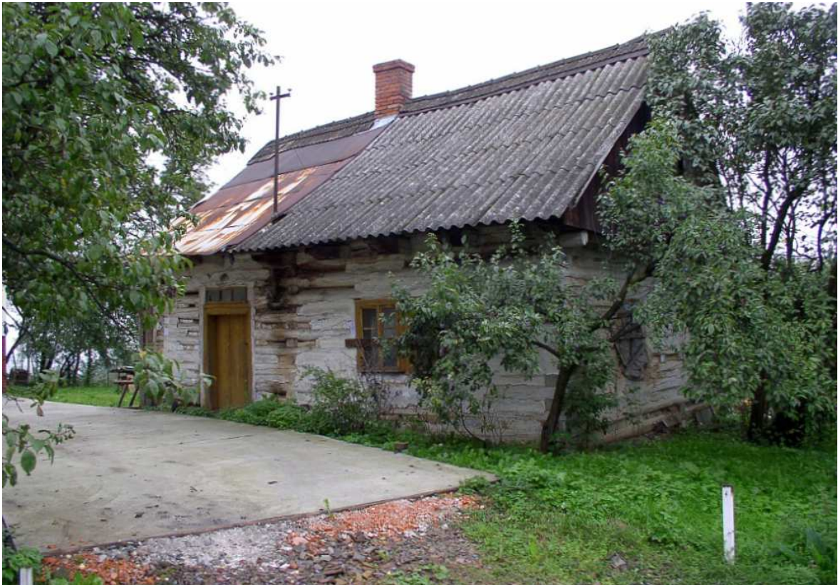
Fot. nr 33 (33-36). Skromna chatka – obiekt z ulicy Dębowej (nr 23), kolejny antyk z zapewne XIX-to wiecznymi korzeniami. Chyba jeszcze trwa.
