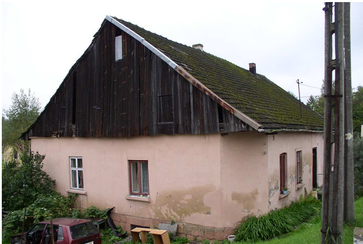
Fot. nr 18 (18-20). Przedwojenny, murowany budynek mieszkalny z sąsiedztwa mostu.
