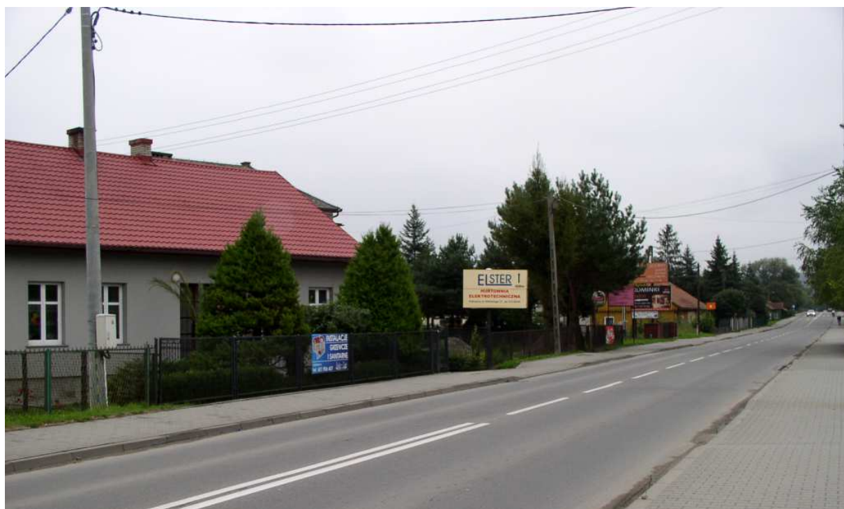
Fot. nr 3. Ulica Mostowa – widok w kierunku mostu na Rabie (12.09.2010).
