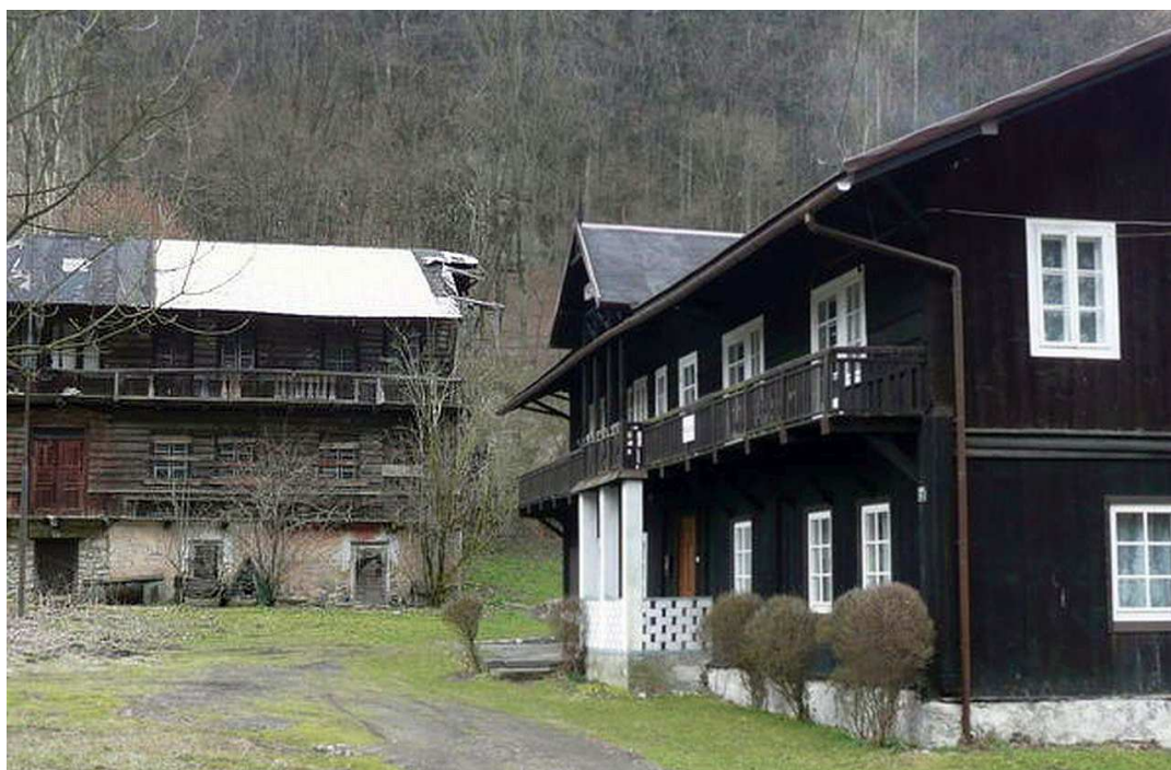
Fot. nr 143 (143-144). Willa Zawiszówka - Ojców 19, przysiółek Czyżówki. Budynki stojące w w poprzek (nr 17?) widoczne są na zdjęciach 145-146. Fot. z końca XX wieku - Wojciech Borek (2004)
