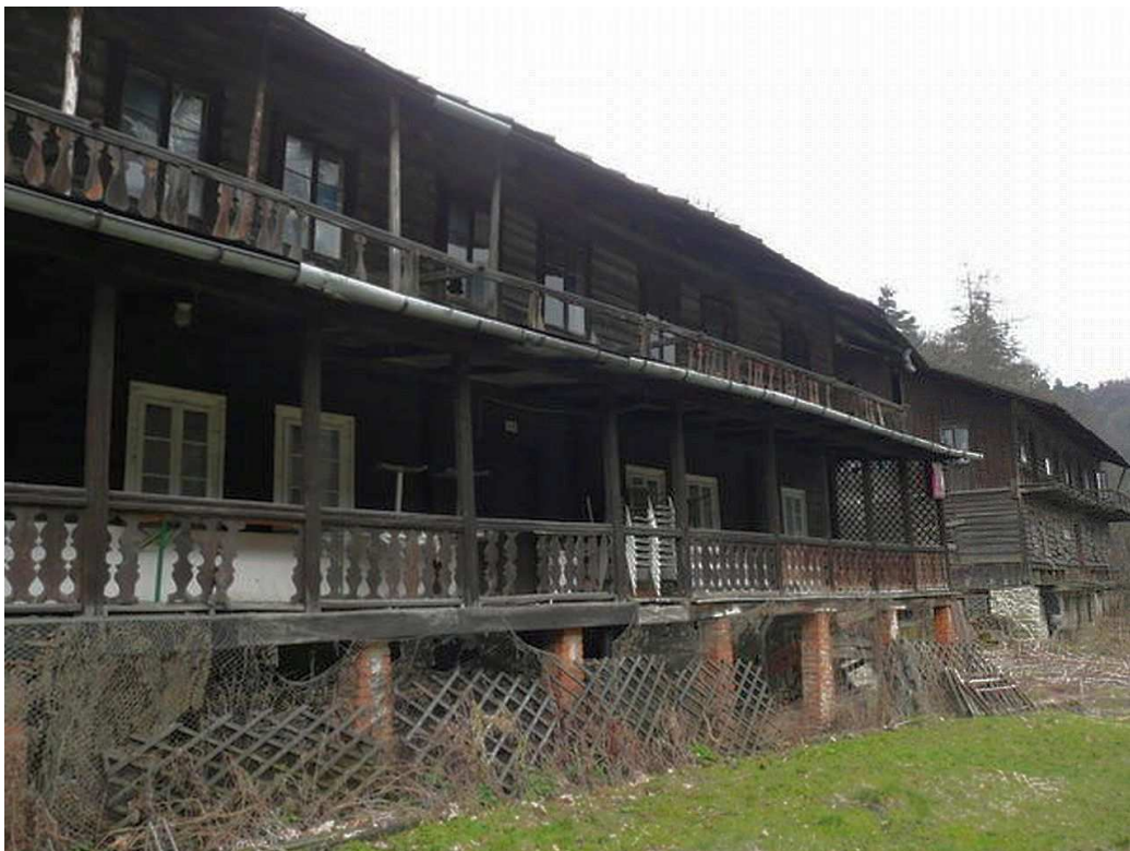
Fot. nr 145 (145-146). Budynki nr: 16(?) i 17(?), które były ustawione prostopadle do Zawiszówki. Fot. Wojciech Borek – 2004.
