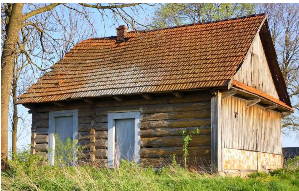
Fot. nr 31. Budynek gospodarczy z okolic Woli Batorskiej i Zabierzowa Bocheńskiego. (13.05.12)
