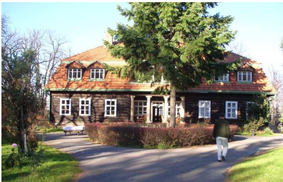
Fot. nr 75. Fasada zabytku. (listopad 2010)
