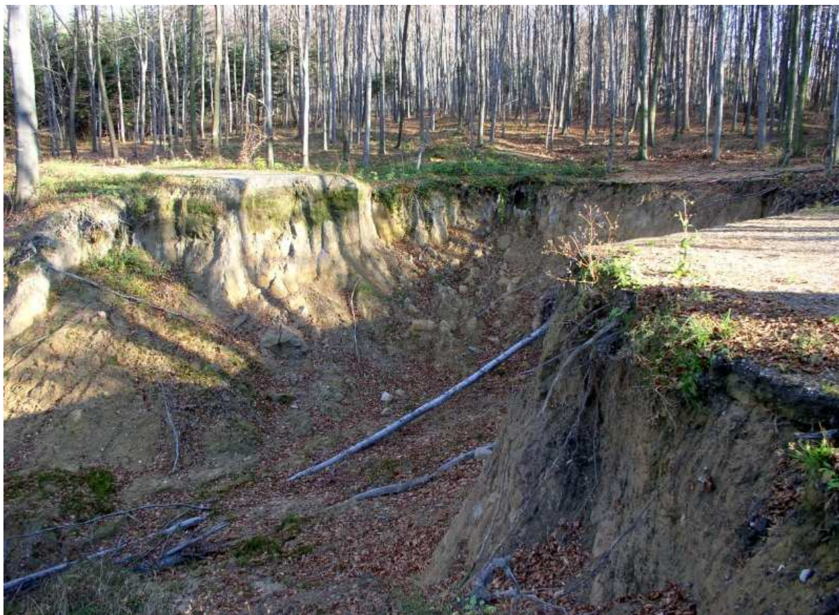
Fot. nr 90. Zerwana droga leśna na trasie z „Wólki” do Zagórzan. (listopad 2010)
