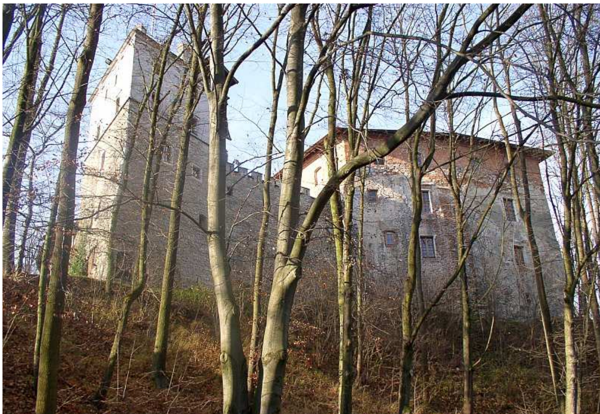
Fot. nr 59. Mury zamku pną się w górę. Czy nie za wysoko? (11.11.2010)
