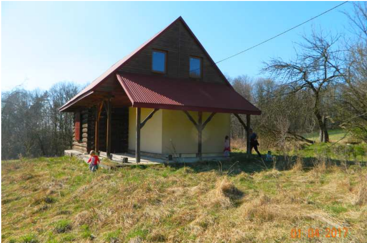
Fot. nr 217. Dacza w miejscu starej chałupy, powstała z wykorzystaniem jego drewnianych belek
