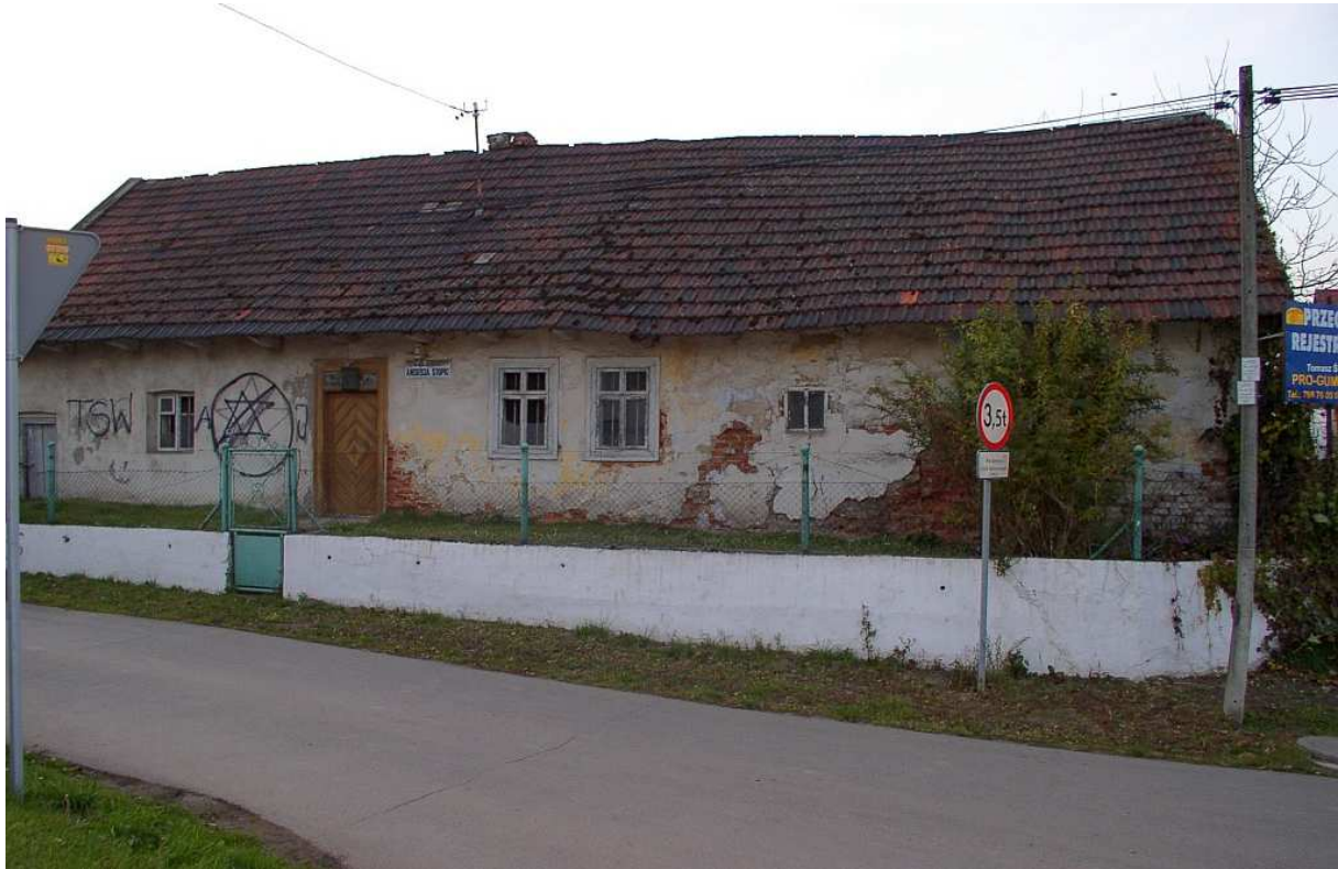
Fot. nr 41. Fasada kościelnickiego oryginału. (23.10.10)
