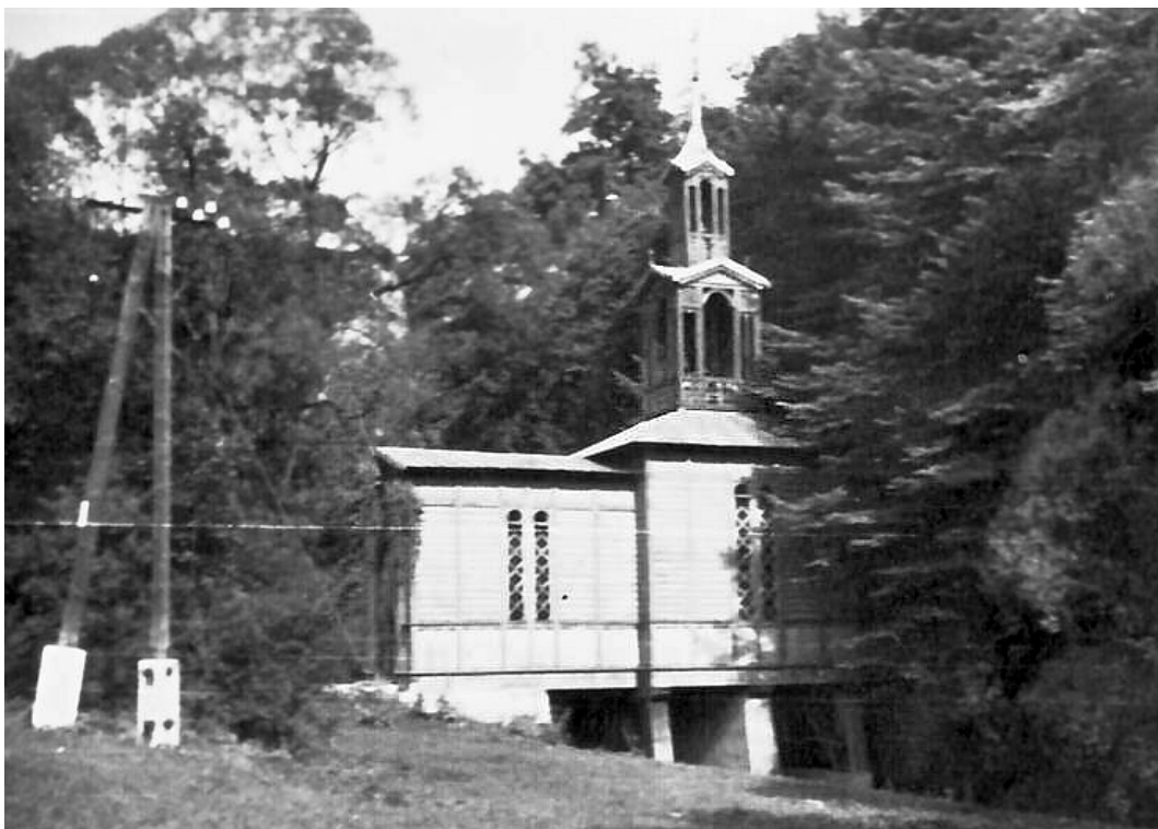
Fot. Nr 136. Kaplica Na Wodzie. Fot. Wojciech Borek (1965).
