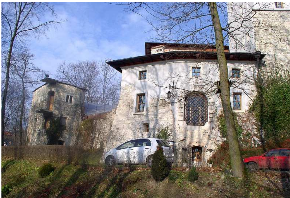
Fot. nr 63. Rekonstrukcja części mieszkalnej warowni. (11.11.2010)
