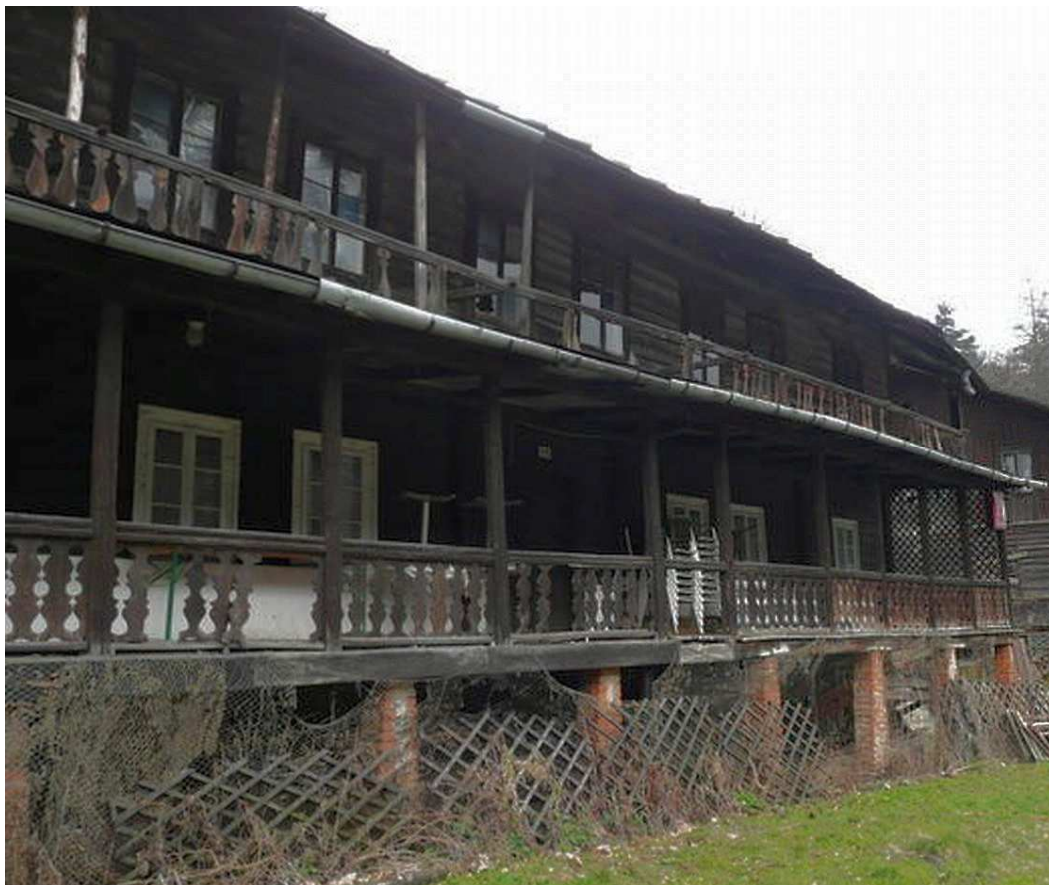
Fot. nr 146. Budynek pod nr 17 (?). Fot. Wojciech Borek (2004).
