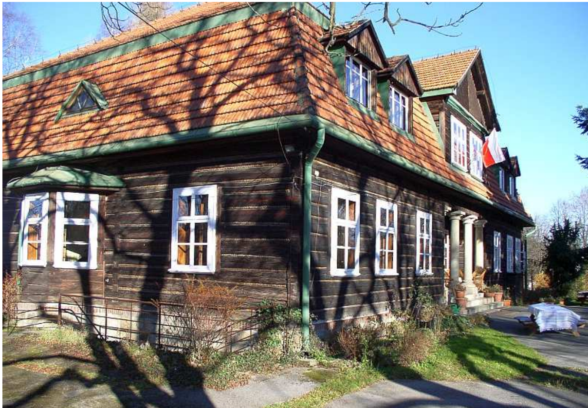
Fot. nr 77. Detale fasady dworu – stan po przebudowie w 1935-tym roku. (listopad 2010)
