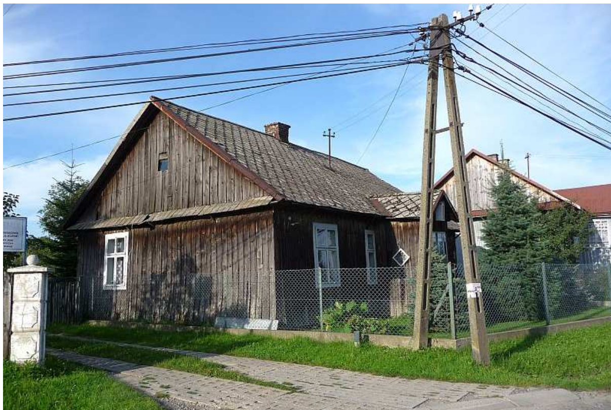
Fot. nr 120. Boczna część domu. (05.08.11)
