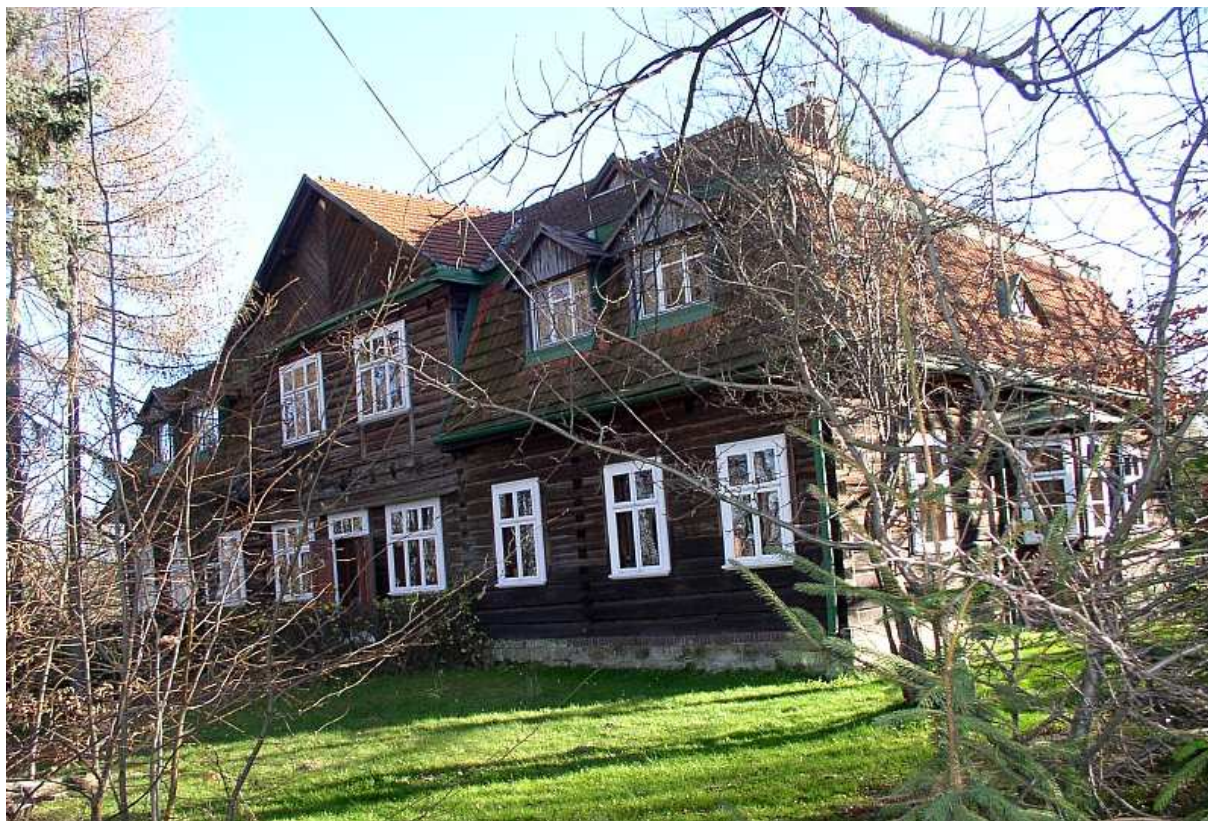
Fot. nr 78. Tylna część obiektu. (listopad 2010)
