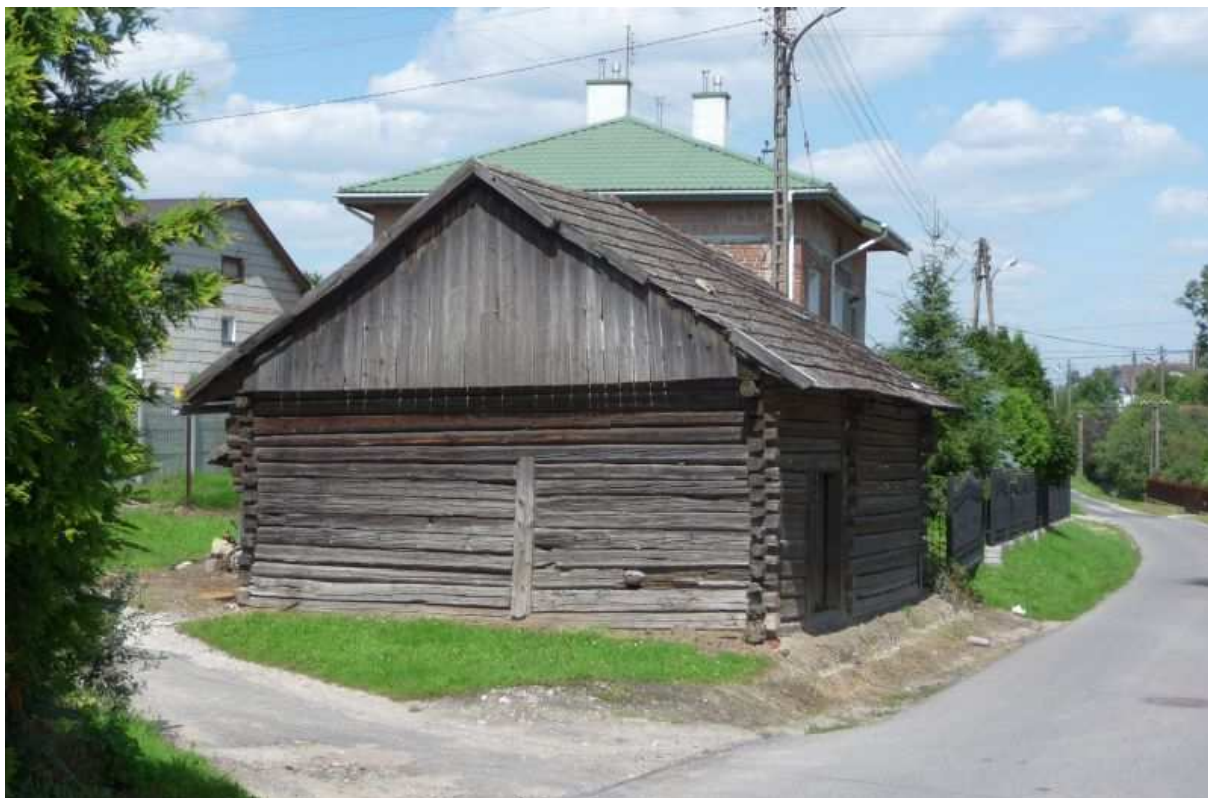
Fot. nr 112. Budynek gospodarczy z Małej Strony. (05.08.11)
