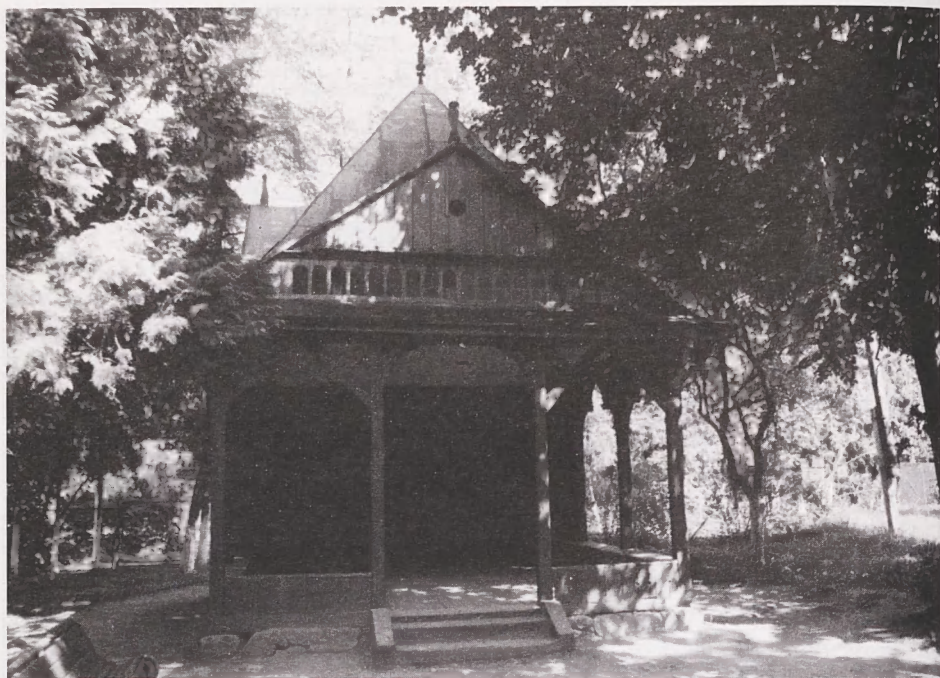
35. Altana w Zakładzie Przyrodolecznym A. Tarnawskiego. (fot. I. Marciszuk, 1997)
