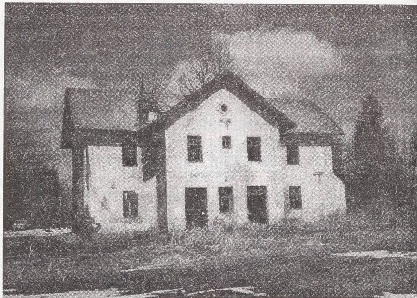
Budynek stacji kolejowej w Suchej Górze. Stan z marca 1998 r.
