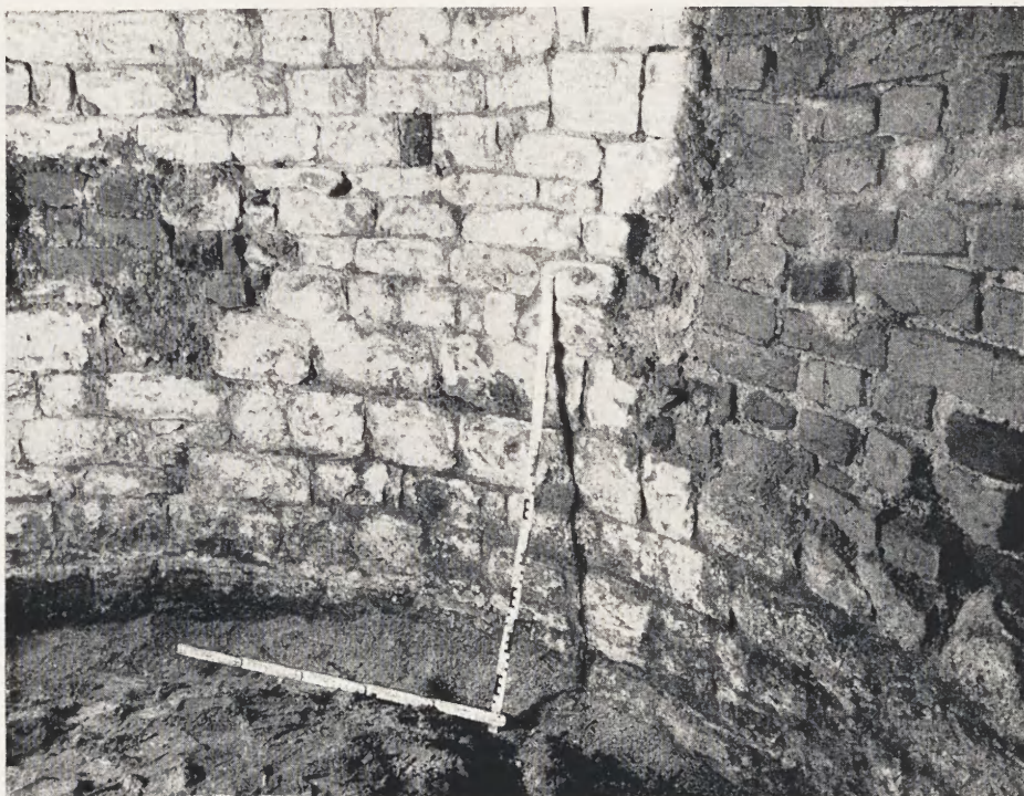
Fig. 55. Kościół Św. Jana. Wnętrze absydy z widocznym na osi przemurowniem okna
