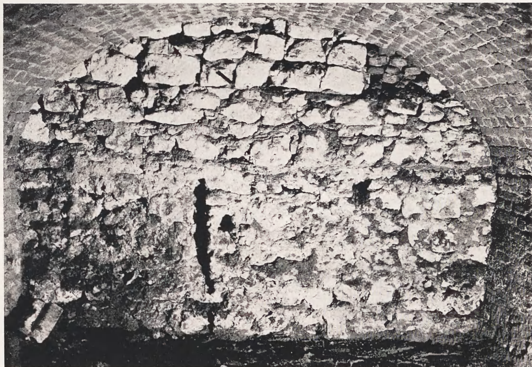
Fig. 73. Kościół św. Barbary. Krypta nr 1. Widok na ścianę wschodnią
