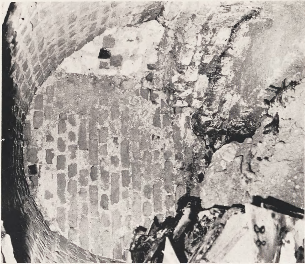
Fig. 62. Kościół Sw. Mikołaja. Krypta w południowo-wschodniej części kościoła z odkrytymi murami
