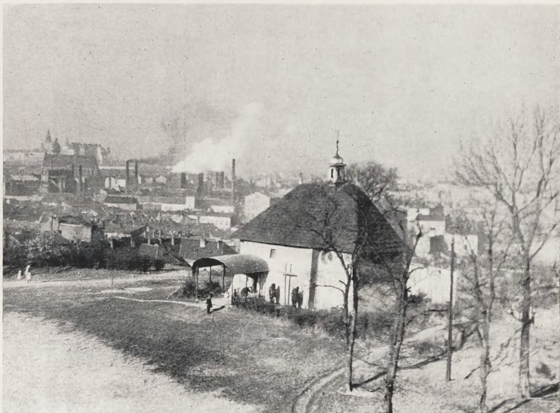
Fig. 33. Kościół Św. Benedykta. Widok od strony poł.-wschodniej
