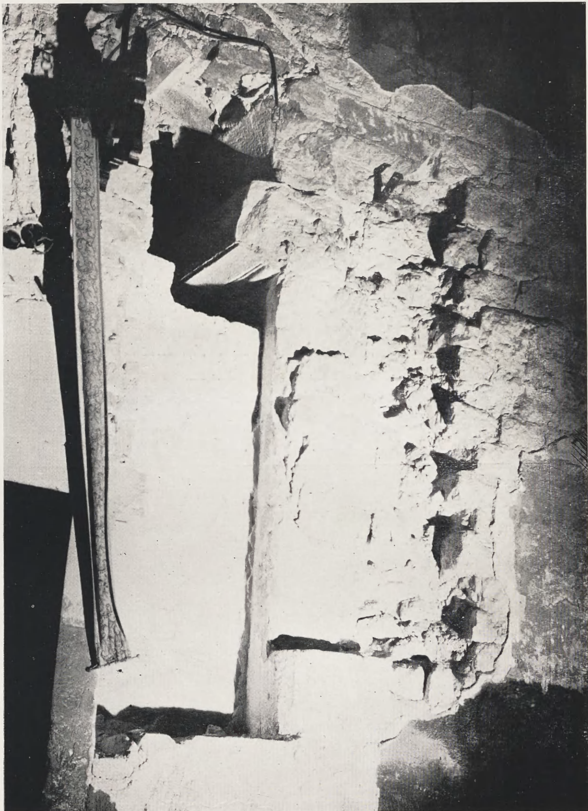
Fig. 18. Kościół Św. Salvatora. Prezbiterium. Odslonięta w czasie badań profilowana imposta romańskiego biforium
