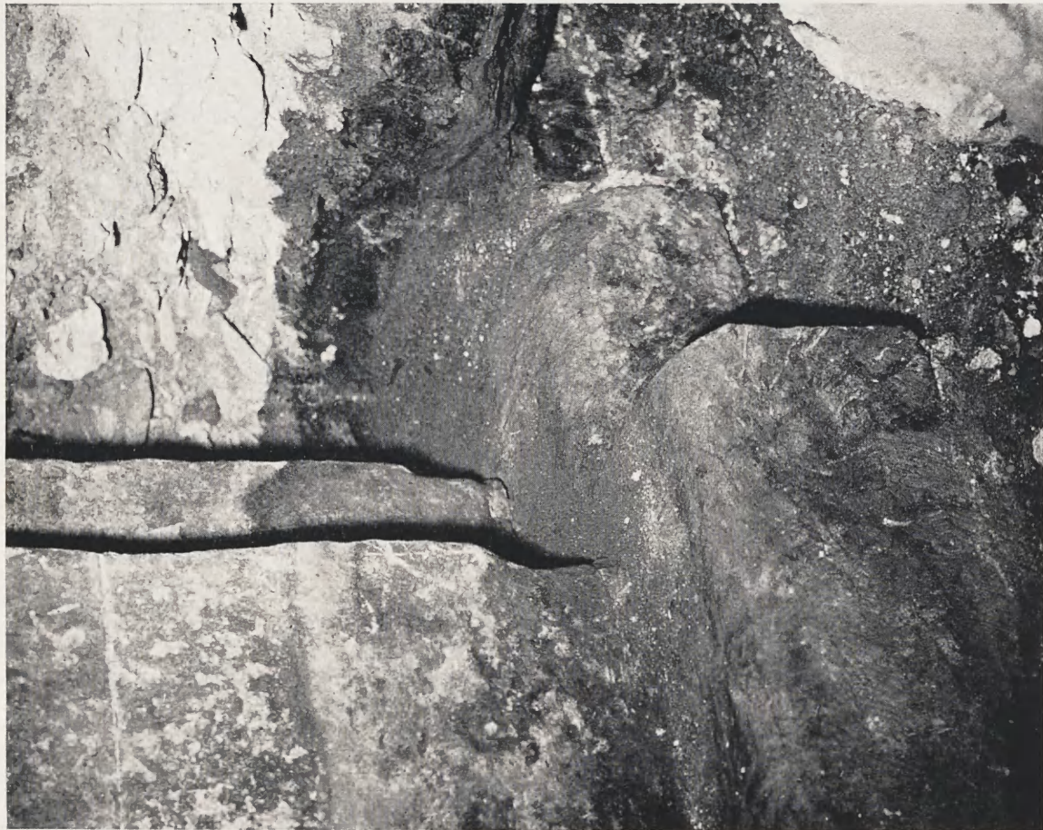
Fig. 47. Kościół Św. Andrzeja. Baza filara krzyżowego nawy odsłonięta w trakcie prac badawczych
