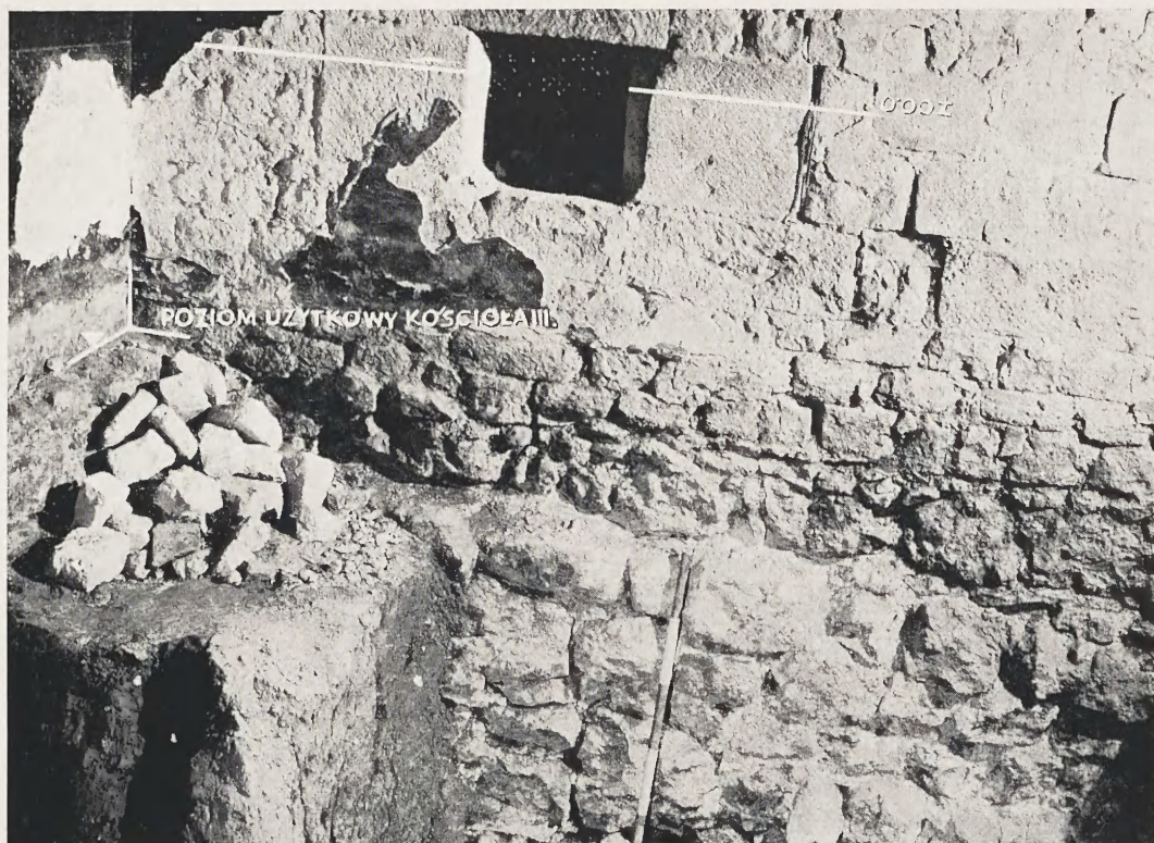
Fig. 19. Kościół Św. Salvatora. Prezbiterium. Wątek muru ściany południowej. Widoczny na zdjęciu poziom użytkowy XII-wiecznej fazy rozwoju budowli salvatorskiej
