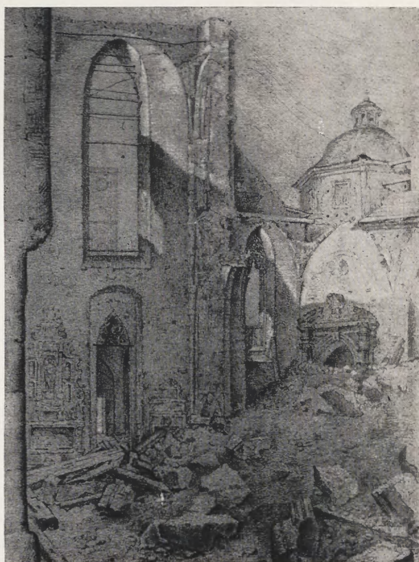
Tabl. 2. M. Cercha, Wnętrze kościoła Dominikanów po spaleniu
