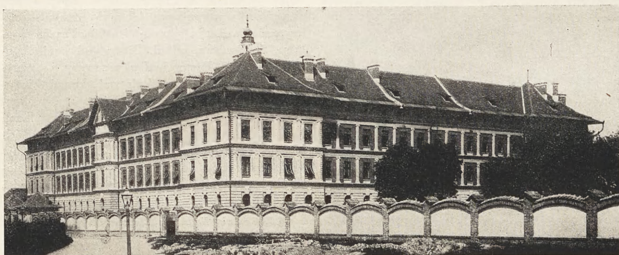
Fig. 18. Zakład im. Helclów w Krakowie. Fasada główna i wschodnie skrzydło budynku
