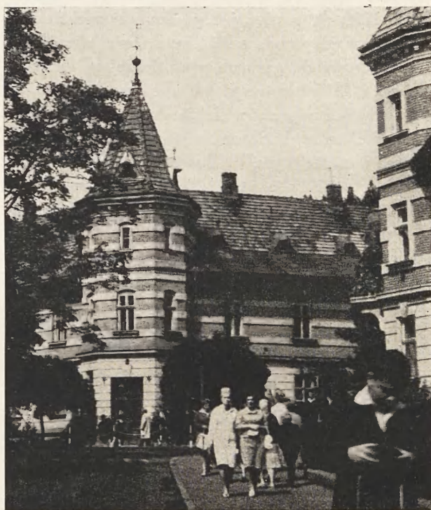
Fig. 24. Dom „Pod Koroną” w Krynicy przy ul. Pułaskiego i Al. Nowotarskiego. Fasada narożnikowa
