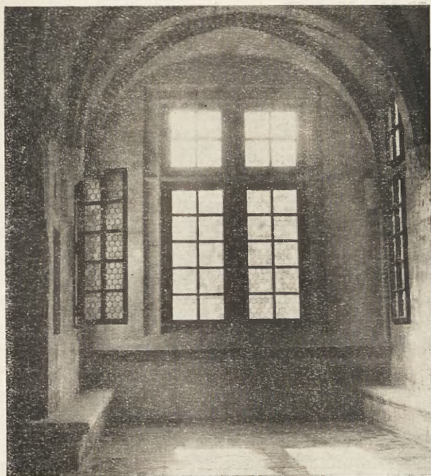
Fig. 2. Sala z wykuszem w wieży ratuszowej w Krakowie zbudowana w XIV w.
