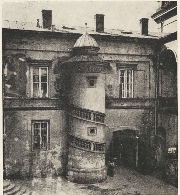
Fig. 14. Dom Towarzystwa Wzajemnych Ubezpieczeń w Krakowie przy ul. Basztowej 8. Realizacja fasady od strony dziedzińca
