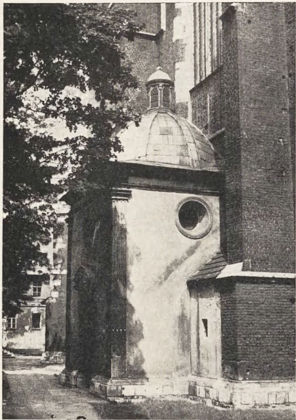
25. Zachodnia kruchta kościoła Bożego Ciała zbudowana około r. 1530
