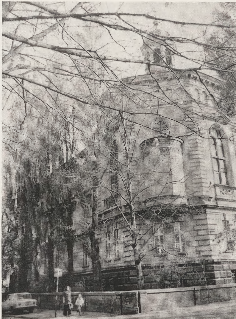
1. Dom Towarzystwa Dobroczynności na Stradomiu. Arch. K. Zaremba 1881
