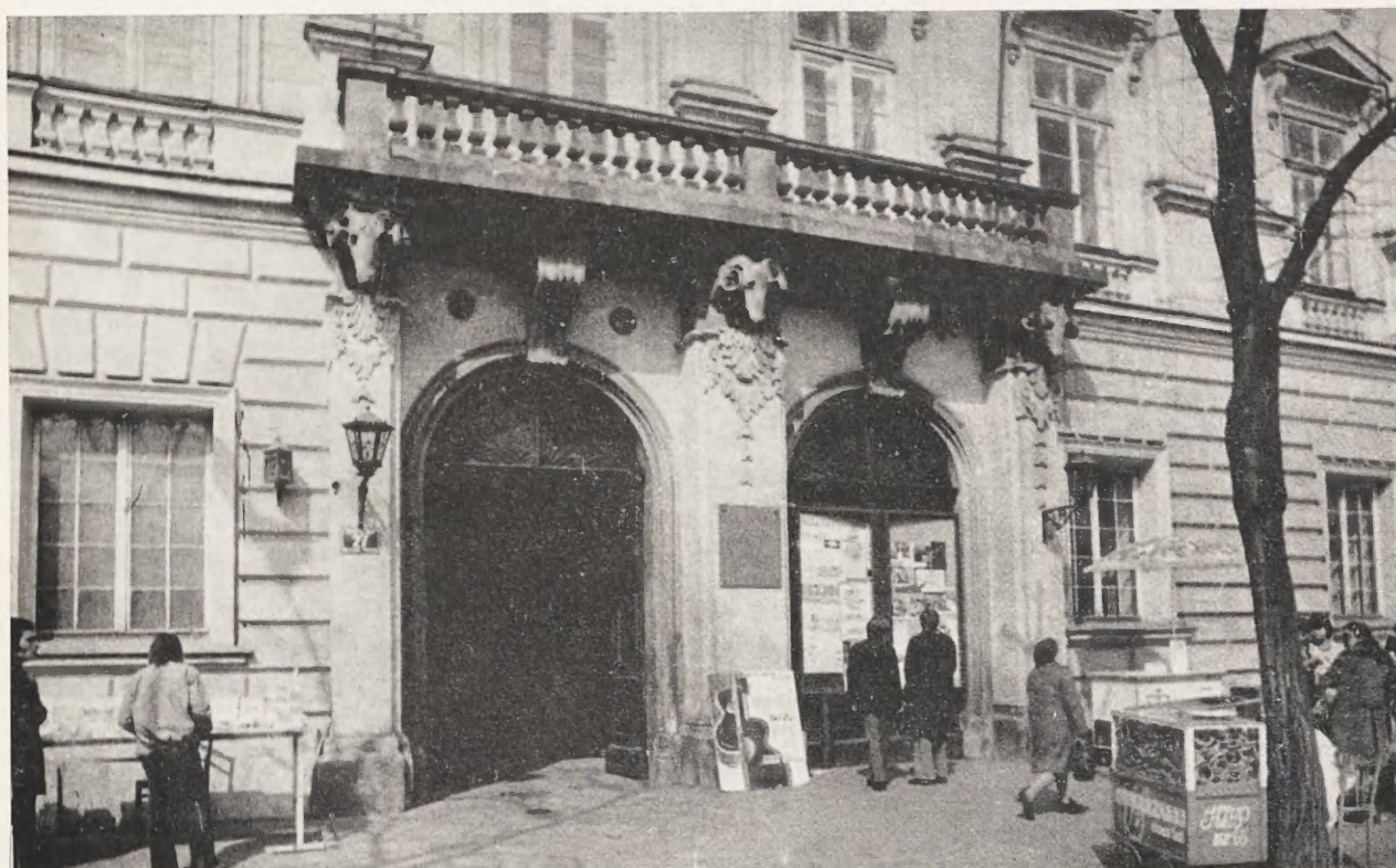
5. Wejście do pałacu Pod Baranami
