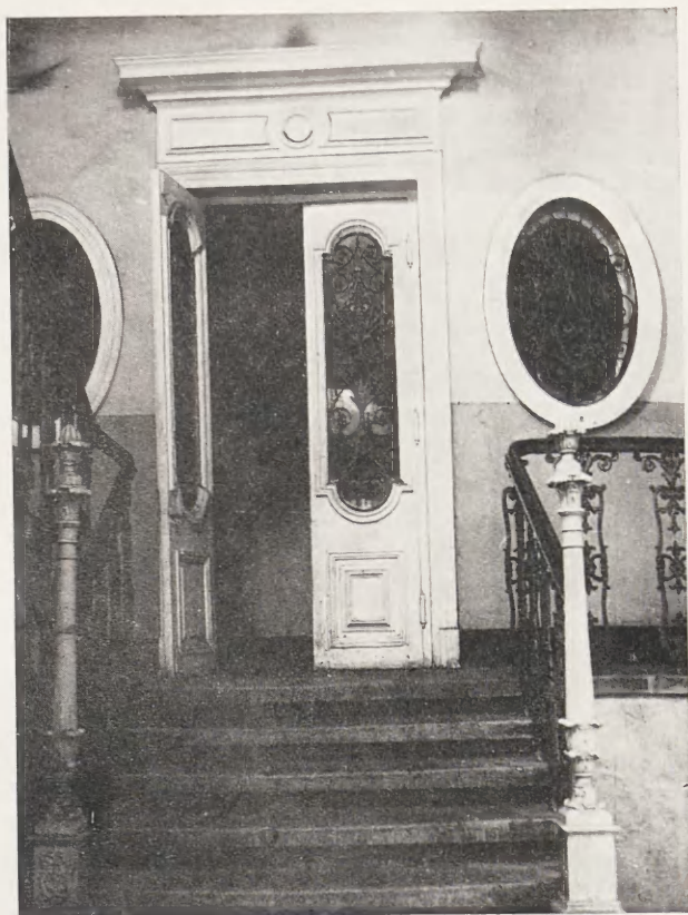
4. Wejście na parterze
