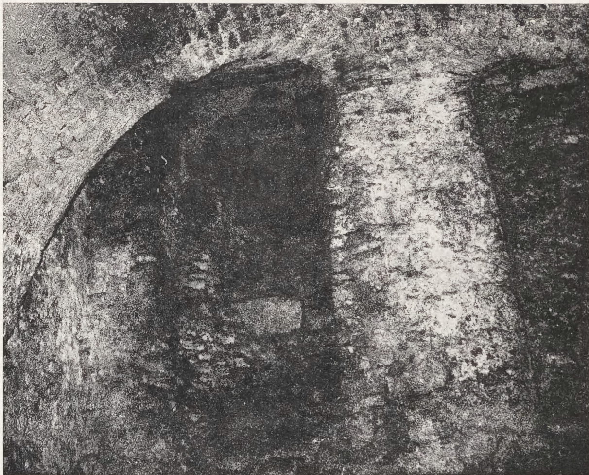
Piwnica pod sienią domu Wita Stwosza. Wnęka w murze — niegdyś wejście
