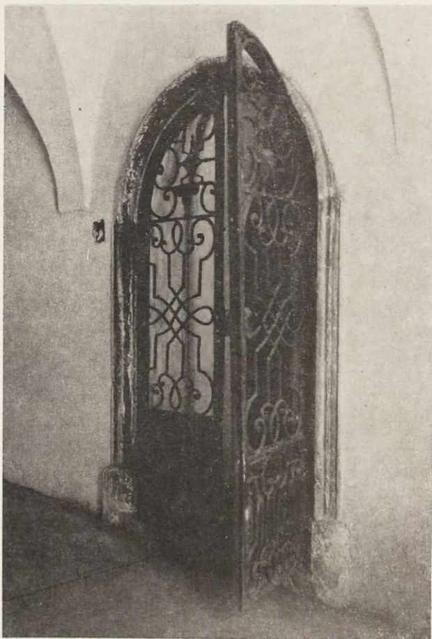
18. Wejście na schody w domu Kołłątaja w Krakowie przy ul. Św. Jana 20
