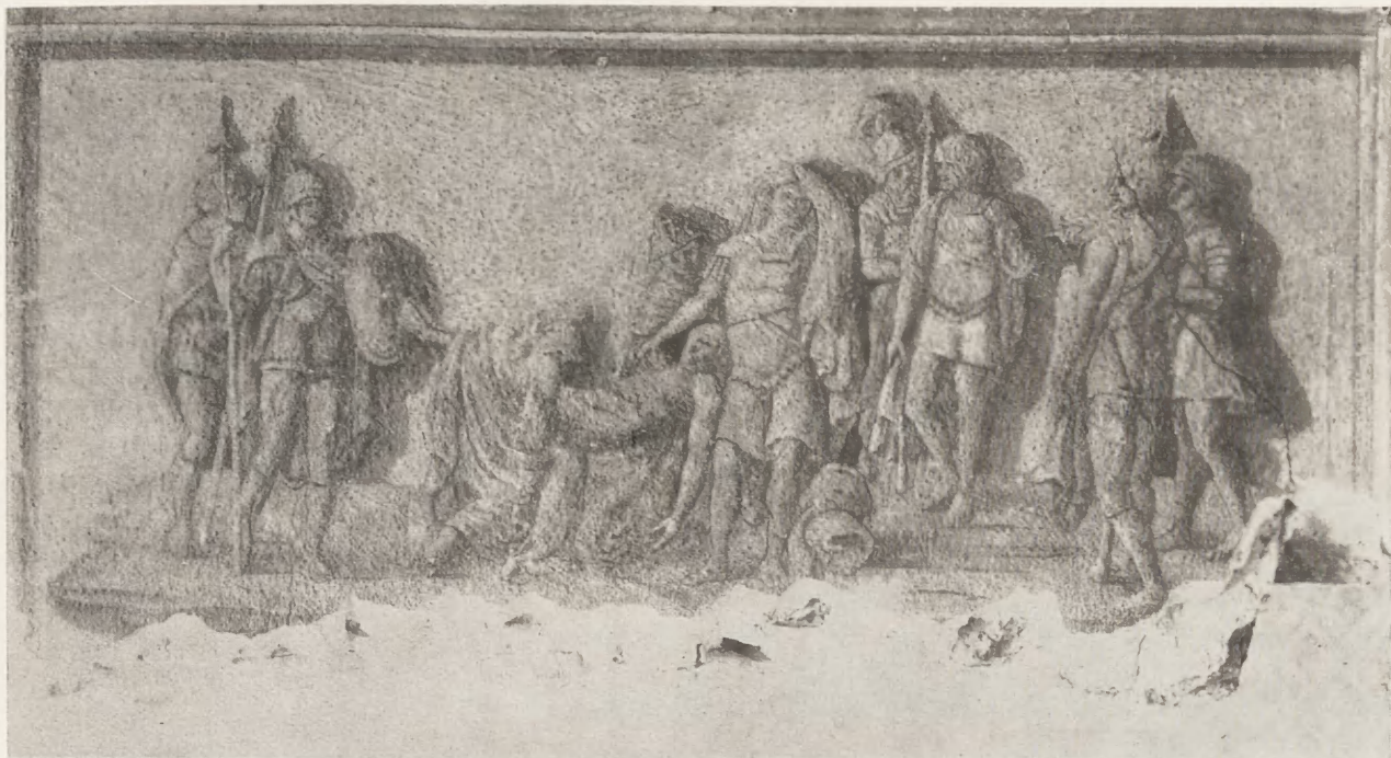
8. Pogrzeb Hektora. Nieistniejąca dekoracja ścienna D. Estreichera w jego domu przy placu Szczepańskim 2. Fot. z r. 1909
