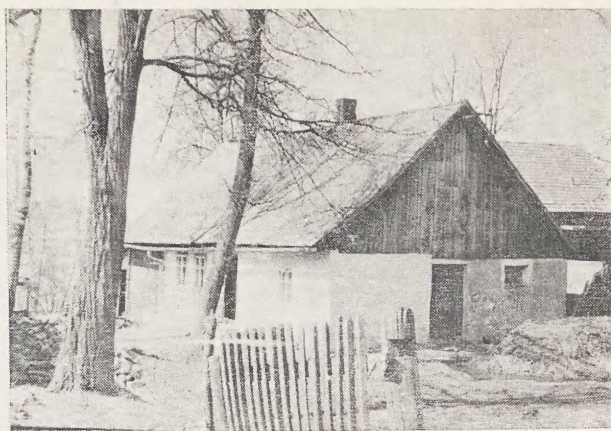
Rys. 7. Chata z wozownią i stajnią pod jednym dachem
