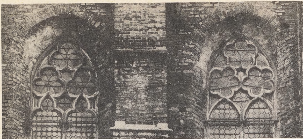
1. Kraków, kościół Dominikanów, okna w południowej ścianie prezbiterium: maswerk po lewej — sprzed połowy w. XIII, maswerk po prawej — druga połowa w. XIII
