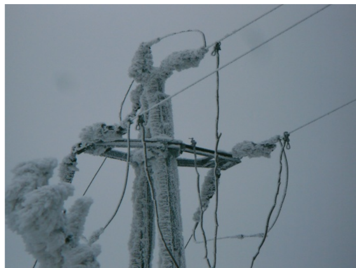
Ciężaru szadzi i lodu nie wytrzymały linki energetyczne
