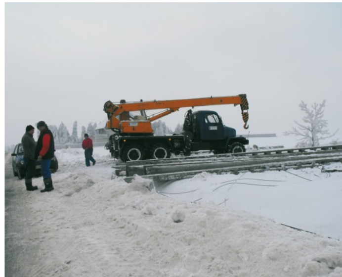
Ekipy remontowe Enion prowadzą prace w dzień i w nocy
