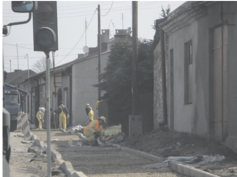
Remont idzie błyskawicznie, jaki będzie efekt?
