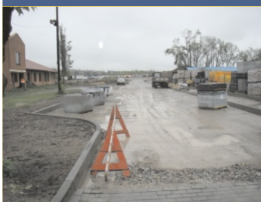
Nowa droga na targ czeka na asfalt - str. 2.
