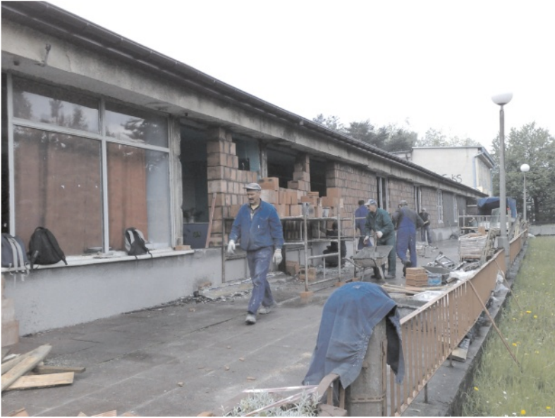
Okna w części CK już wymienione
