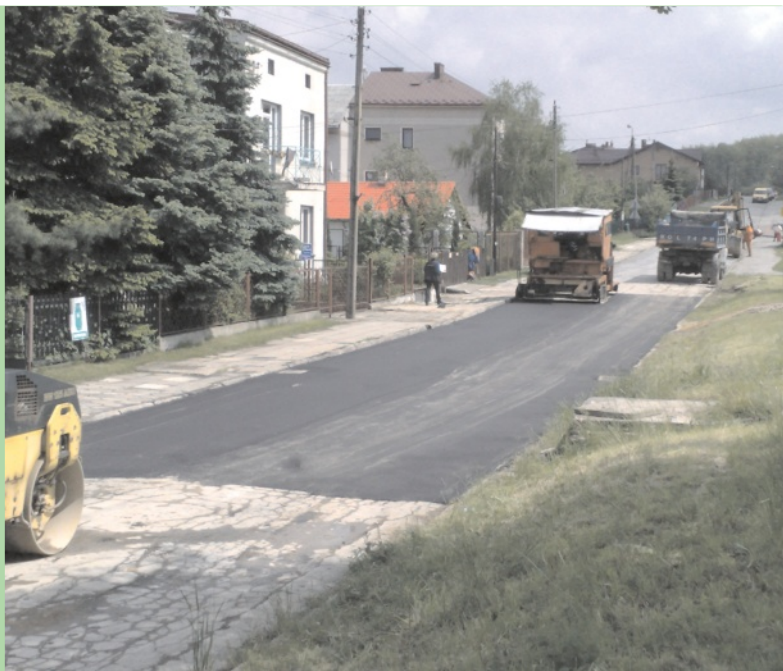
Dziury zniknęły pod nowym asfaltem na części ul. Leśnej
