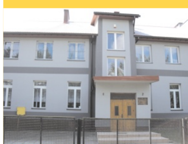
Dzieci na wakacjach – szkoły do remontu - str. 7.
