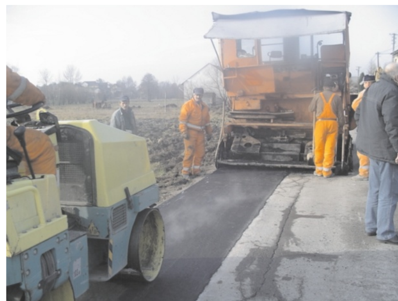
Remont drogi w Dłużcu. Każdy metr nowego asfaltu cieszy, ale i rodzi nadzieje na więcej
