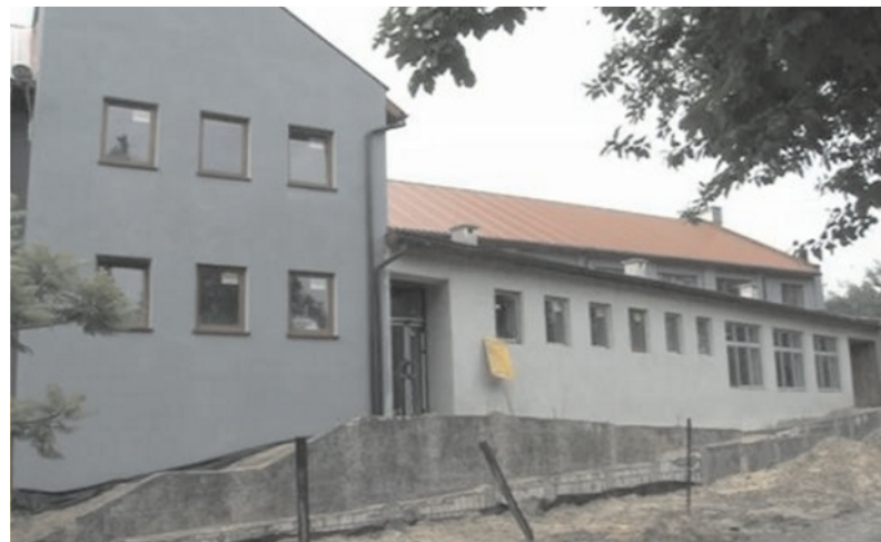
Prace przy sali jeszcze trwają, ale efekty już cieszą
