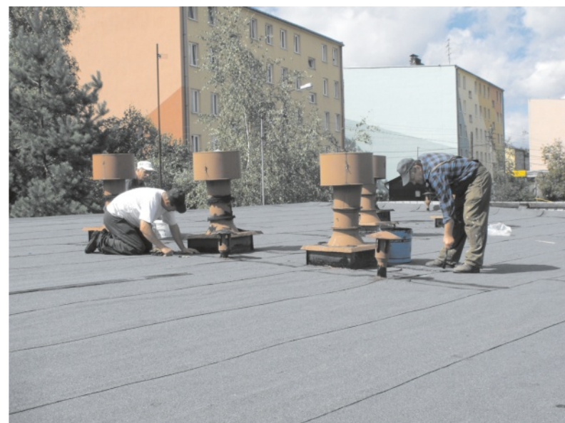
Dach nad PP 2 już nie powinien przeciekać
