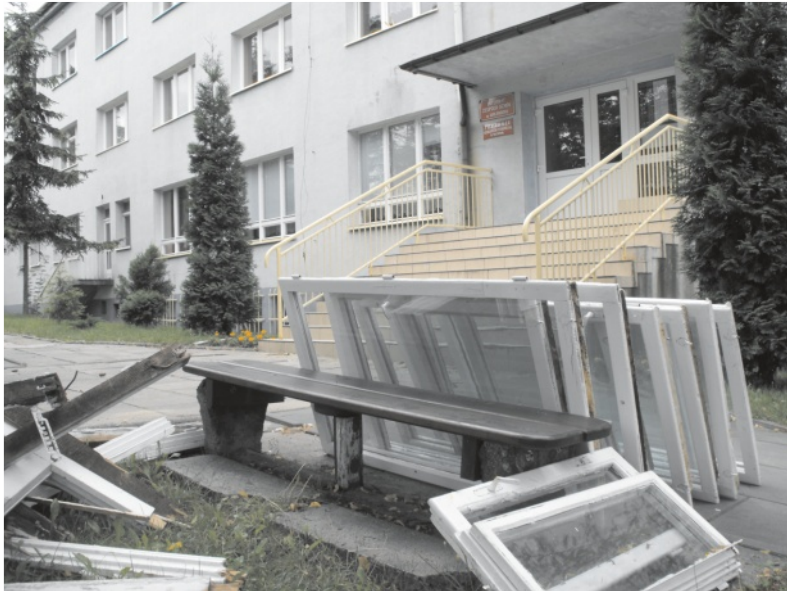
W budynku przy Skalskiej remonty prowadziły obie szkoły - gimnazjum nr 3 i ZS w Wolbromiu
