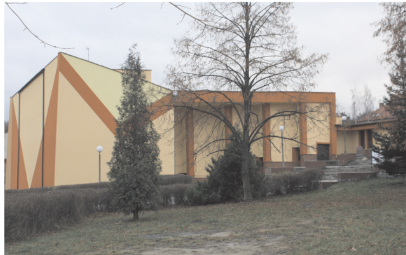
Centrum Kultury po remoncie
