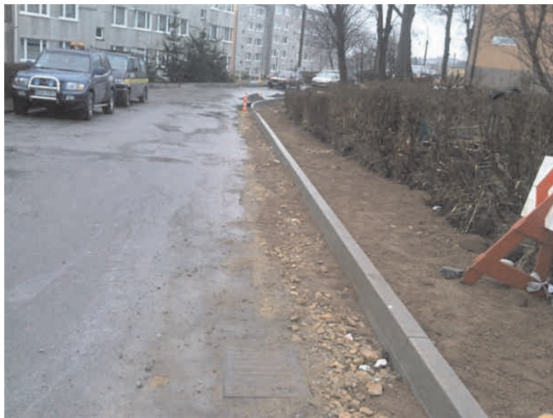
Budowa nowego chodnika na os. Chrobrego
