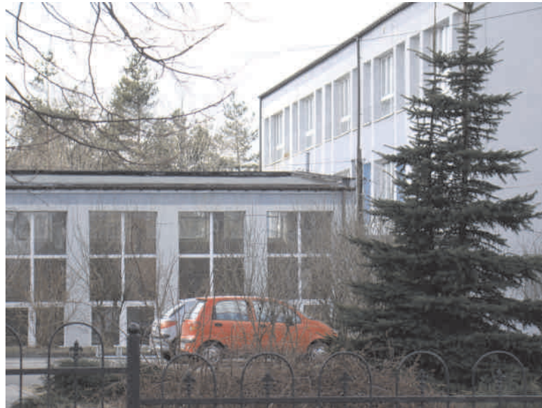
Zamiast budowy nowej sali będzie remont starej
