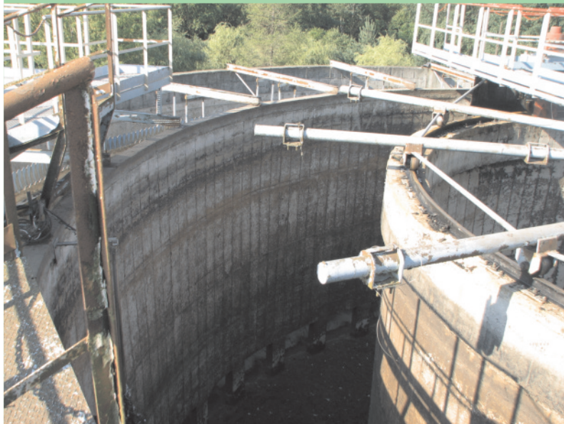
Remont reaktora BX 1 w oczyszczalni ścieków na skutek wystąpienia awarii (opróżnianie i oczyszczanie reaktora z osadów, odwadnianie osadów prasą, wywóz osadów do kompostowania, demontaż zniszczonej konstrukcji (kierownic i ramion podwieszonych), zakup i gięcie szyn kolejowych, remont torowiska, opracowanie koncepcji układu mieszania w komorze biostabilizacji; zakup, montaż i uruchomienie mieszadeł zatapialnych w ilości 4 szt. wykonanie części zamiennych pomostu obrotowego i pomp reaktora.
