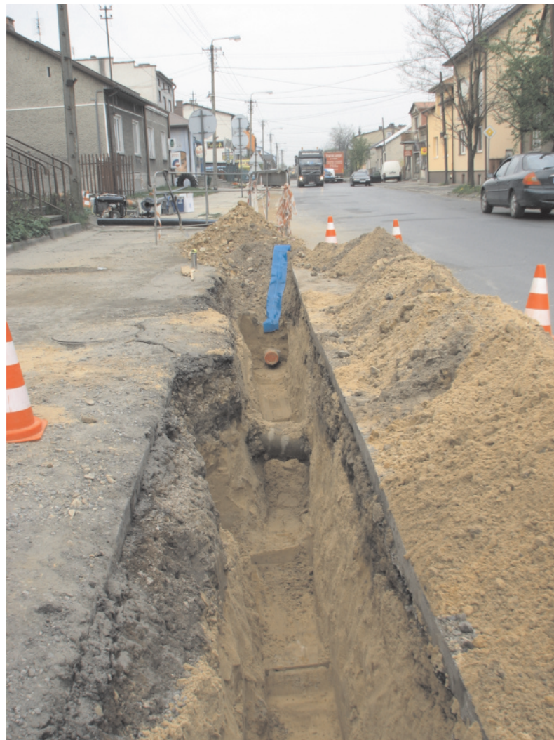
Wymiana 340 mb wodociągu Ø 160 mm PE wraz z 34 przyłączami na ul 1 Maja w Wolbromiu. Obecnie trwa budowa kanalizacji na części tej ulicy.
