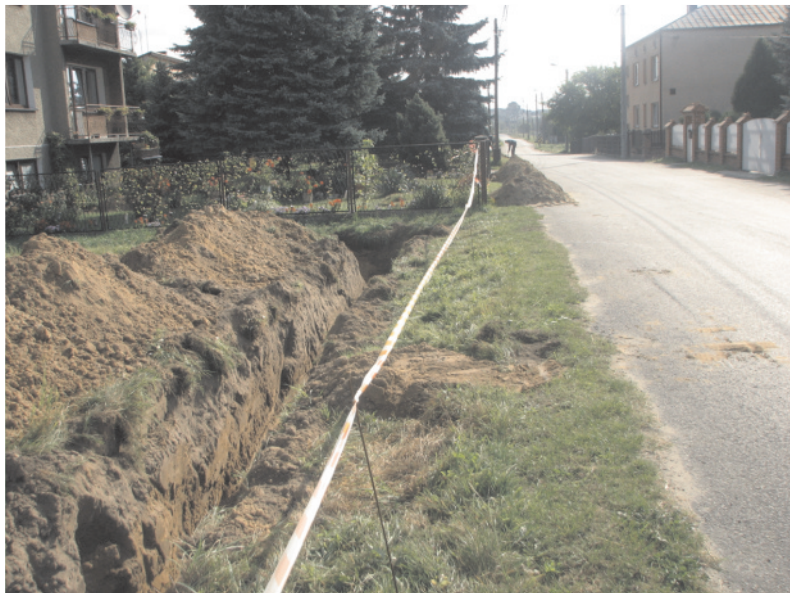
Zabagnie, kol. Radocha: wymiana 450 mb wodociągu Ø 75 mm PE wraz z 29 przyłączami
