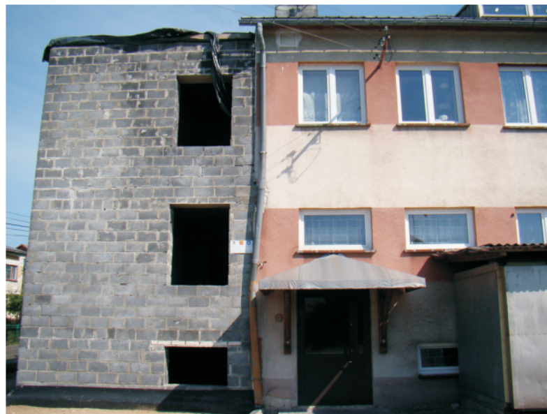
Remiza OSP w Gołaczewach - remont podzielony na kilka etapów finansowany był przy udziale środków zewnętrznych.
