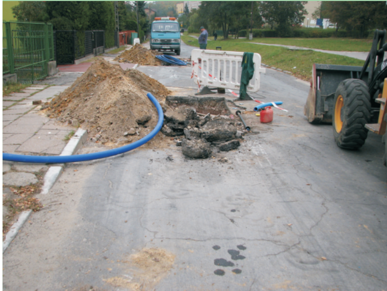
ul. Leśna- 228 mb wodociągu Ø 160 mm PE i 180 mb wodociągu Ø 75 mm PE wraz z 13 przyłączami
