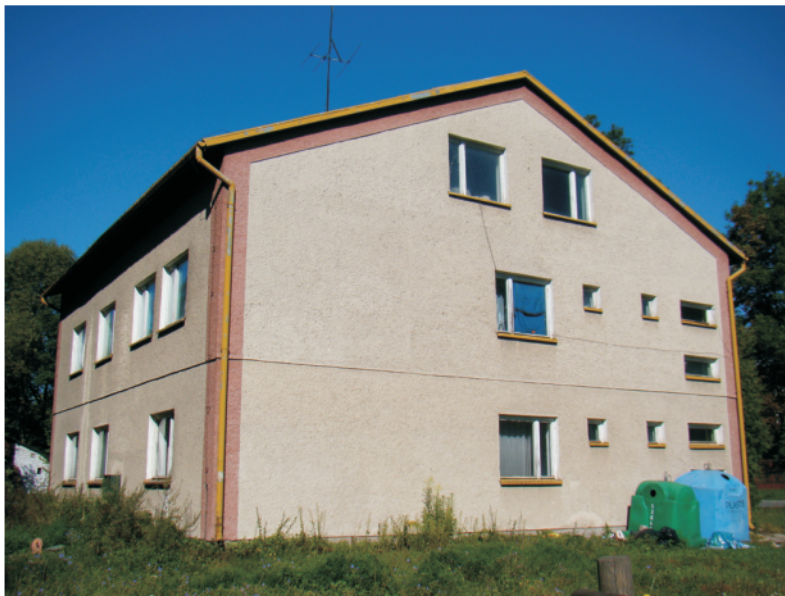
Budynek po byłej szkole w Sulisławicach zostanie wyremontowany na potrzeby OSP
