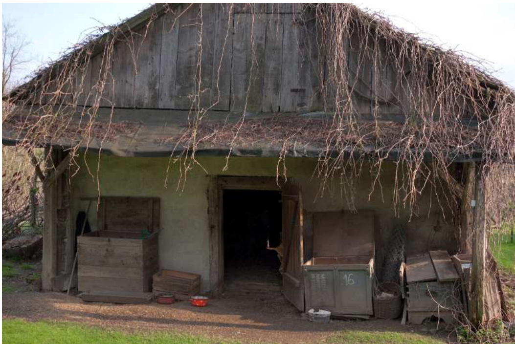
Fot. nr 156 (156-157). Nieistniejący już fragment dawnej chałupy Augustynków pod nr 81, z zachowanymi napisami na powale: „Fundatorowie Antoni Agustyniek i Maria żona” (z boku belki) oraz „RP 1853” (na jej spodzie).
