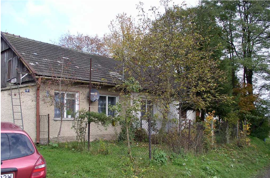
Fot. nr 133. Współczesny, smutny wygląd części frontowej domu Kędrynów.
