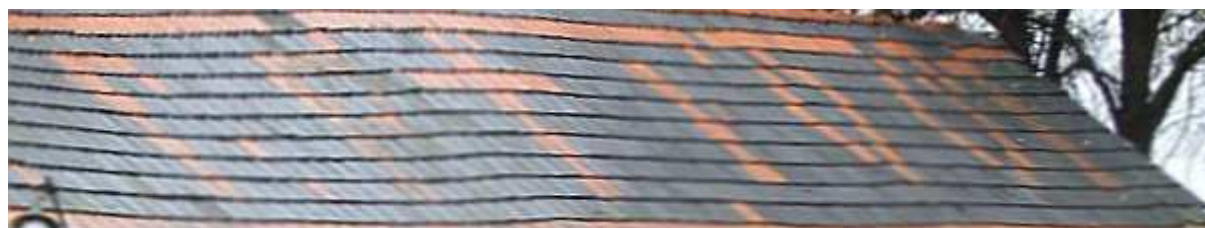
Fot. nr 276. Jeszcze kompletna mozaika dachówkowa z datą budowy domu: RP 1907 bądź 1901. (01.11.2008)
