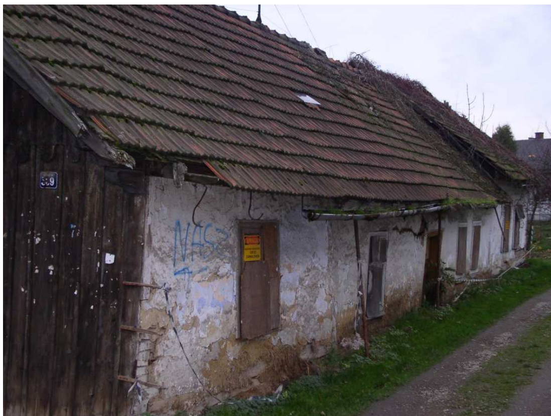
Fot. nr 29. Wiekowa, nieistniejąca już chałupa z ulicy Bocheńskiej.
