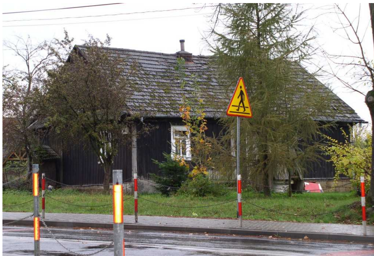
Fot. nr 18. Chałupa „Hergota” („Pakrysia”), wybudowana w 1905 roku – stan z 01.11.2008.
