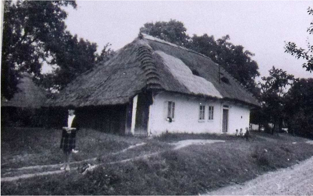
Fot. nr 160 (160-163). Chałupa mojej Babci – Bilczyce 43 – lato 1968. Zdjęcia przekazane mi przez Romana Markota. Widok od drogi w kierunku zabudowań Kędrynów.
