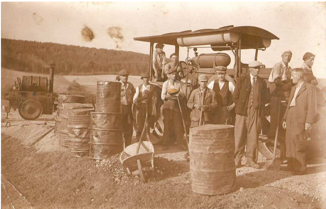
Fot nr 184. Zdjęcie robotników pracujących przy przebudowie budowie drogi (gościńca gdowskiego) na wysokości na Krzyżowej w Bilczycach. W tyle Las Jawecki. Mój ojciec siedzi przy kierownicy, poniżej z łopata stoi Józef Bogda, jego ojczym, którego nazywał Józkiem. Wg Romana Markota zdjęcie musi pochodzić z okresu okupacji, kiedy Niemcy prowadzili tu przebudowę, co jest o tyle wątpliwe, że ojciec został schwytany w łapanie w styczniu 1940. Zatem albo jest to późna jesień 1939 bądź początek 1940-go roku, albo, co mniej prawdopodobne, pierwsze lata powojenne.
