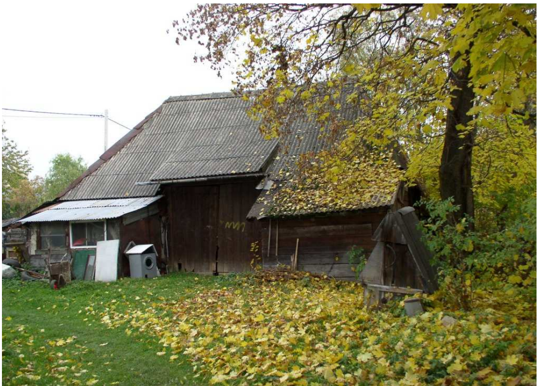
Fot. nr 134. Stodoła Kędrynów (do roku 1934 Grabowskich) – widok od strony podwórka.
