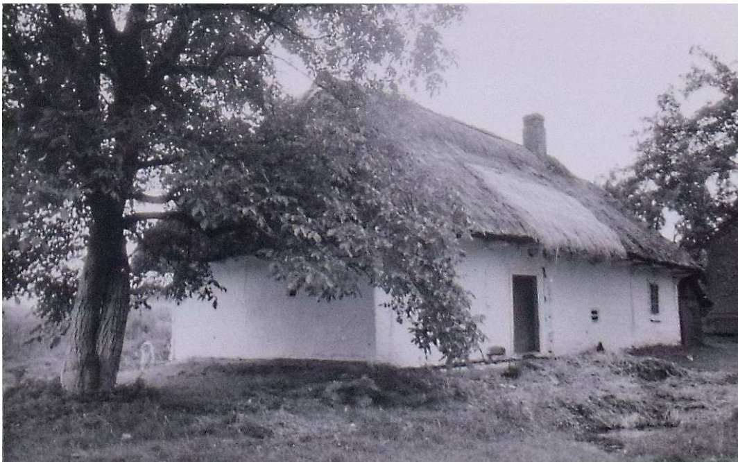
Fot. nr 163. Widok od strony ogrodu. Z lewej orzech, z prawej resztki gnojowicy. Obok drzwi widoczny odpływ gnojówki z dawnej stajni.
