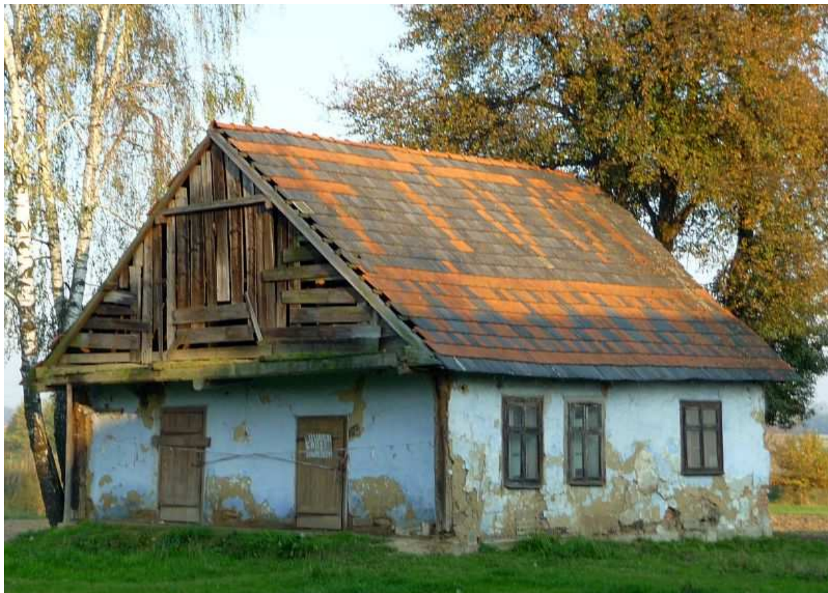
Fot. nr 277. Stan z 22.10.2012. Część gospodarcza z lewej strony, dodatkowo z sienią oraz szopa zostały już usunięte.
