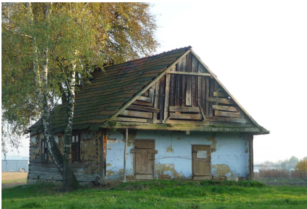
Fot. nr 282. Wygląd tylnej części po rozbiórce: sieni, części gospodarczej i szopy. Na pierwszym planie drzwi wejściowe z dawnej sieni. (22.10.2012)
