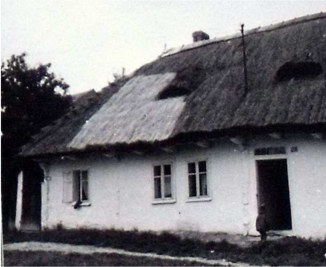
Fot. nr 162. Fragment części mieszkalnej. Pierwsze dwa okna z prawej przynależały do pomieszczenia kuchennego (czarnej izby), ostatnie okienko (z lewej) do wyłożonej podłogą izdebki (białej izby).
