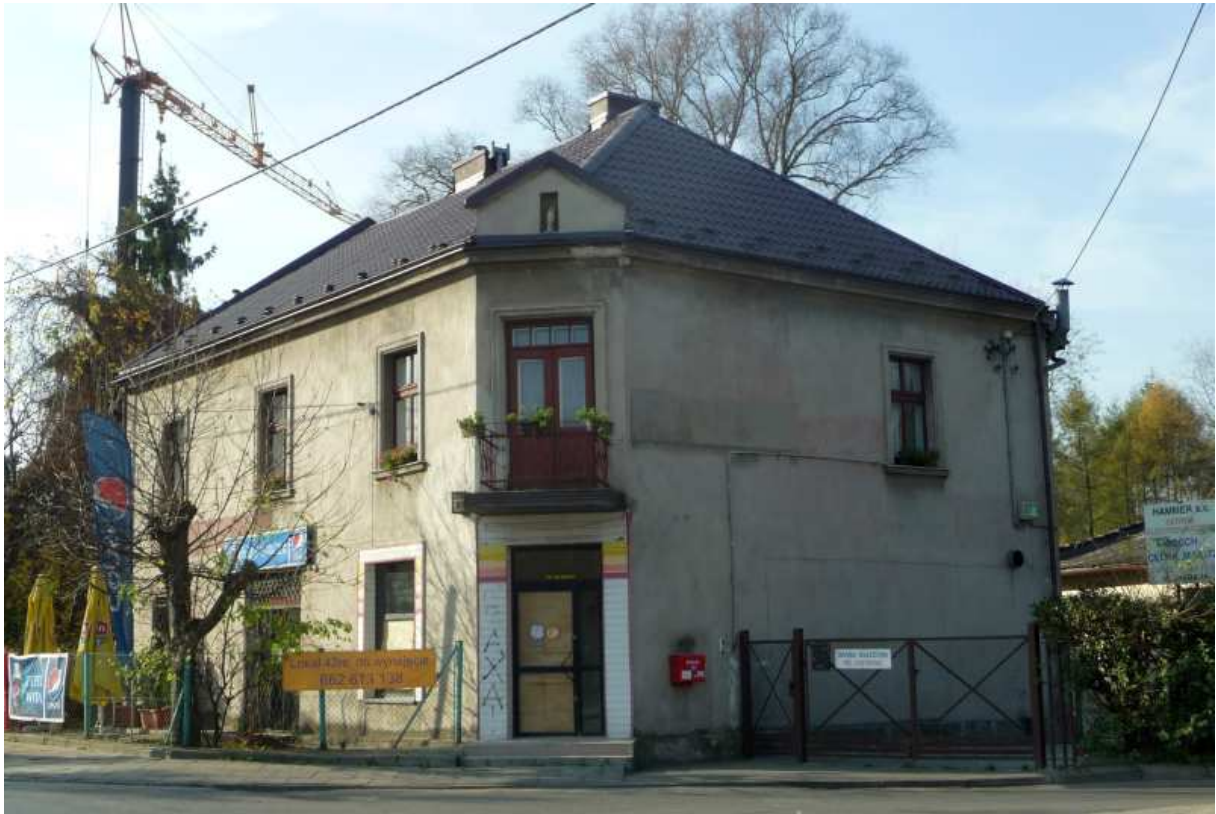
Fot. nr 1 (1-2). Zapewne międzywojenny budynek z naroża ulic: Malborskiej 34 i Dauna. (01.11.13)
