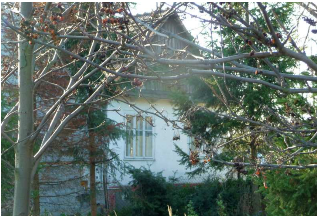
Fot. nr 38 (38-39). Boczna ściana od strony posesji pod nr 249. (29.10.13)
