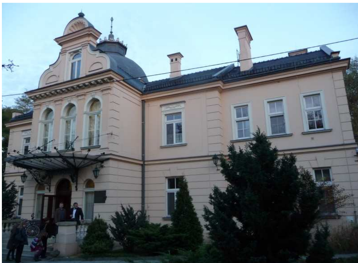
Fot. nr 67 (67-69). Pałac Wodzickich-Grodzickich-Jerzmanowskich – część od strony ogrodu z wejściem przebudowanym za czasów Józefa Grodzickiego. (20.10.13)
