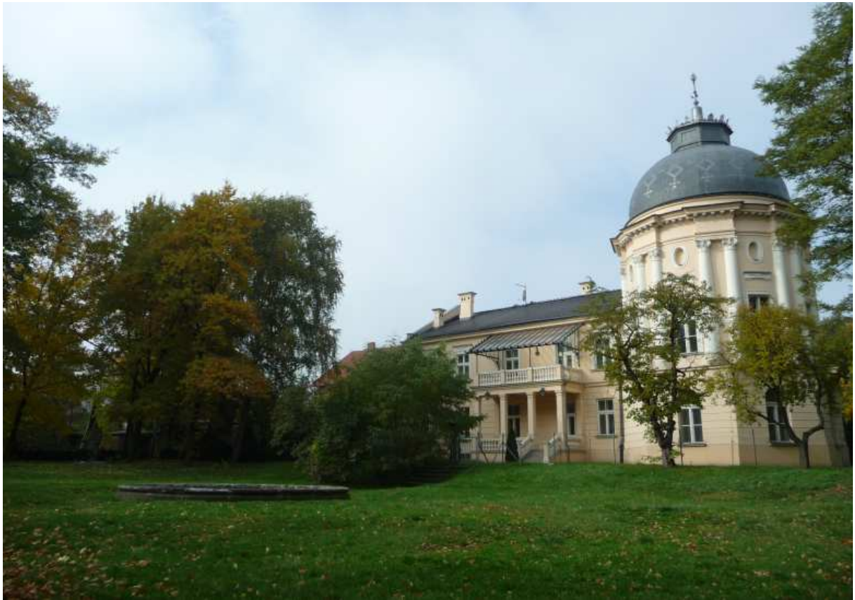
Fot. nr 68. Fasada pałacu od strony parku. (13.10.13)
