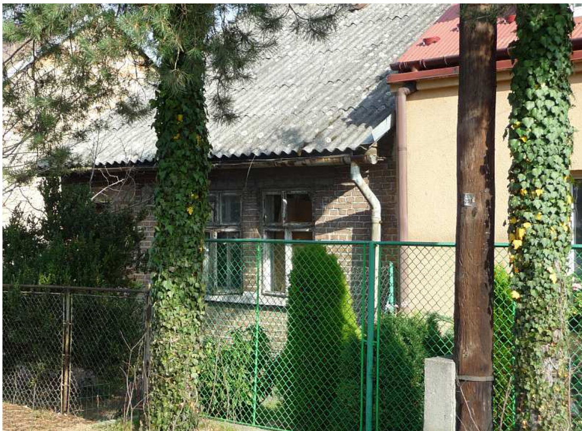
Fot. nr 15 (15-17). Ruina podmiejskiego oryginału z ulicy Szkolnej 13. (01.11.13)
