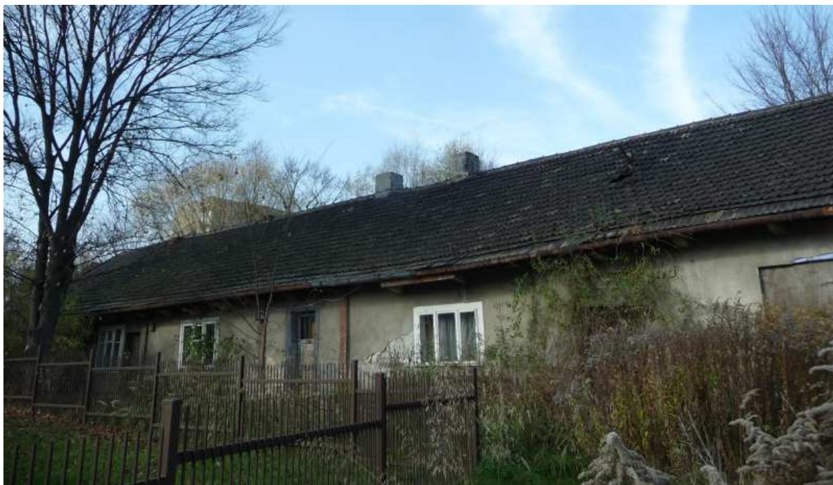
Fot. nr 23. Bliski oryginałowi podmiejski dom, który do dziś zachował wiele oryginalnych detali. (01.11.13)
