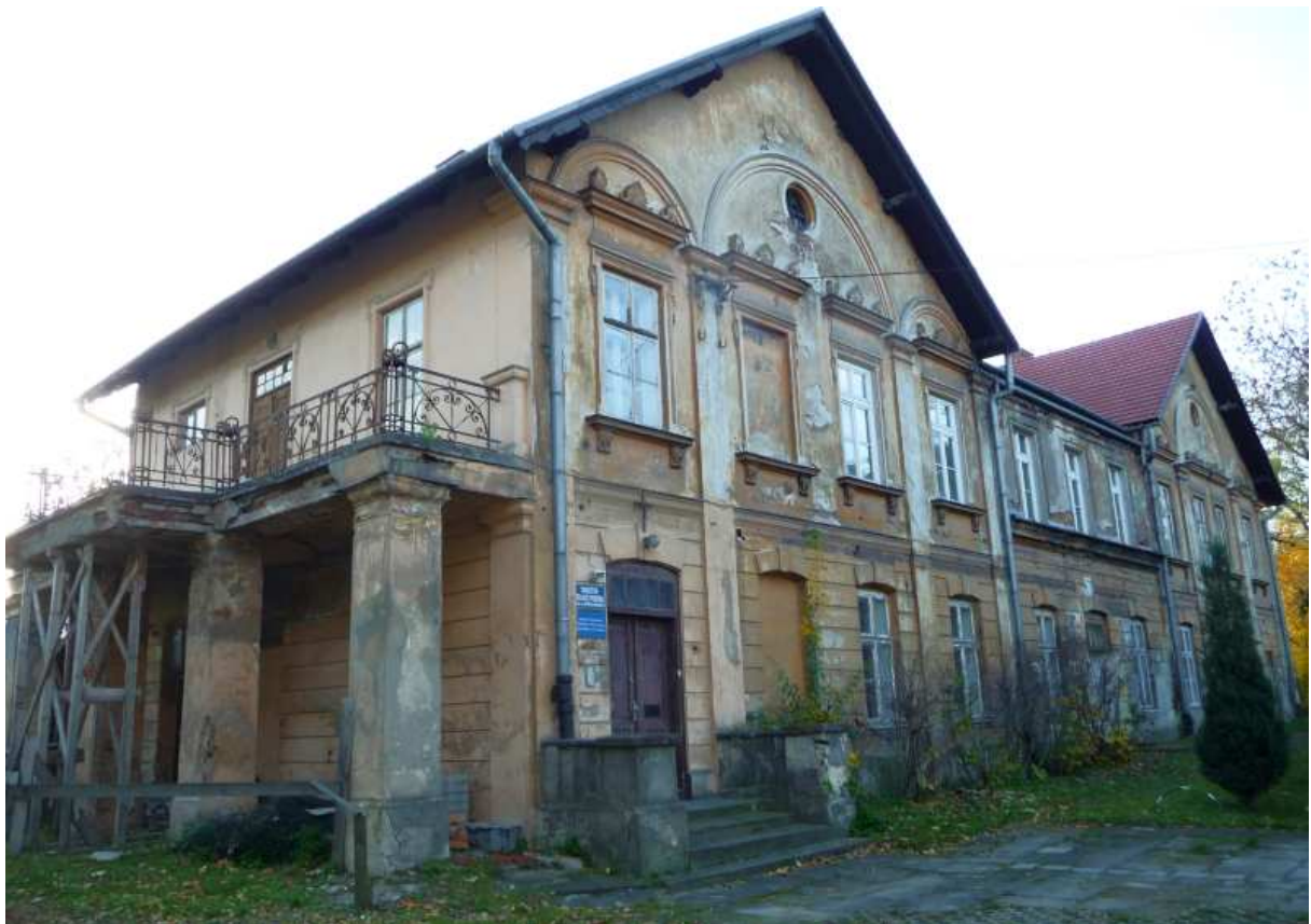
Fot. nr 65. Widok od strony ogrodu. (20.10.13)
