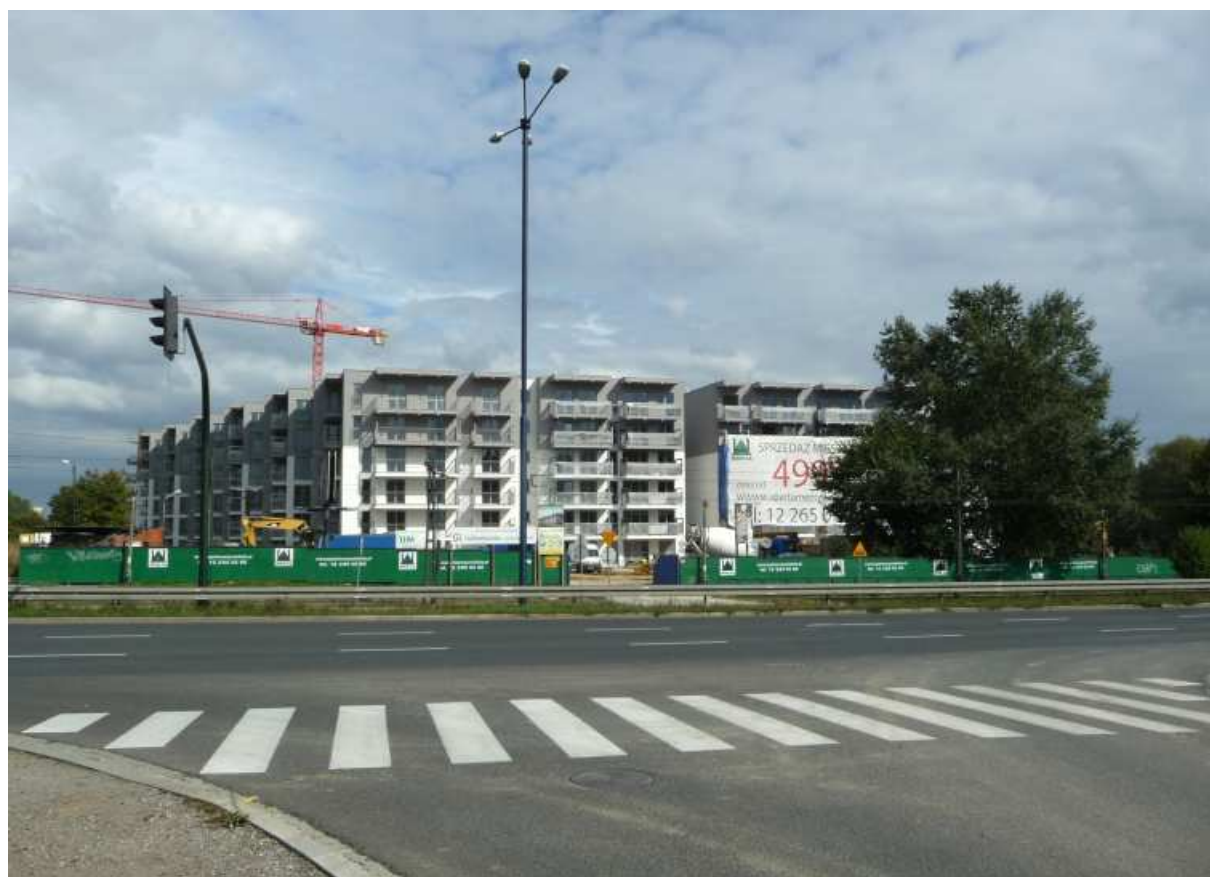
Fot. nr 42 (42-43). Ujęcie z wylotu ulicy Facimiech. (01.10.13)
