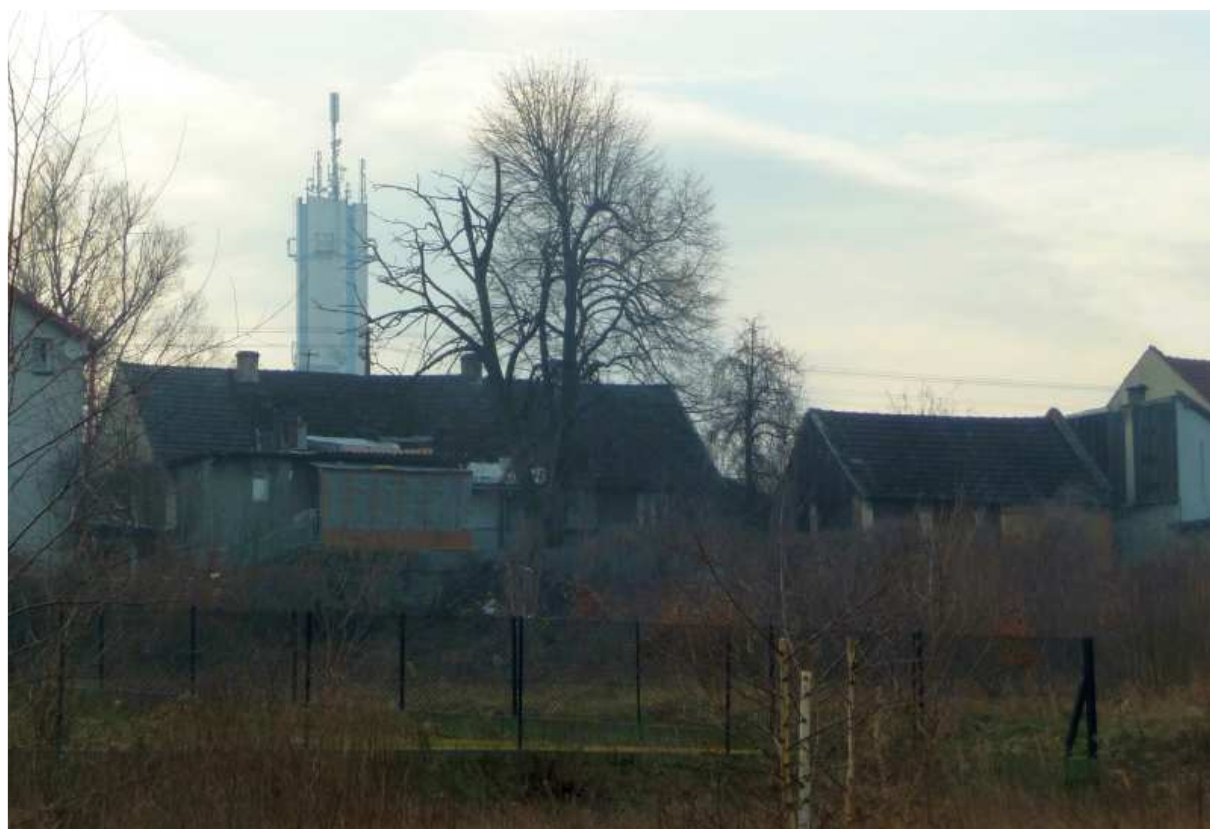
Fot. nr 174. Z wieżą rurociągu Raba w tle. (17.01.14)
