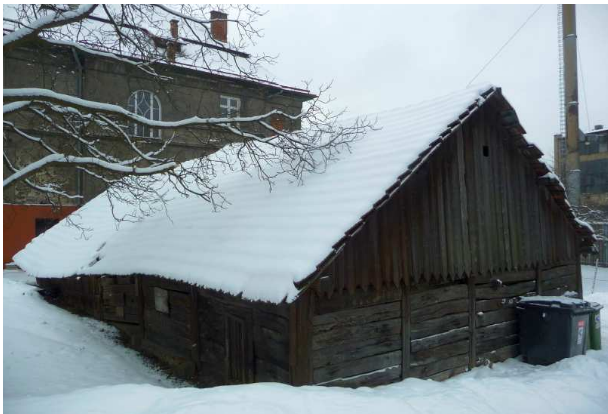
Fot. nr 57 (57-58). Budynek gospodarczy z ulicy Kolejowej 2 – widok od strony ulicy Braci Gierymskich. (28.01.14)
