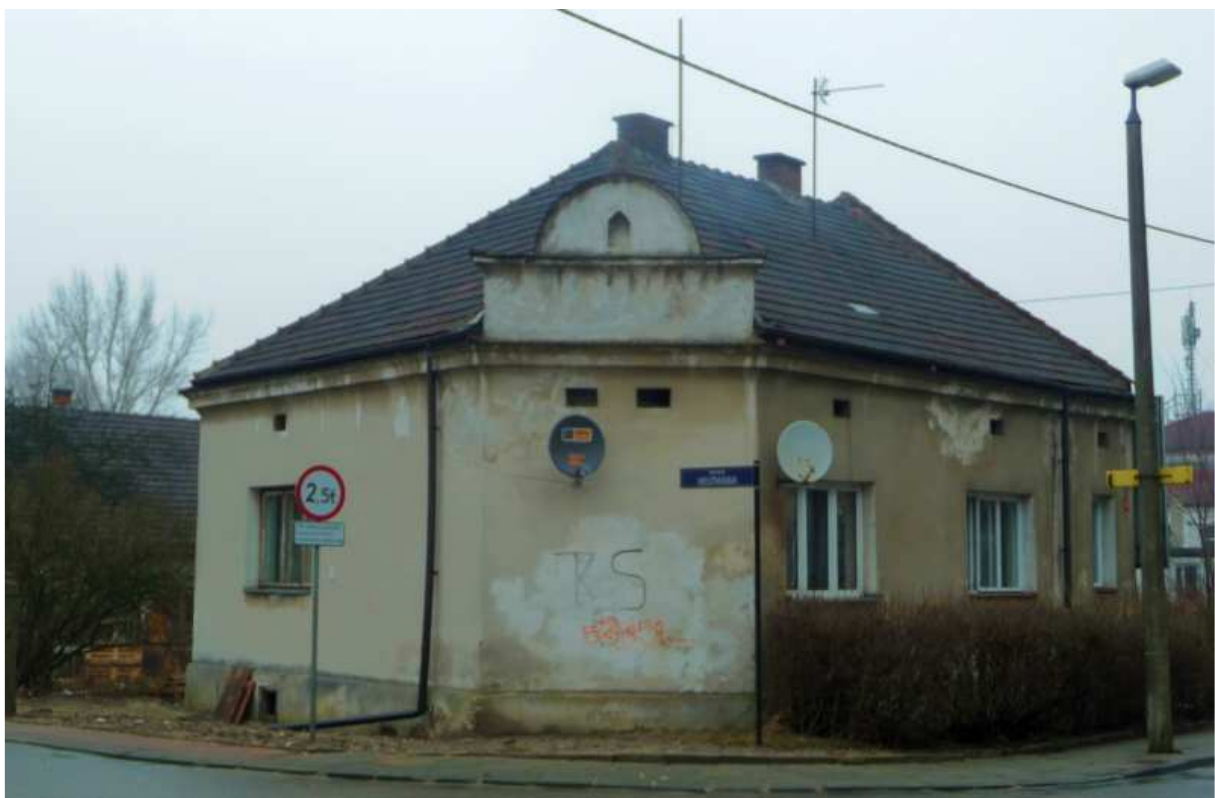
Fot. nr 36. Zamurowane, dawne pomieszczenie sklepowe bądź usługowe w narożu ulic: Malborskiej (nr 52) i Heltmana. (19.01.14)
