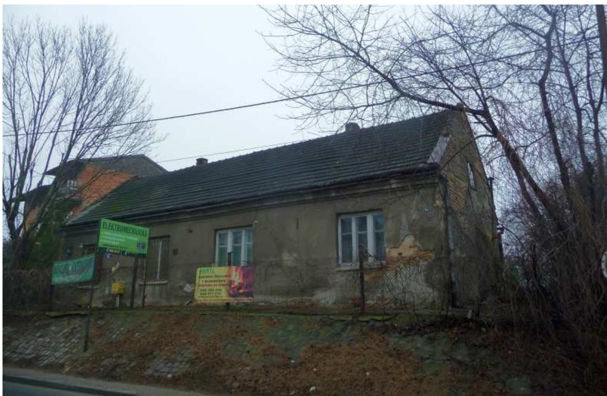
Fot. nr 34. W klimacie przedwojennych Piasków – podmiejski domek z ulicy Malborskiej 84. (19.01.14)
