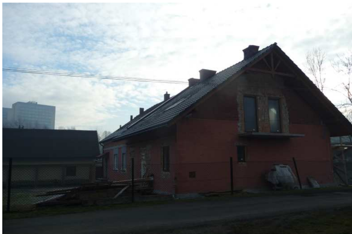
Fot. nr 147. Właśnie trwa przebudowa międzywojennego domu. (03.01.14)
