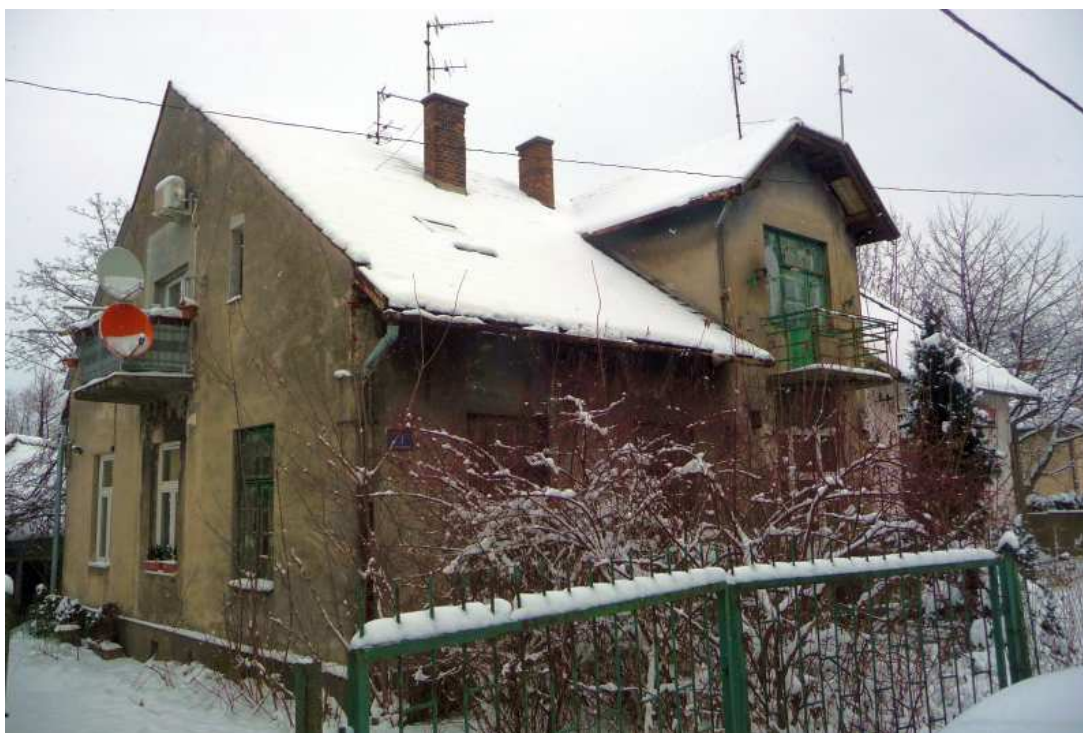
Fot. nr 50 (50-51). (Kiedyś) modernistyczna willa z Alei Dygasińskiego 3. (28.01.14)
