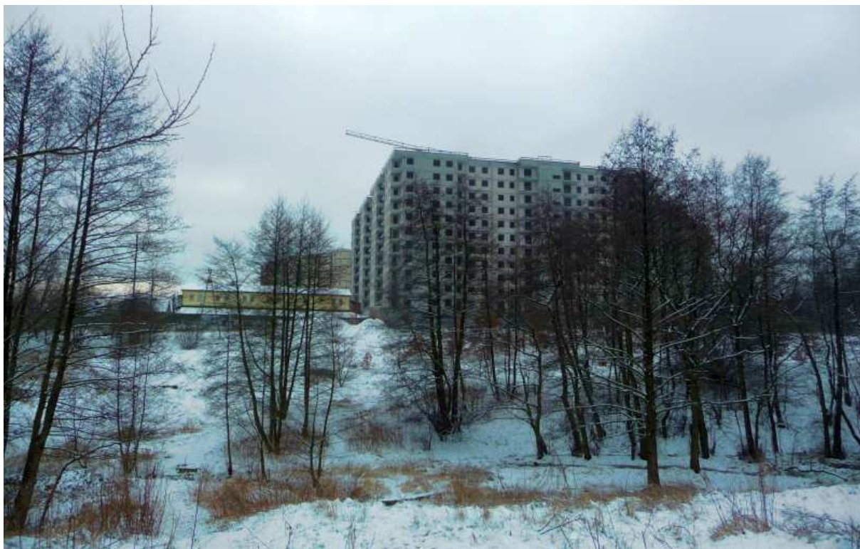
Fot. nr 112. Nowe blokowisko na styku ulic: Spornej i Szpakowej. (24.01.14)
