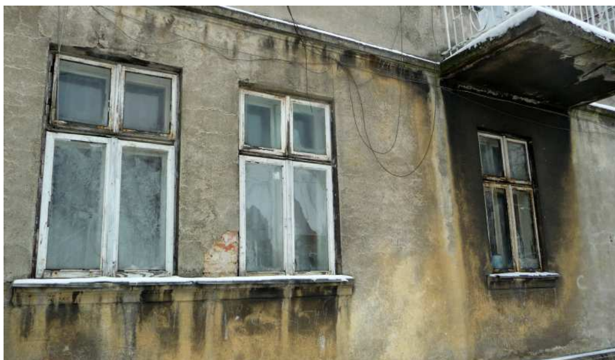
Fot. nr 60. Oryginalna okna parteru. (28.01.14)
