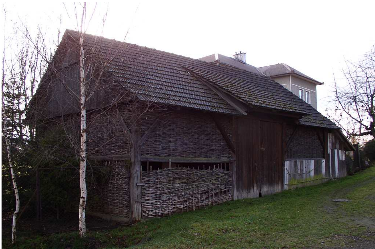
Fot. nr 256 (256-258). Nieistniejąca już archaiczna stodoła z plecionkowymi, wykonanymi z wikliny ścianami, wybudowana na początku XX. wieku, która stała na dziedzińcu posesji pod nr 11. (08.12.2008)
