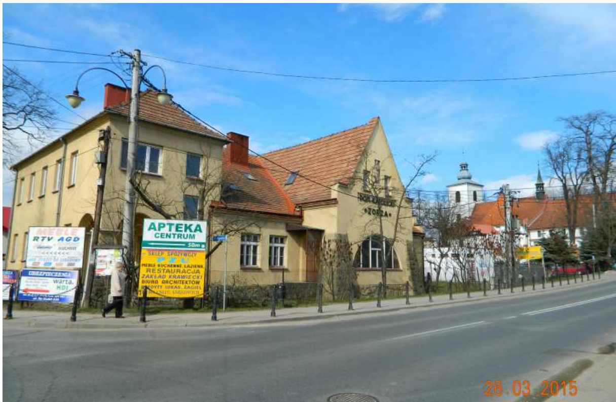
Fot. nr 354 (354-356). Międzywojenny budynek Domu Katolickiego Zorza (nr 207), wybudowany w narożu ulic: Łapanowskiej i Młyńskiej około roku 1930.
