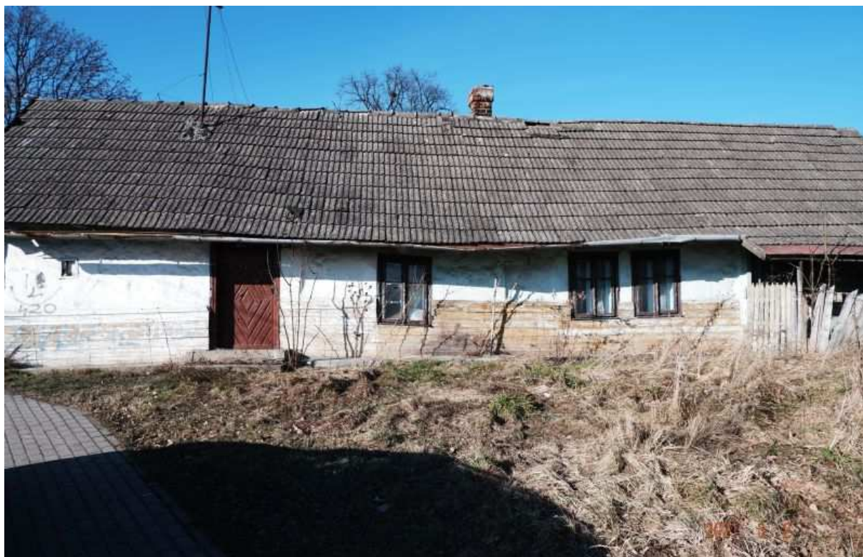
Fot. nr 238 (238-238a). Stan z roku 2021.
