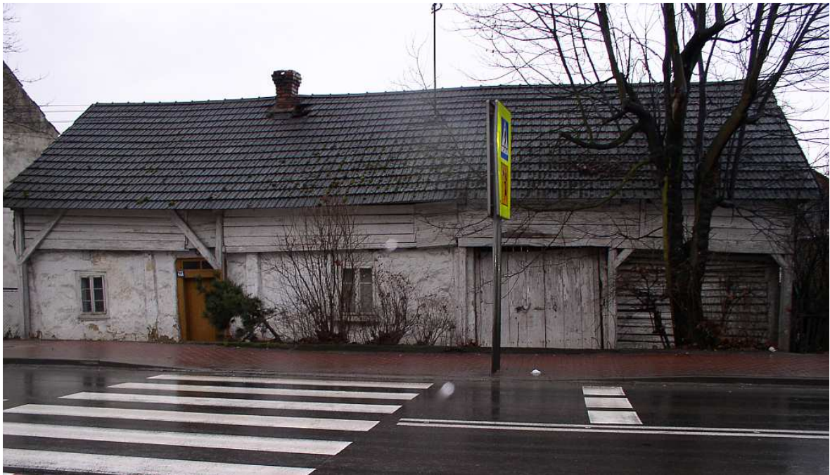
Fot. nr 161 (161-169a). Coraz bardziej popadający w ruinę rozległa, drewniana chałupa spod nr 148, wybudowana około roku 1850, przebudowana na pocz. XX wieku. Z prawej strony we wspólnym korpusie przylega do niej część gospodarcza. Stan z roku 2008. (21.12.2008)
