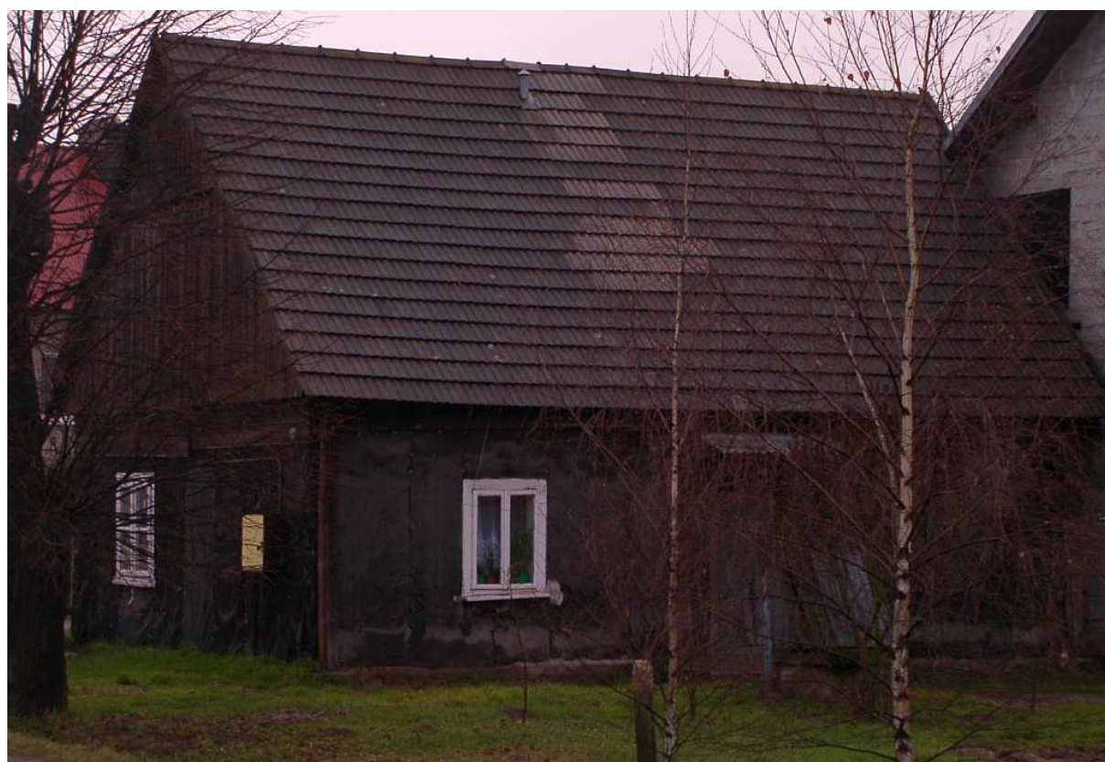
Fot. nr 262 (262-264). Widoki od strony podwórka. (21.12.2008)
