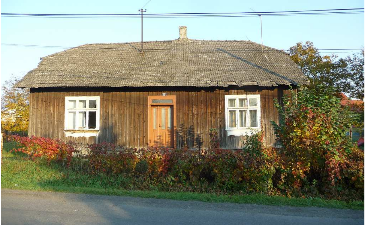
Fot. nr 203. Fasada z oryginalnymi oknami typu weneckiego. (22.10.2012)
