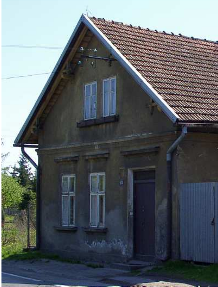
Fot. nr 313. Solidna architektura fasady domu spod nr 154. (25.04.2009)
