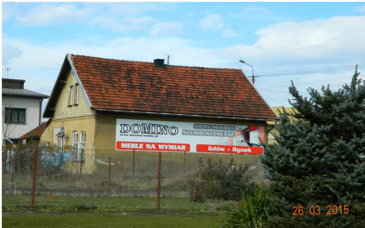
Fot. nr 316. Tylna część domu pod nr 154.
