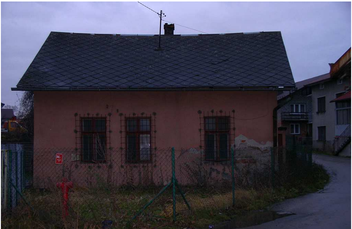
Fot. nr 84 (84-85). Bliski oryginałowi, przedwojenny dom spod nr 205. (21.12.2008)
