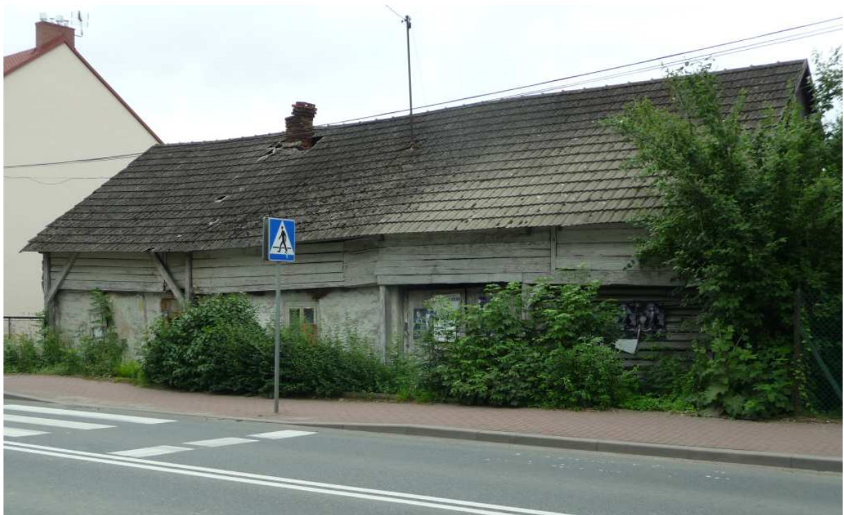
Fot. nr 164 (164-164a). Stan z roku 2015. (13.06.2013)
