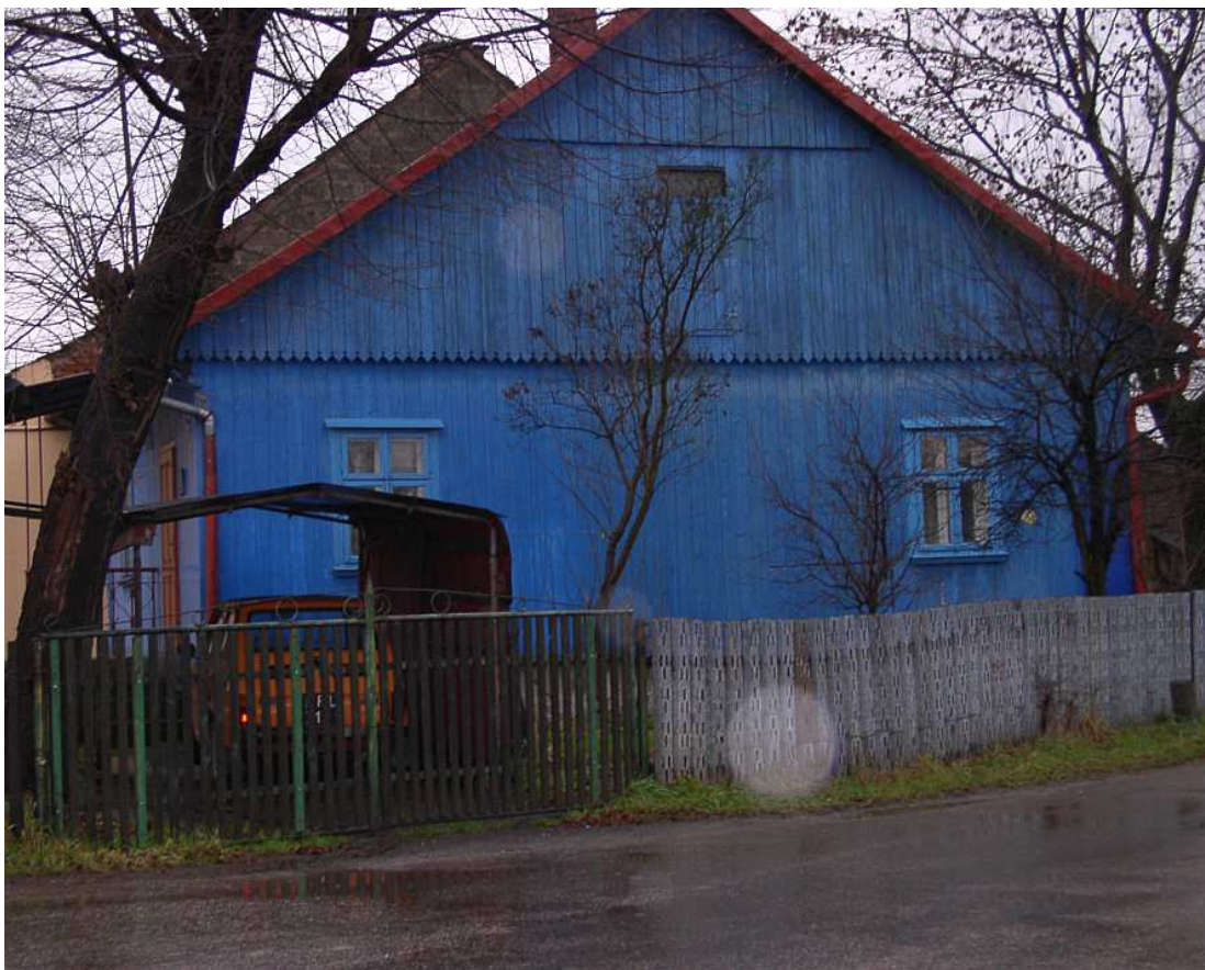
Fot. nr 210 (210-214). Zapewne około 100-letni dom z naroża ulic: Bocheńskiej i Obrytka spod nr 186, remontowany na początku II. dekady XXI. wieku. Fot. nr: 209-210. Dawny wygląd z roku 2008. (21.12.2008)
