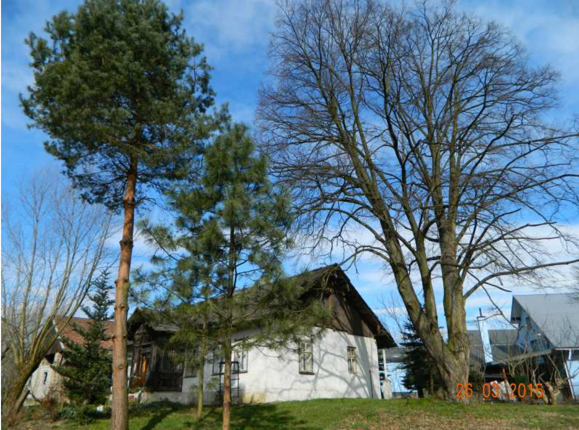
Fot. nr 277 (277-283). Ujęcia od strony ogrodu wg stanu z roku 2015.
