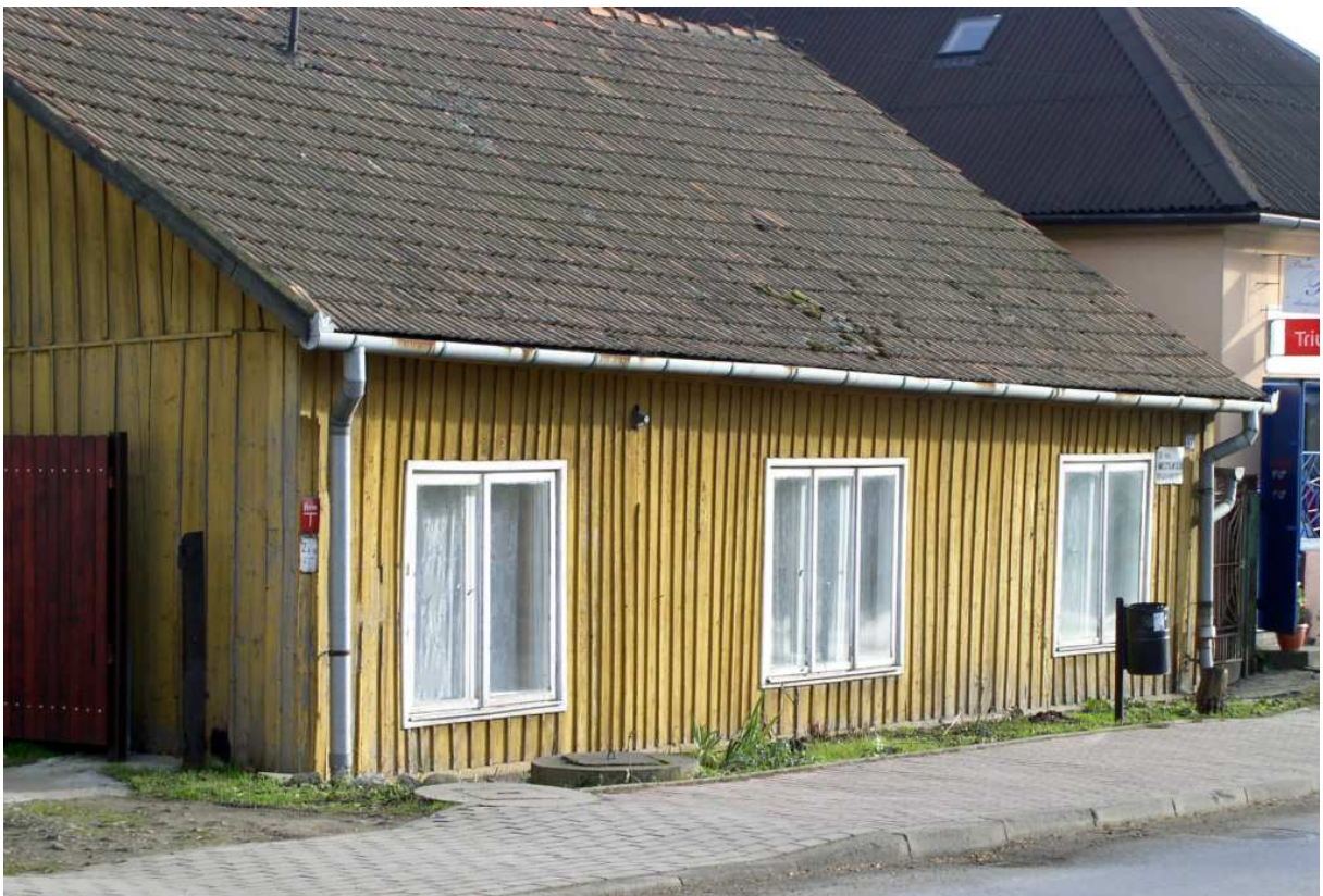
Fot. nr 348. Zburzona już dawna chałupa spod nr 331. (02.12.2008)
