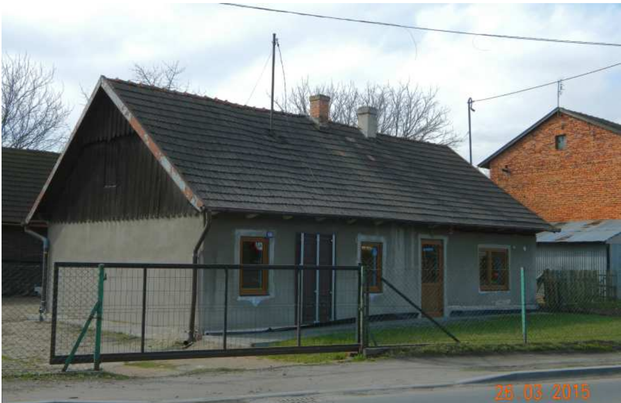
Fot. nr 322. Przebudowany już oryginał wg stanu z roku 2015, gdzie czterokwaterowe okna typu ościeżnicowego zastąpiły bezpodziałowe plastiki.
