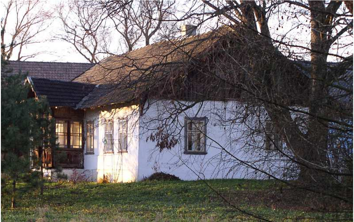
Fot. nr 275. Oryginalne, czterokwaterowe okna typu ościeżnicowego. (08.12.2008)
