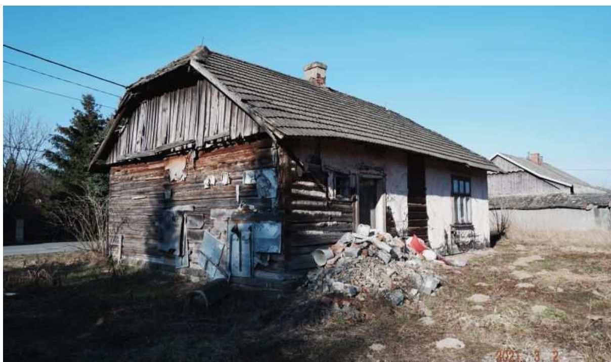
Fot. nr 408 (408-409). Widoki od strony podwórka.
