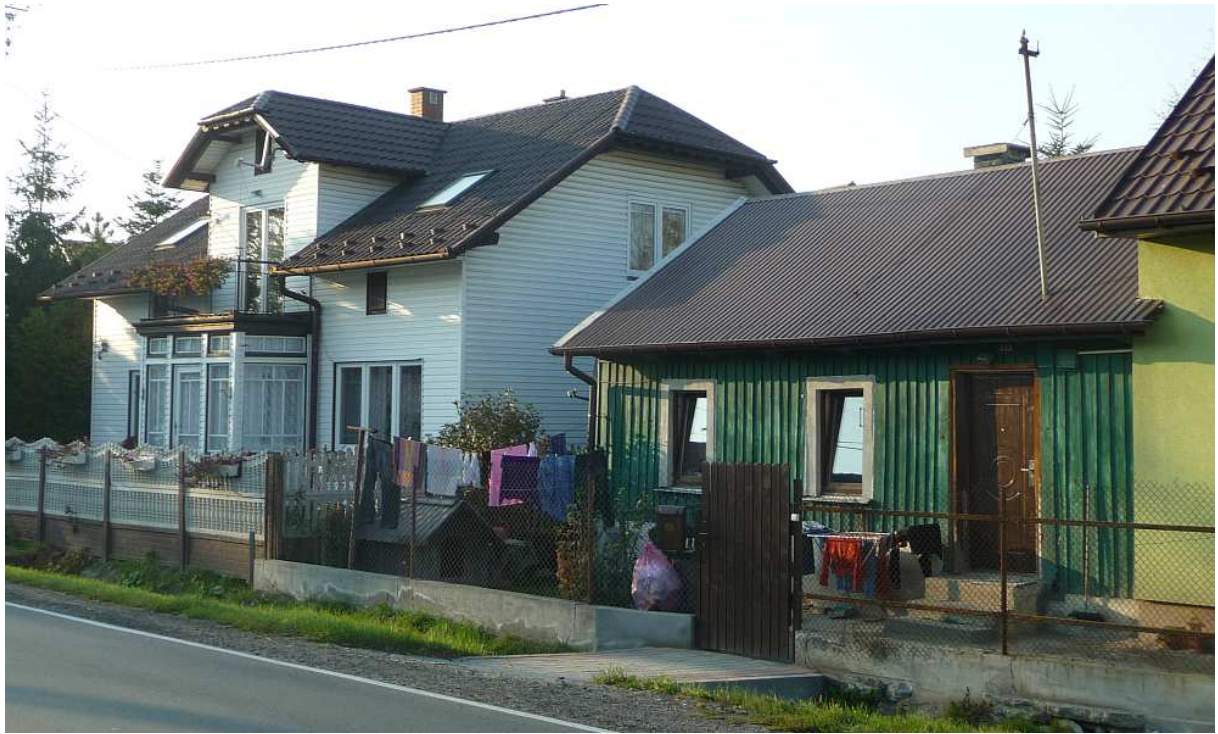
Fot. nr 219. Chałupa z oszalowaną fasadą spod nr 333. (22.10.2012)
