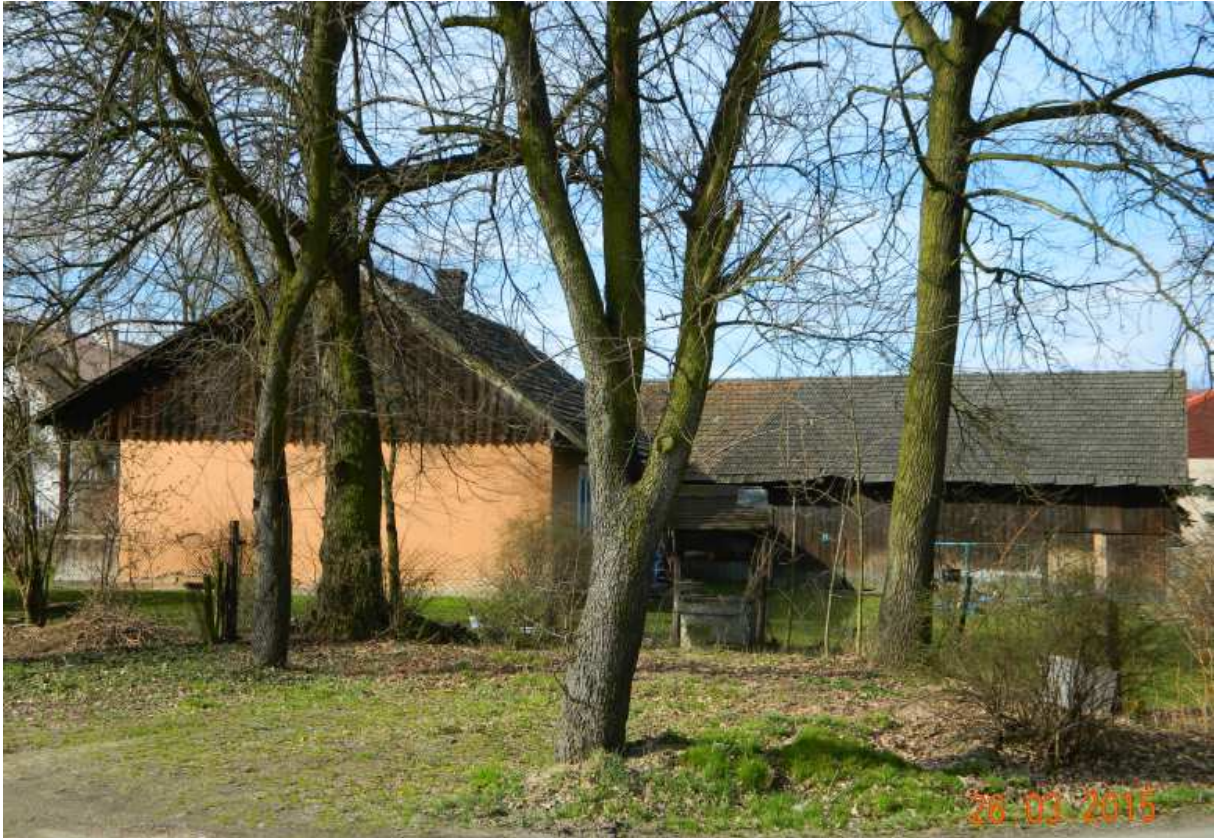
Fot. nr 223. Widok na kompleks domu i stodoły z ulicy Obrytka.
