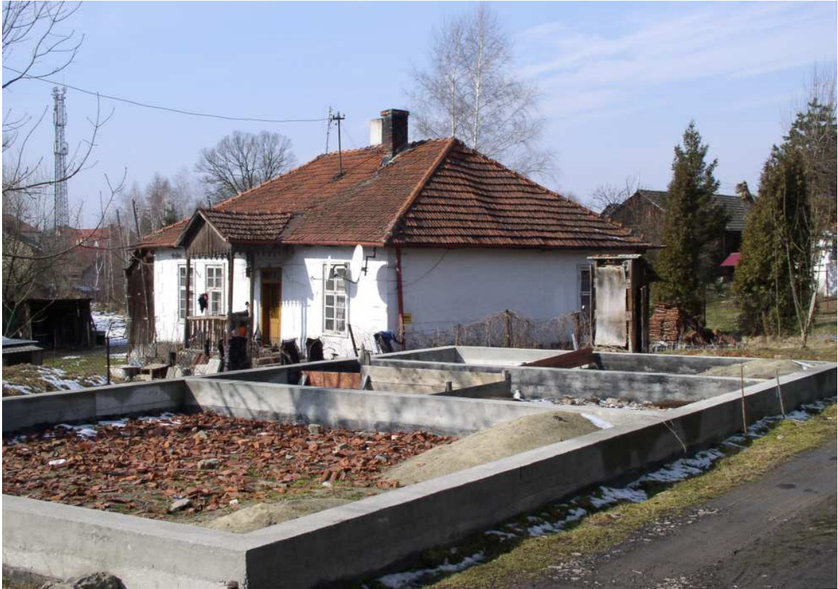
Fot. nr 133 (133-134). Z fundamentami zburzonego domu spod nr 309 na pierwszym planie. (05.03.2011)
