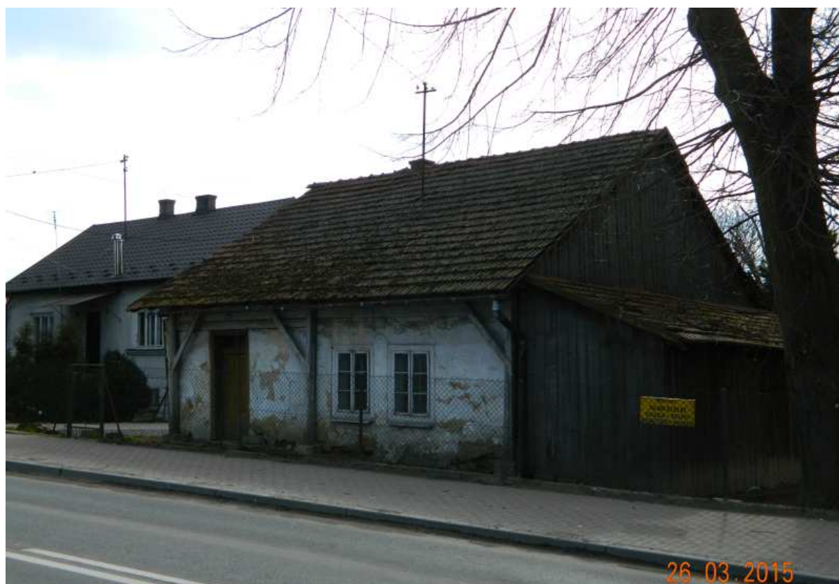
Fot. nr 159 (159-159b). Stan z roku 2015.
