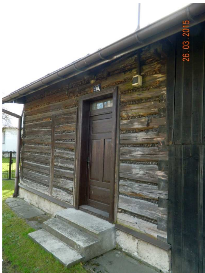
Fot. nr 116. Część mieszkalna.
