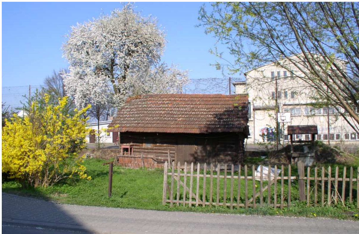
Fot. nr 401 (401-402). Budynek inwentarski w jednym korpusie z niewielką stodołą i studnią na dziedzińcu domu spod nr 281. (19.04.2009)
