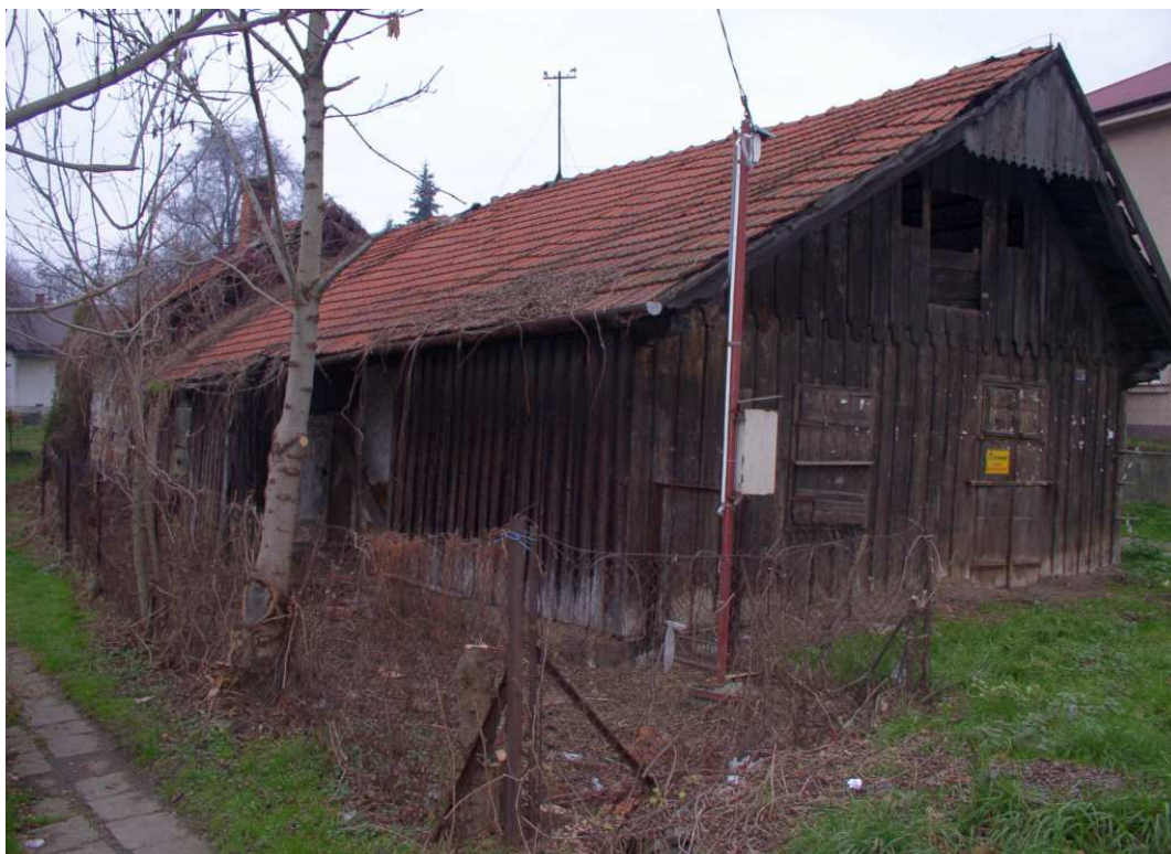
Fot. nr 138 (138-141). Nieistniejąca już od roku 2009 rozległa chałupa o charakterze mieszkalno-handlowym spod nr 309, wybudowana w końcu XIX. wieku. (16.11.2008)
