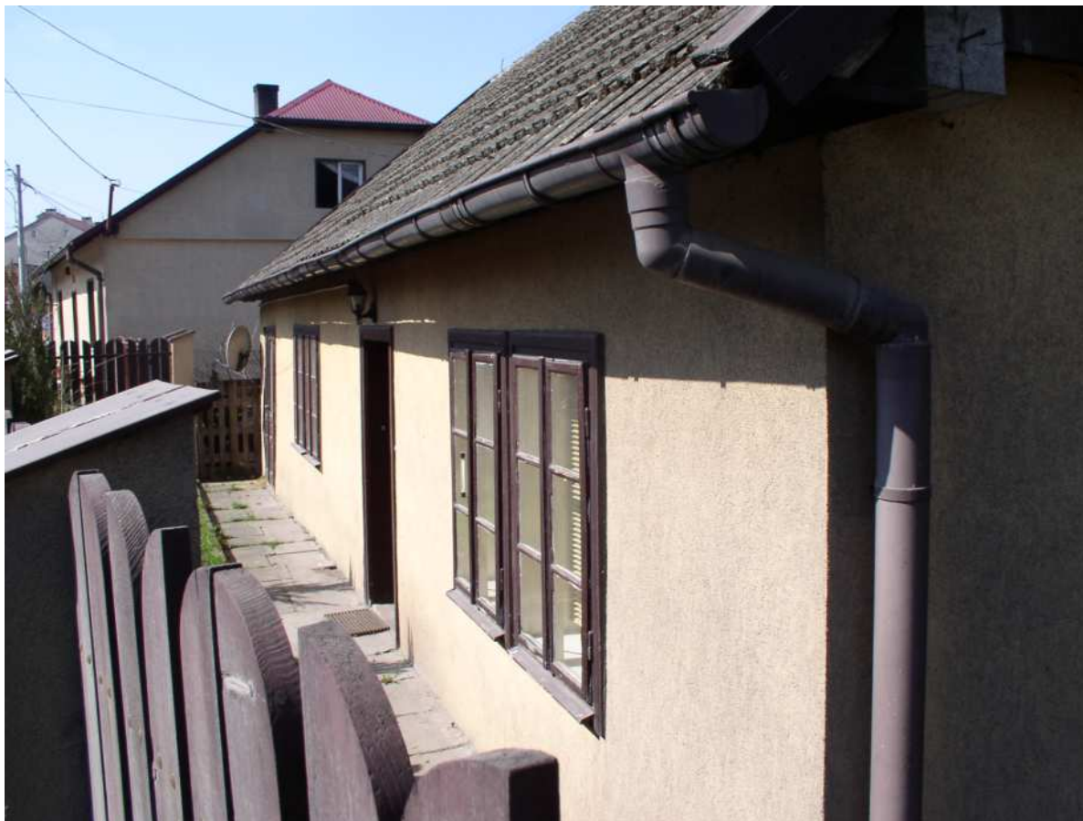
Fot. nr 125. Oryginalne okna typu ościeżnicowego. (05.04.2009)
