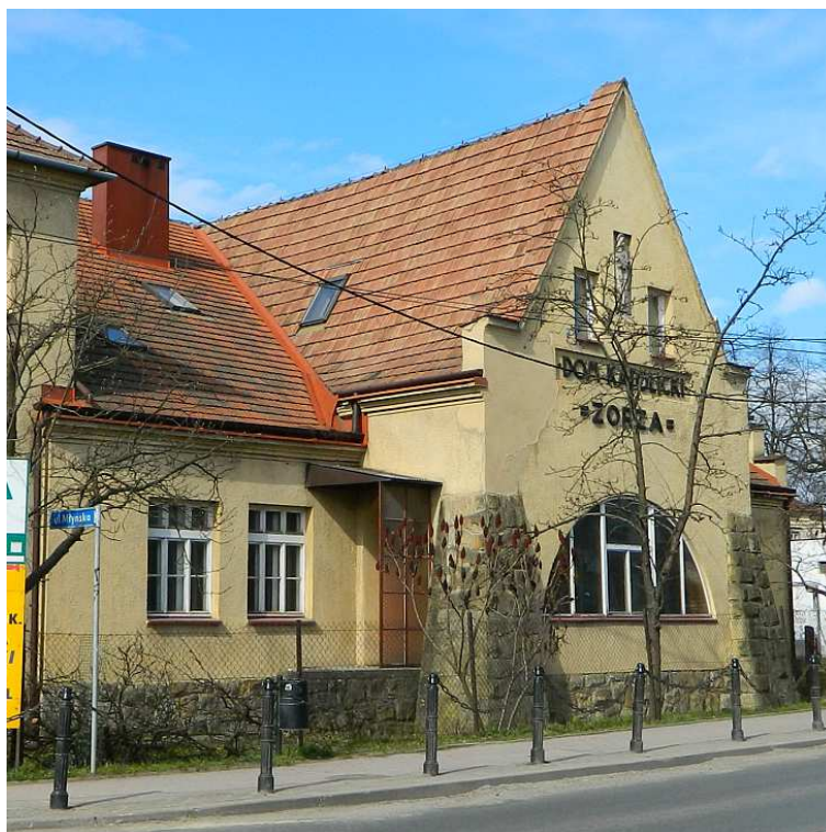
Fot. nr 355. Fasada od strony ulicy Łapanowskiej.
