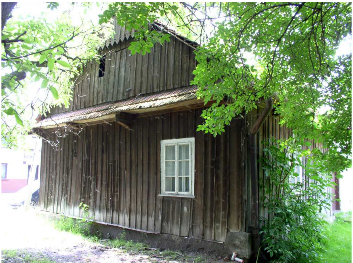
Fot. nr 197 (197-197a). Ściana szczytowa. (30.06.2009)
