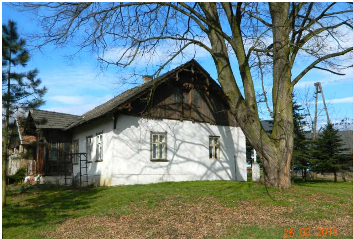
Fot. nr 284. Ściana szczytowa.
