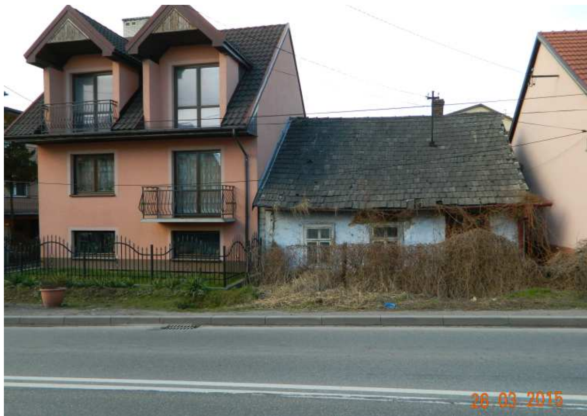
Fot. nr 73 (73-73a). Stan z roku 2015.
