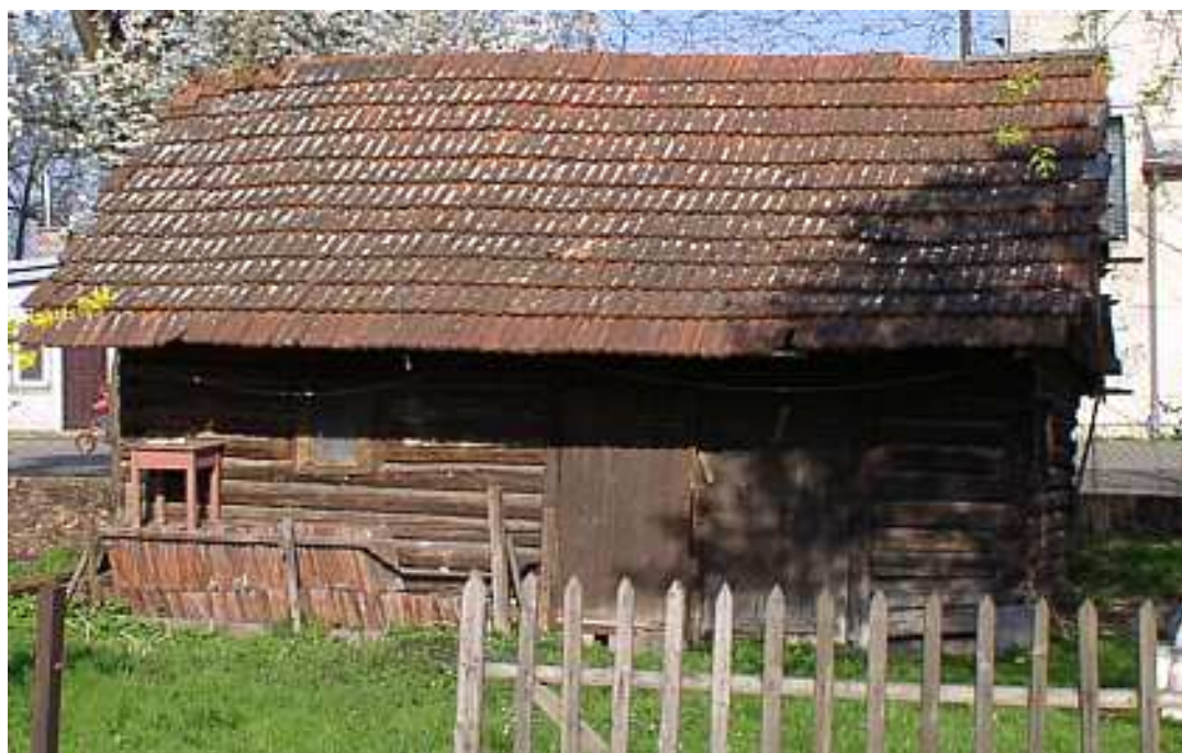
Fot. nr 402. Detale nieistniejącego już obiektu. (19.04.2009)
