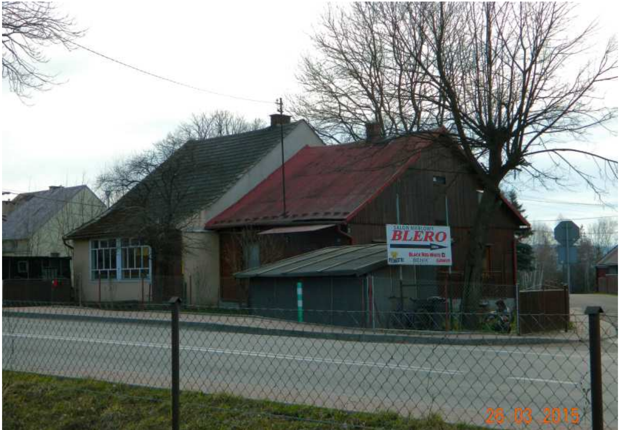
Fot. nr 212 (212-214). Stan z roku 2015, po remoncie elewacji.
