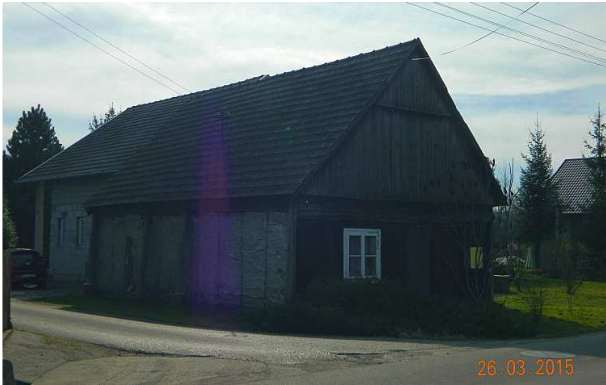
Fot. nr 259 (259-264). Wiekowa już chałupa z ulicy Obrytka spod nr 295, której dawna, drewniana faktura została przysłonięta współczesną izolacją.
