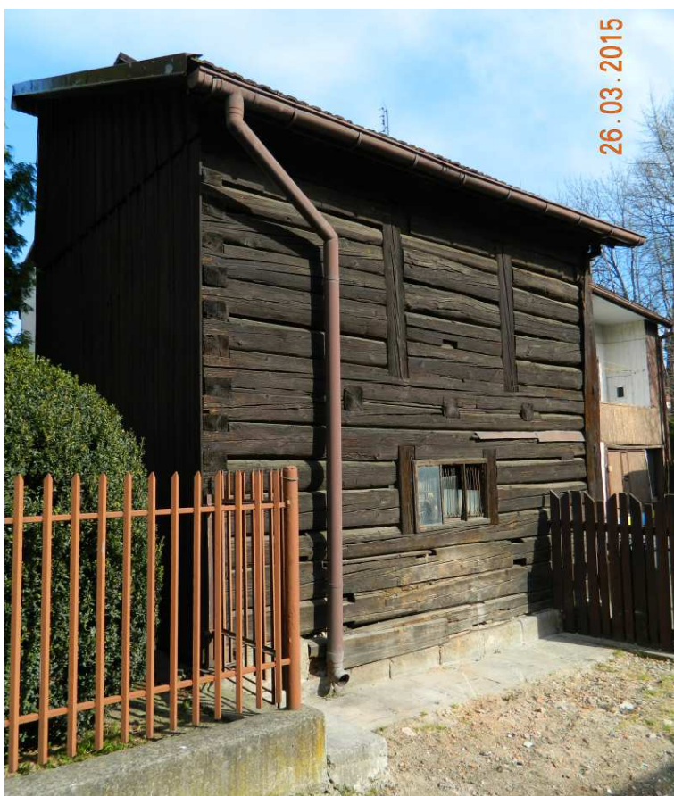
Fot. nr 118. Przylegające do dawnej chałupy pod nr 278 pomieszczenie gospodarcze.
