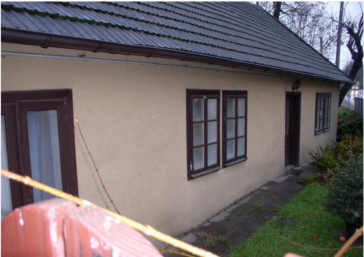
Fot. nr 124 (124-125). Detale pokrytej tynkiem fasady po remoncie z roku 1990. (21.12.2008)
