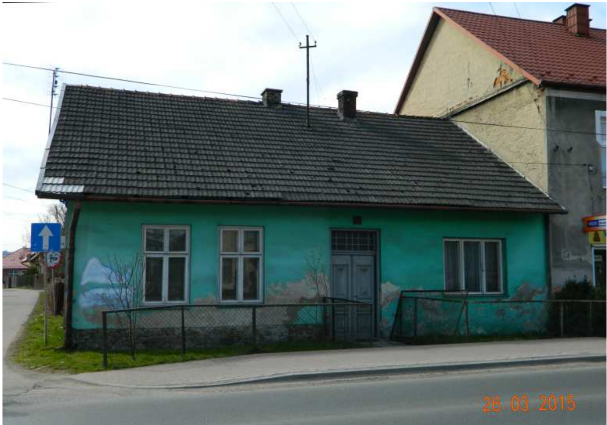
Fot. nr 341. Czterokwaterowe okna typu ościeżnicowego w lewej części fasady.
