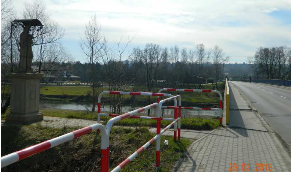
Fot. nr 265. Most na Rabie przy ulicy Łapanowskiej. Widok od strony centrum Gdowa.
