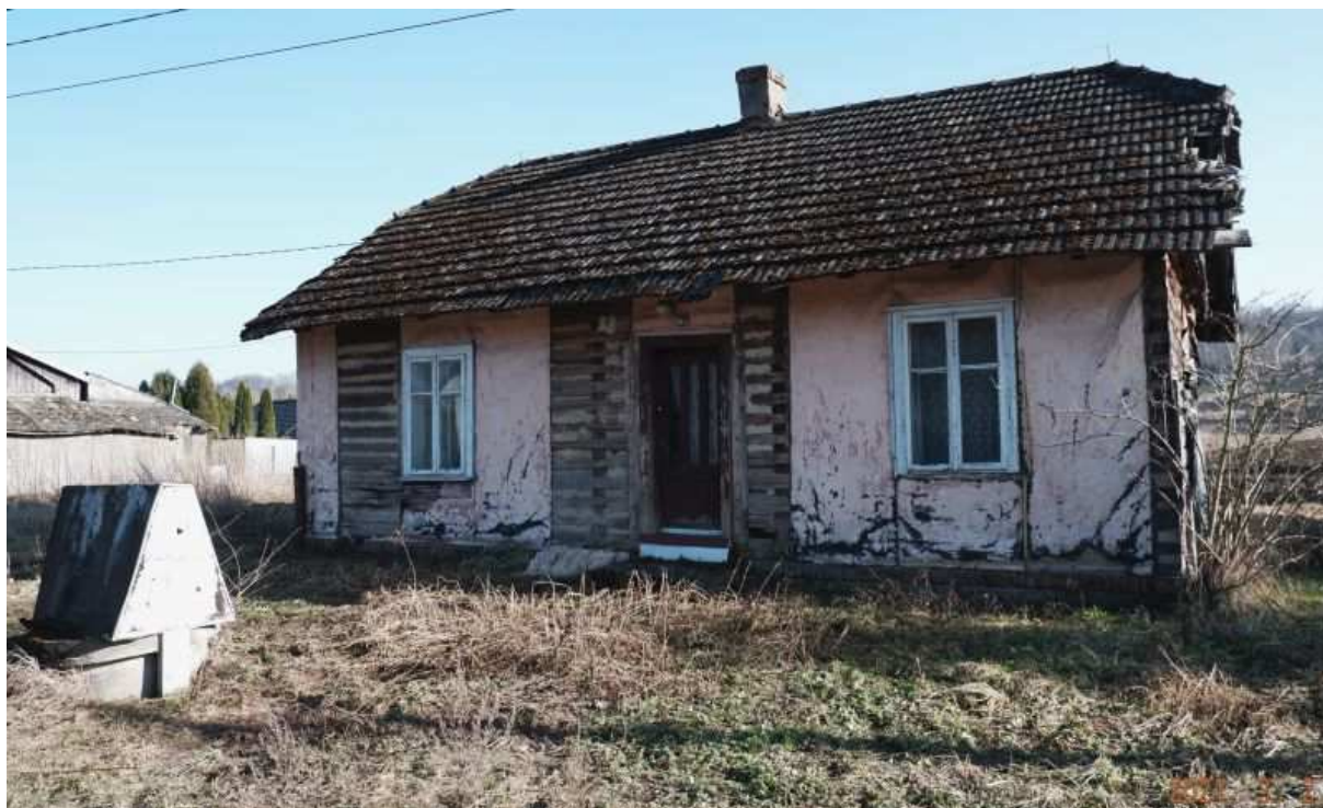
Fot. nr 406. Fasada od strony ulicy.
