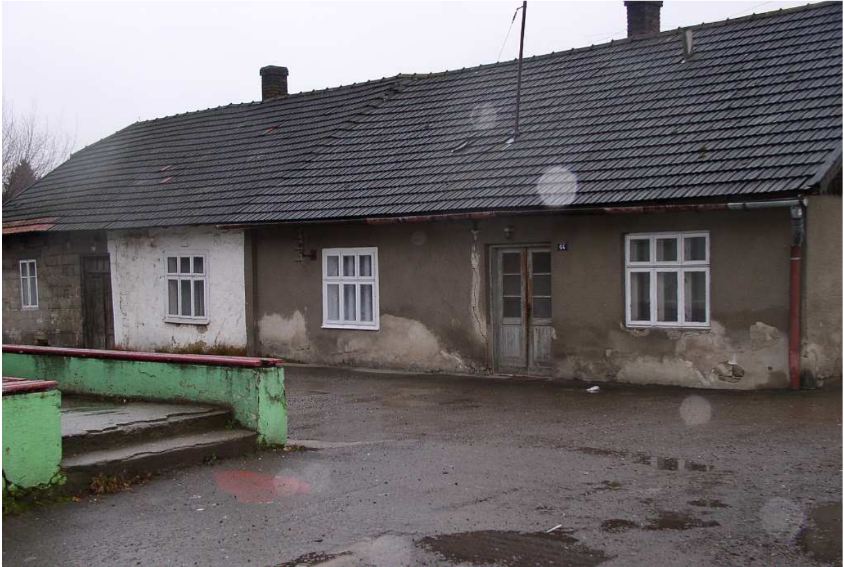
Fot. nr 287 (287-289). Widoki fasady od strony ulicy Zacisze z oknami typu weneckiego w fasadzie. (21.12.2008)
