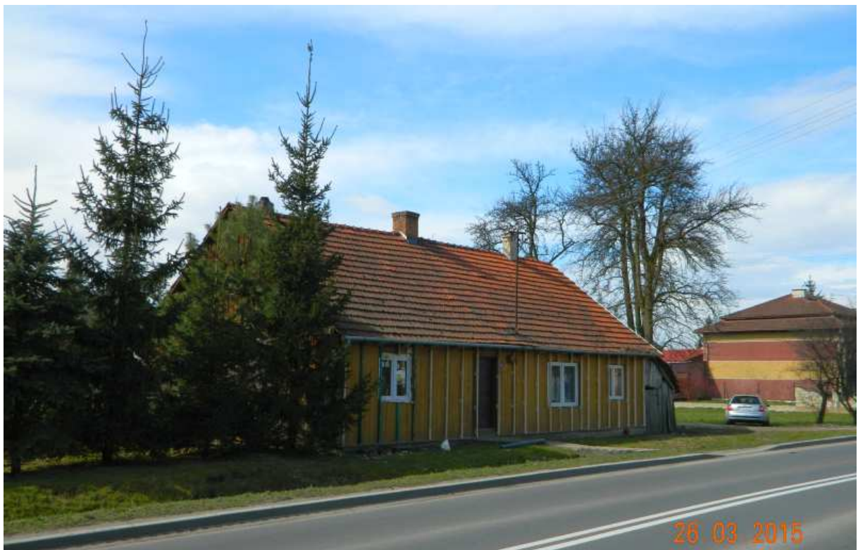
Fot. nr 294 (294-295). Przebudowana, oszalowana chałupa z ulicy Łapanowskiej (nr 82).
