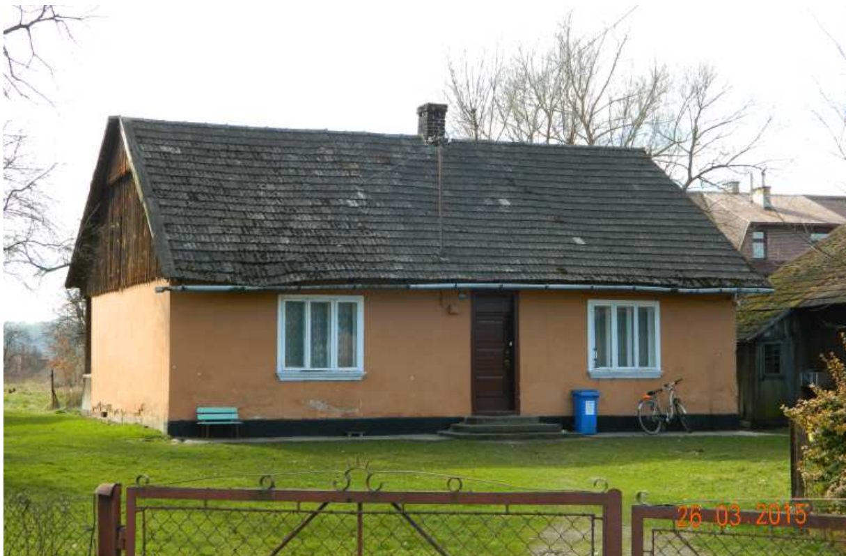
Fot. nr 222. Otynkowany już, drewniany dom w ujęciu z ulicy Bocheńskiej.
