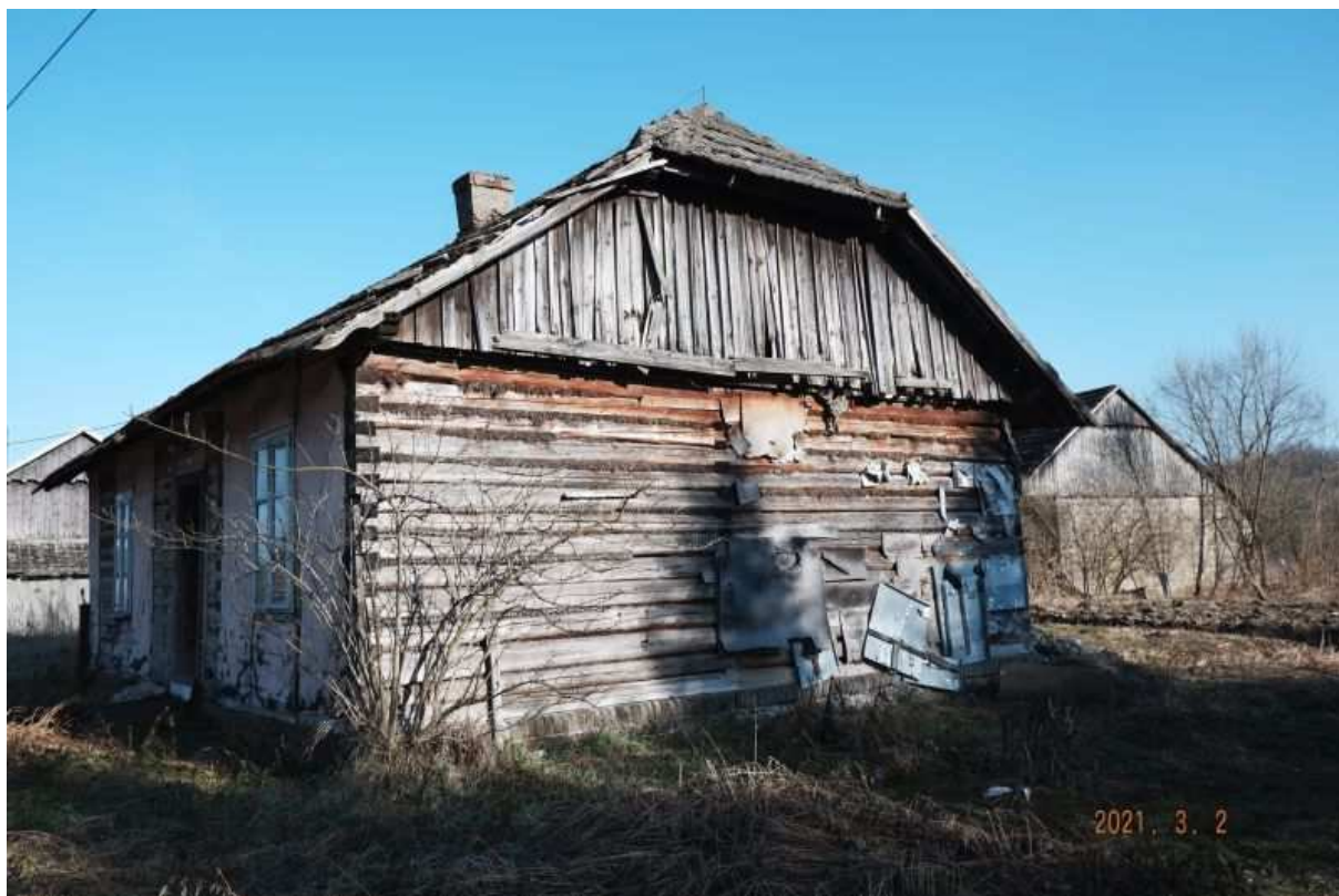
Fot. nr 407. Ściana szczytowa.
