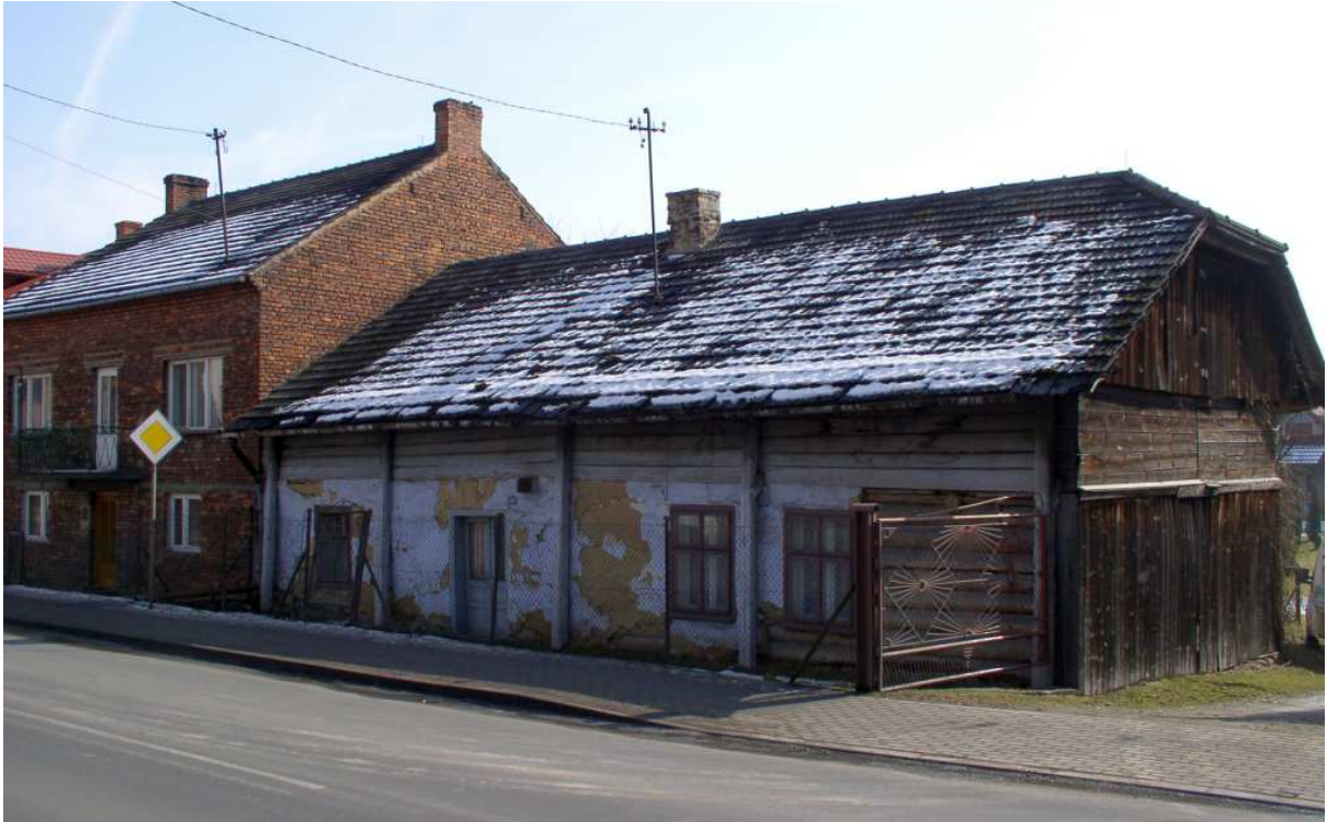
Fot. nr 173. Stan z roku 2011, niedługo przed wyburzeniem. (05.03.2011)
