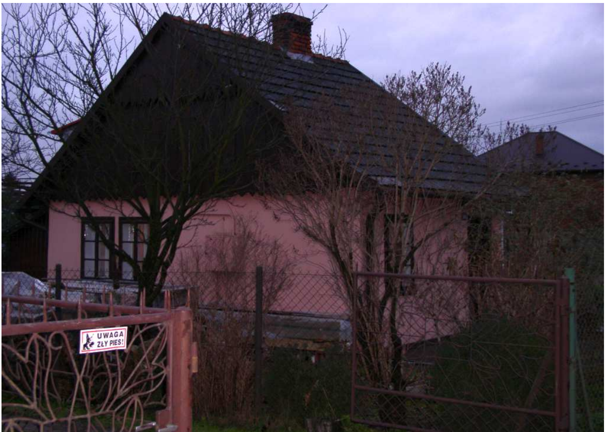
Fot. nr 306. Ściana szczytowa. (21.12.2008)
