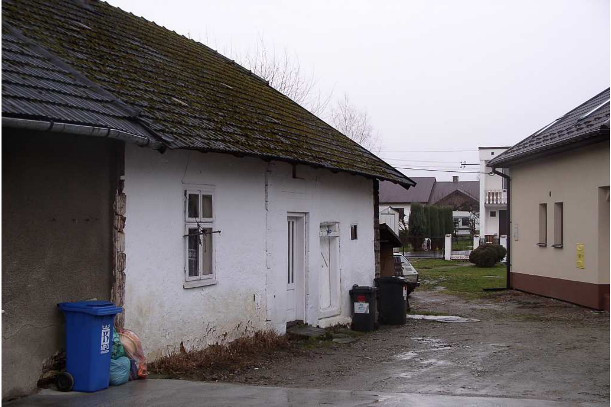
Fot. nr 291. Prawa część rozległego budynku. (21.12.2008)
