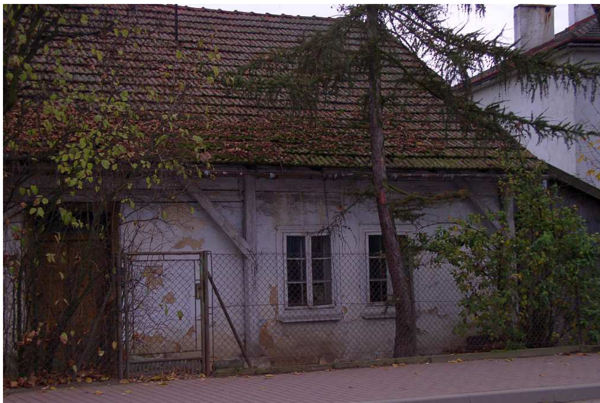
Fot. nr 152 (152-160b). Częściowo zburzona, drewniana chałupa spod nr 245, wybudowana ok. roku 1850. Tu najstarsze jej moje zdjęcie z roku 2008. (16.11.2008)
