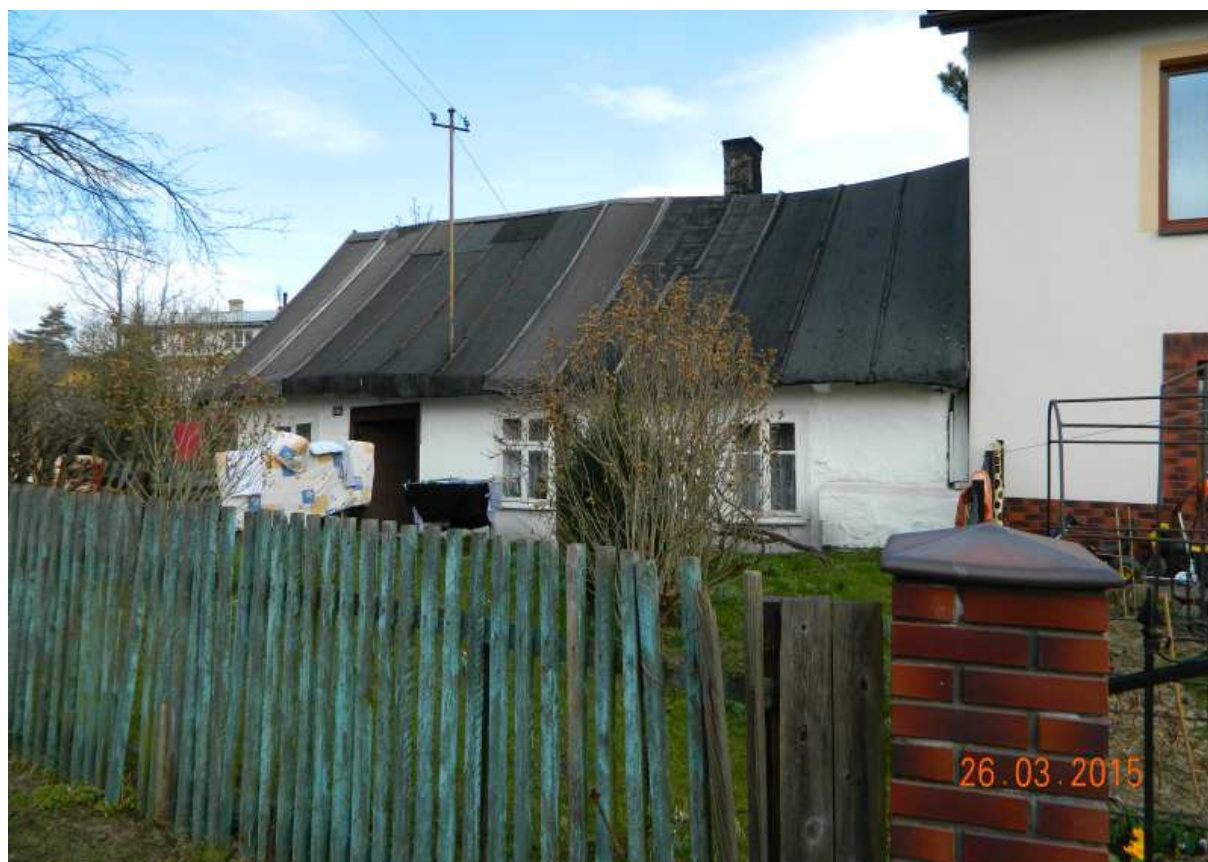
Fot. nr 370 (370-373). Oryginalna fasada ciągle zamieszkałej wiejskiej chałupy z ulicy Młyńskiej pod nr 250. Ten cenny zabytek etnograficzny może pochodzić z II połowy XIX. wieku. Czy przetrwa?
