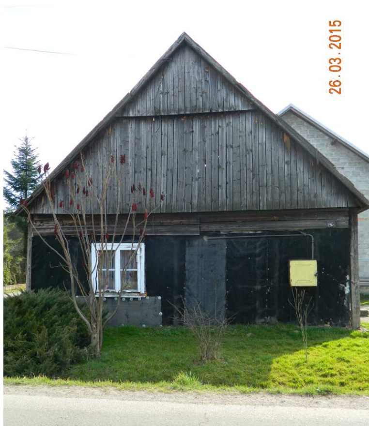
Fot. nr 260. Szczytowa ściana od strony ulicy.
