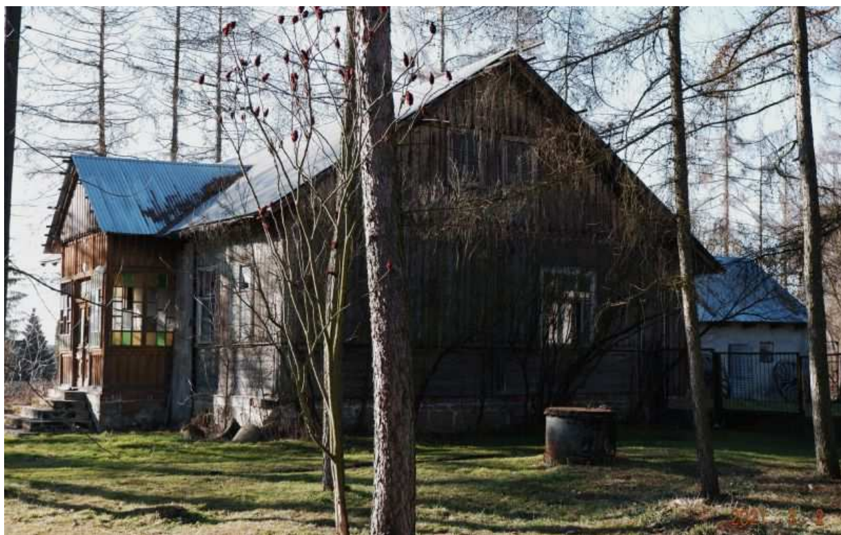
Fot. nr 411 (411-419). Zabudowa posesji pod nr 213. Nr: 411-417. Efektowny do dziś dom, wybudowany w okolicy przełomu III i IV kwarty XX. wieku oraz jego detale.
