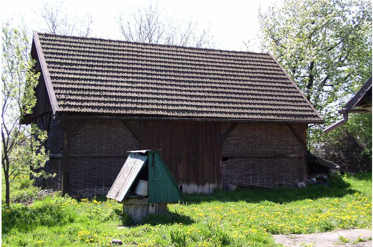
Fot. nr 333 (334-334). Stodoła o plecionkowych, wiklinowych ścianach i studnia na tyłach domu spod nr 194. (25.04.2009)
