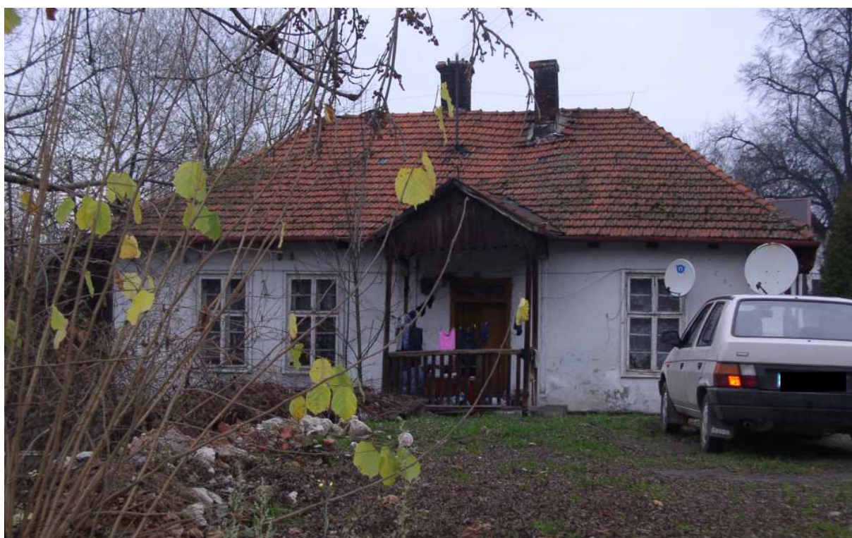
Fot. nr 128 (128-134). Nieistniejący już skromny dworek spod 173, pochodzący z końca XIX. wieku, który był cennym przykładem zabudowy klasycystycznej. Tu w czasach PRL mieścił się ośrodek zdrowia. Kto mógł przypuszczać, że zostanie on wyburzony. (16.11.2008)
