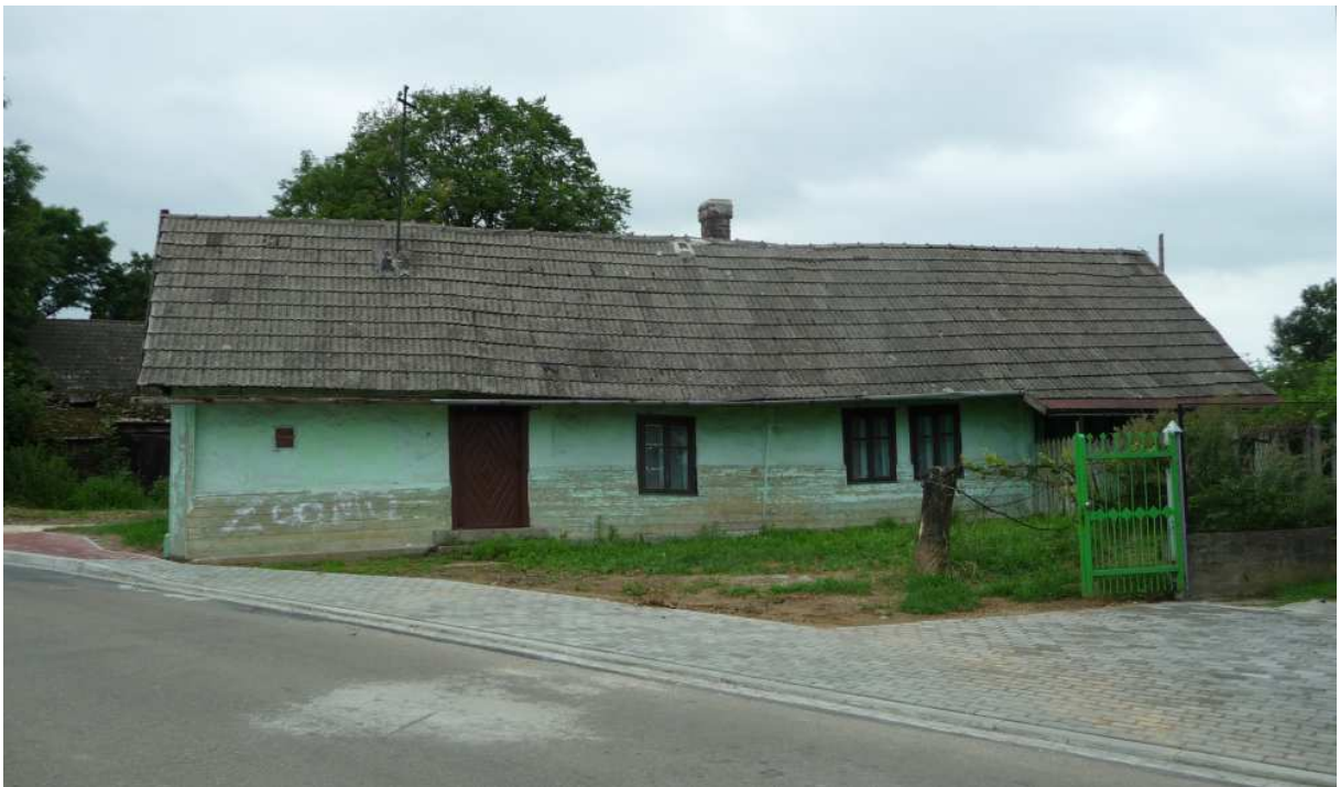
Fot. nr 234 (234-234a). Stan z roku 2013. (13.06.2013)
