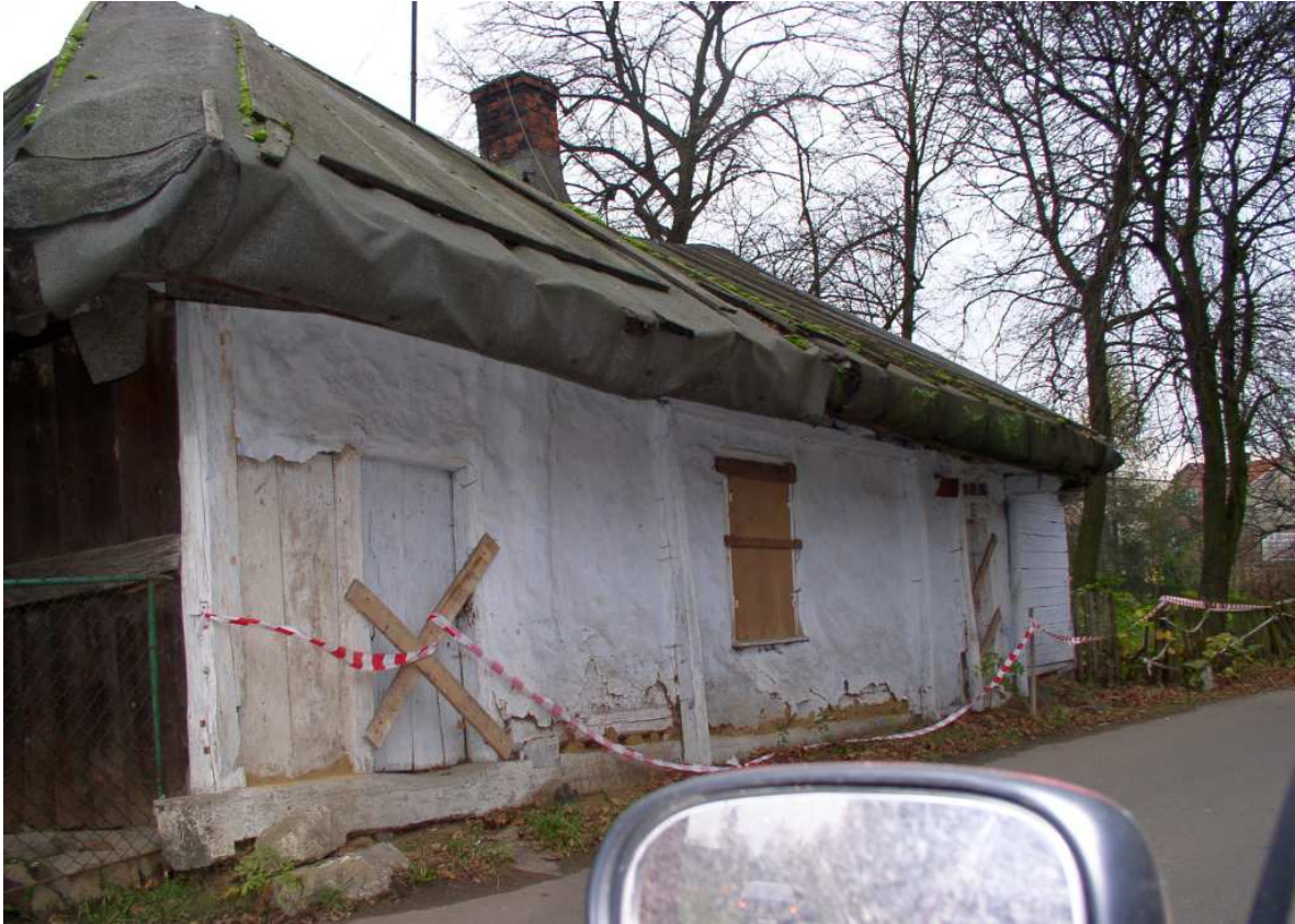
Fot. nr 225 (225-226). Nieistniejący już drewniana chałupa pod nr 132, kiedyś solidnie bielona pochodząca z początku XX. wieku, którą udało mi się jeszcze uchwycić, ale już bez niewielkiego dwukwaterowego, czteropolowego okienka. (16.11.2008)
