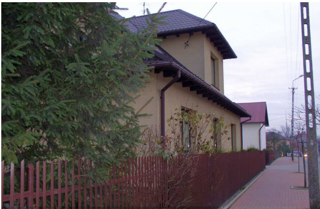
Fot. nr 53. Dom Zastawniaków pod nr 3, zasłużonej dla Gdowa rodziny. (16.11.2008)
