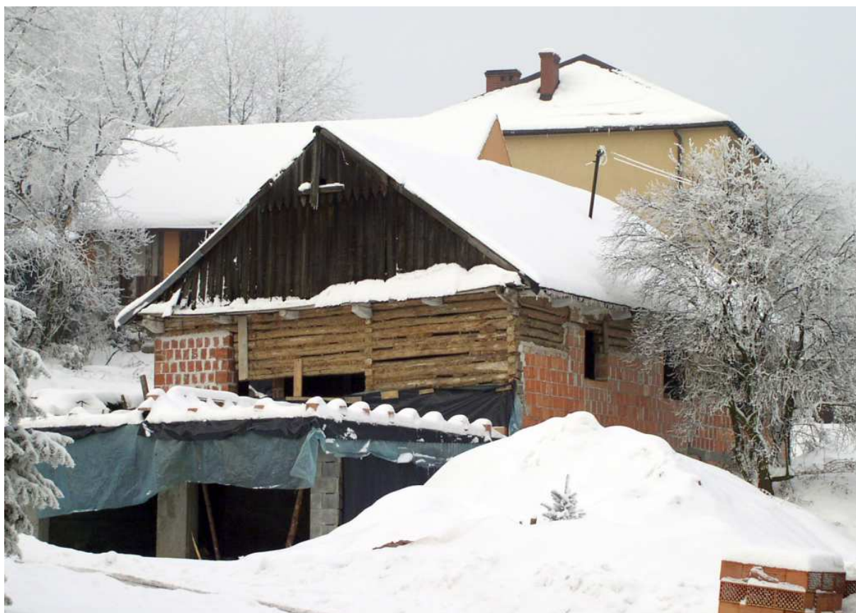
Fot. nr 215. Przebudowa domu pod nr 165 (?). (18.01.2010)
