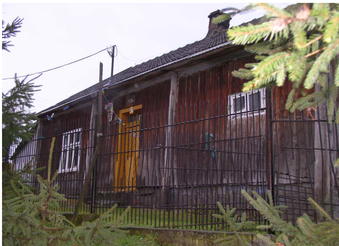
Fot. nr 293 (293-294). Zapewne blisko 100-letni, oszalowany dom pod nr 61. (21.12.2008).
