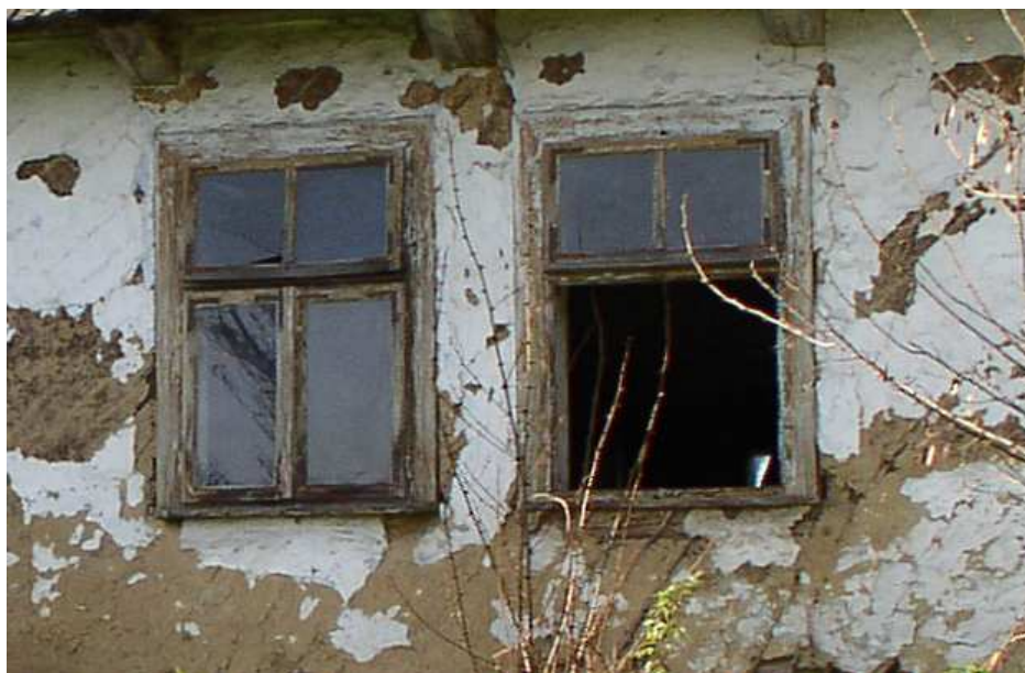
Fot. nr 204. Oryginalne, trójskrzydłowe okna. (19.04.2009)
