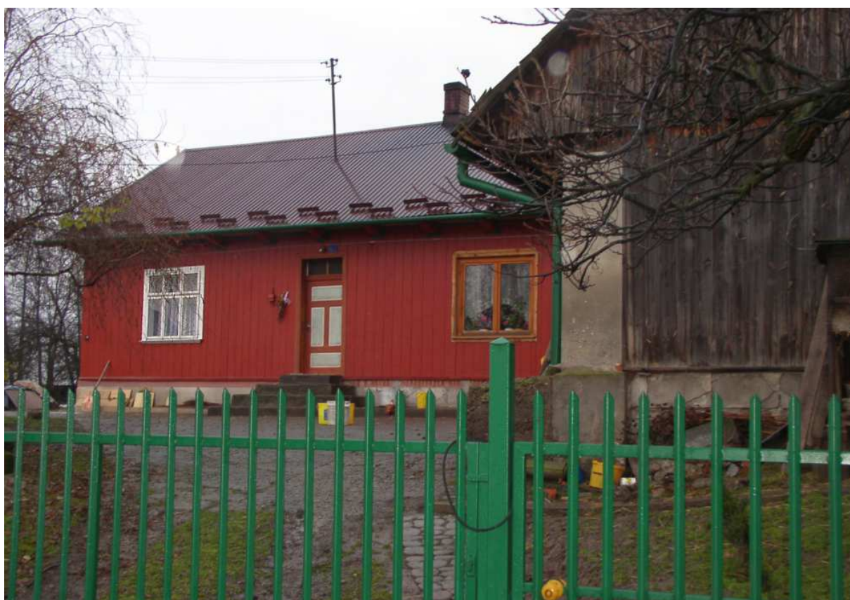
Fot. nr 295. Częściowo zmodyfikowana fasada oszalowanego domu w zagrodzie pod nr 97. Okno typu weneckiego oryginalne. (21.12.2008).
