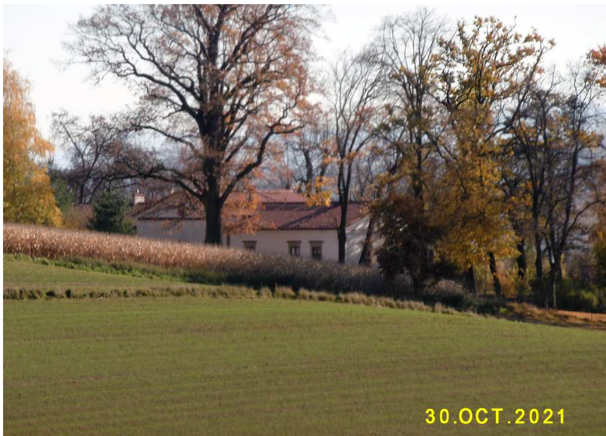
Fot. nr 64. Tylna część obiektu.
