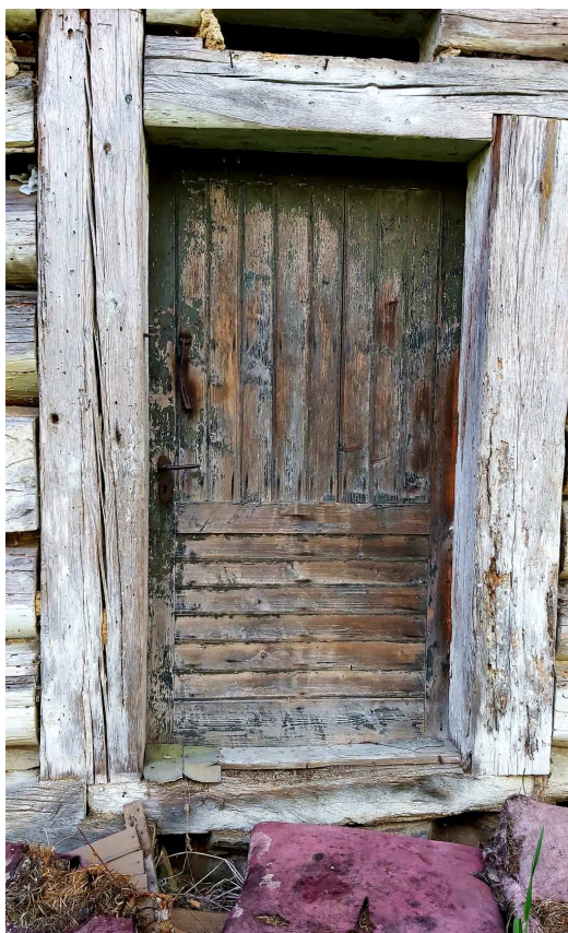
Fot. nr 333. Drzwi wiodące zapewne do części gospodarczej.
