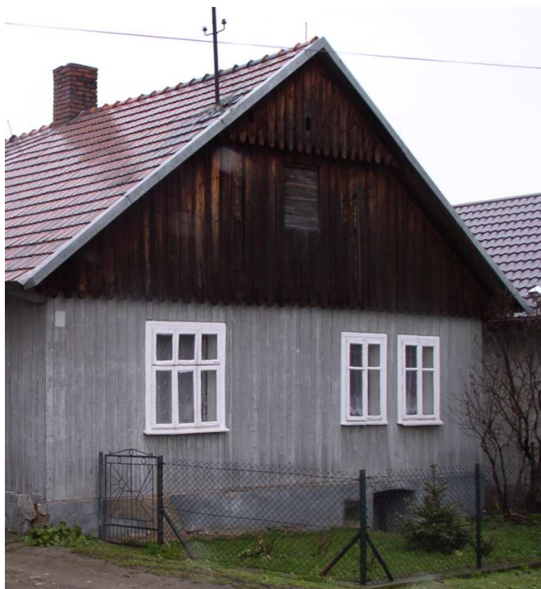
Fot. nr 296. Oszalowana ściana szczytowa domu z oryginalnymi oknami. (21.12.2008)
