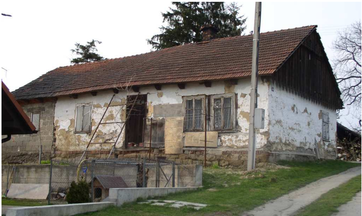
Fot. nr 81. Fasada od strony drogi wiodącej od Krzyżowej do Niegowici. (04.05.2009)
