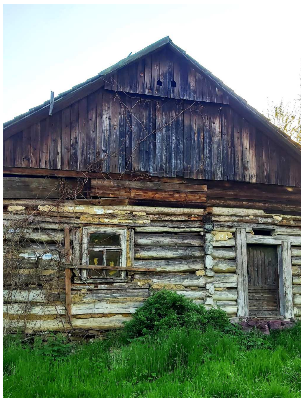
Fot. nr 332 (332-333). Boczna ściana szczytowa i jej detale.
