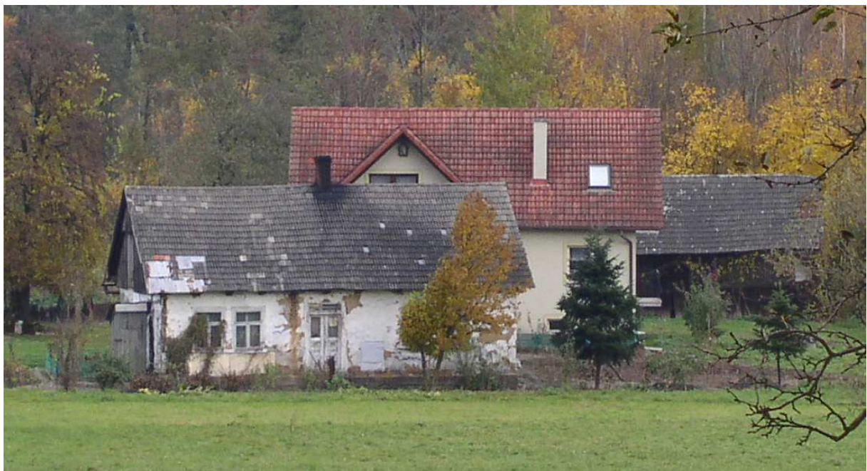
Fot. nr 127. W tle wybudowany niedawno nowy dom. (31.10.2009)
