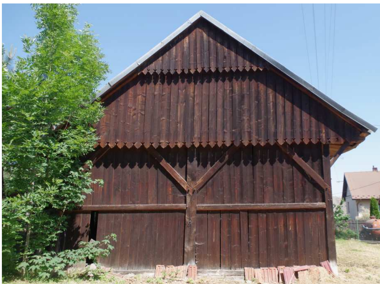
Fot. nr 284. Konstrukcja przysłopowa ściany bocznej.
