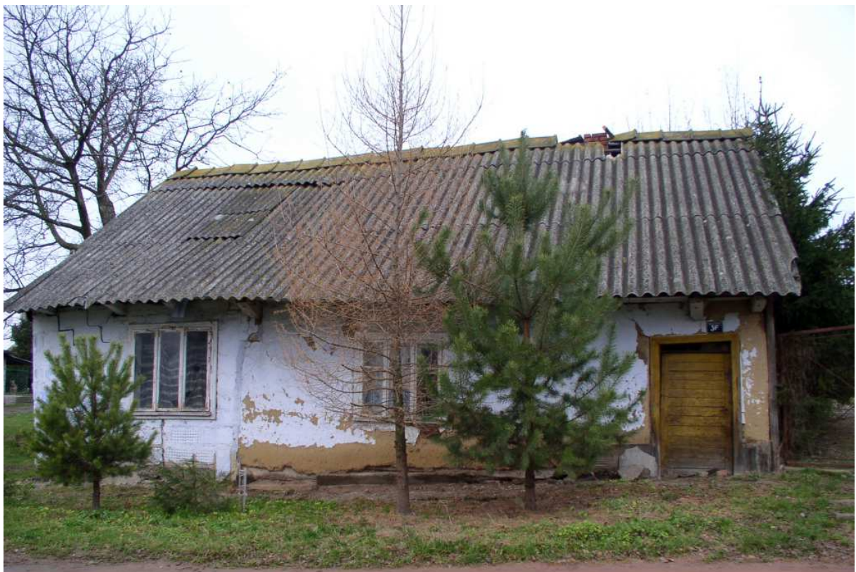
Fot. nr 95 (95-97). Wspomnienie kolejnego reliktu, zapewne z XIX-wiecznymi korzeniami, spod nr 36. (07.12.2009)
