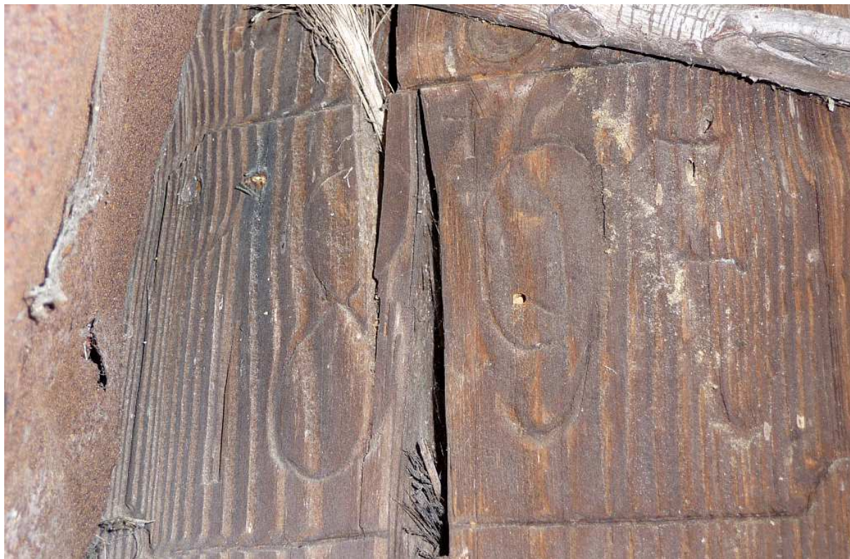
Fot. nr 136. Data budowy obiektu na podłużnej belce z boku drzwi. (31.10.2011)
