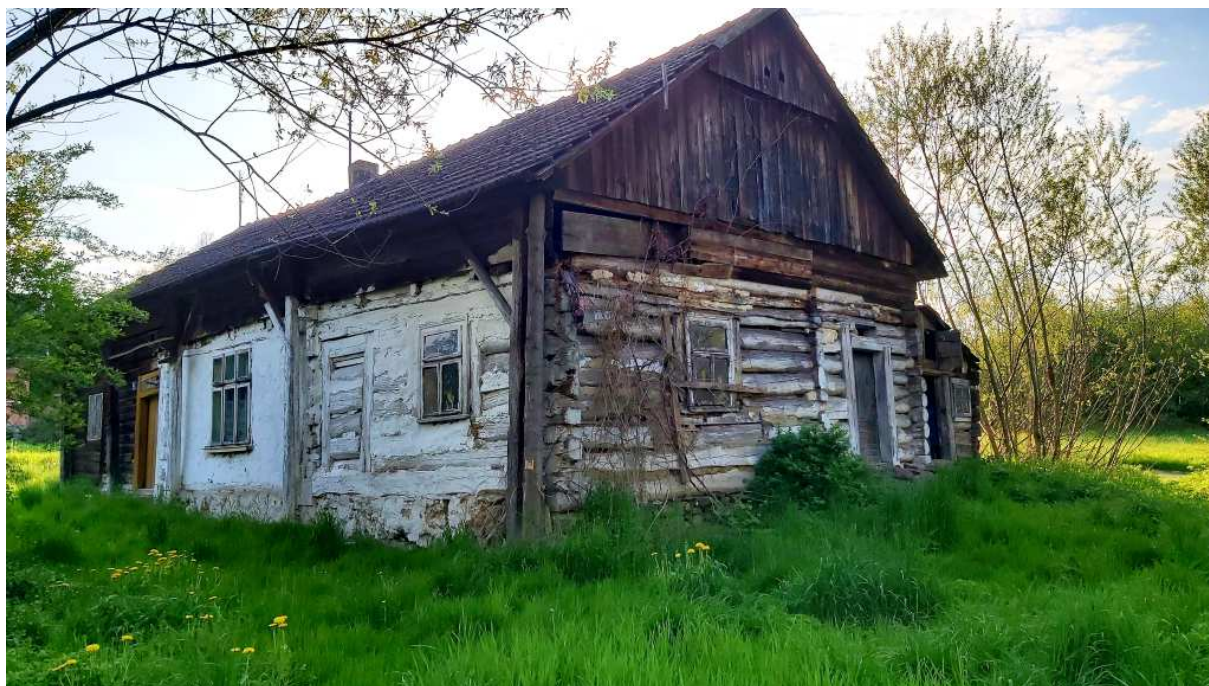
Fot. nr 327 (327-334). Chałupa z Niżowej spod nr 6 i jej detale. Obiekt wybudowany pod koniec XIX wieku figuruje w GEZ.
