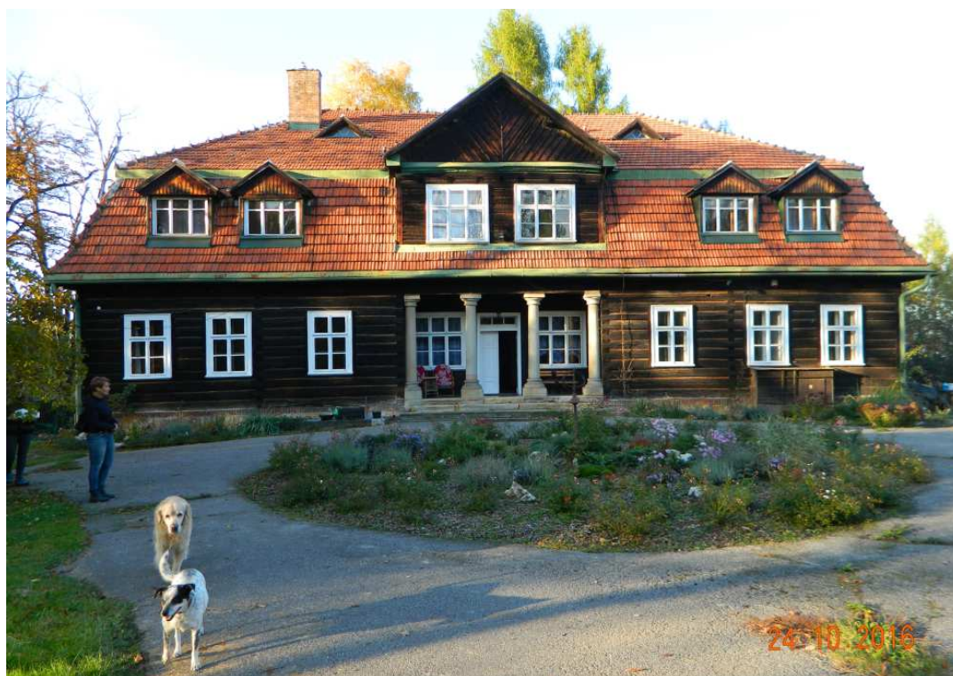
Fot. nr 299 (298-299). Fasada dworu.
