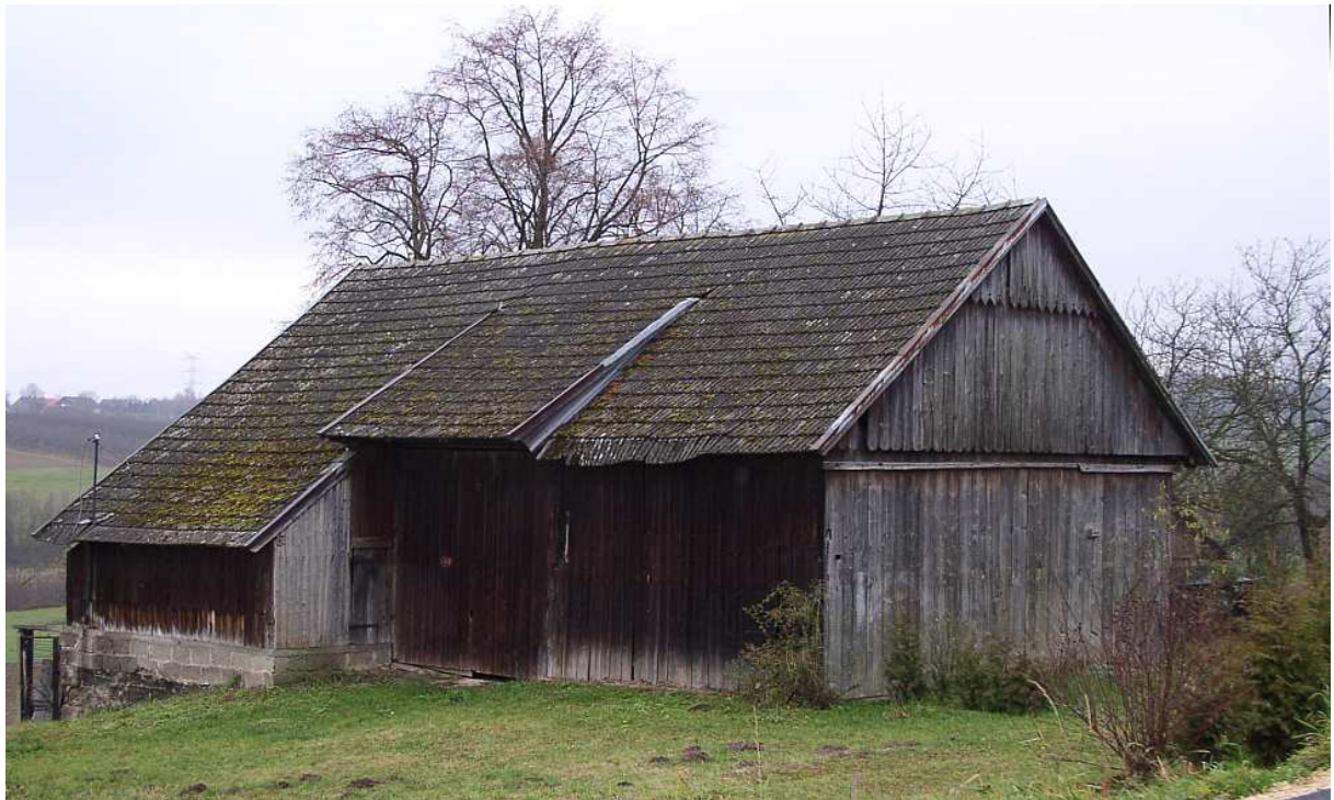
Fot. nr 94. Stodoła w danej zagrodzie na posesji pod nr 108. (07.12.2009)
