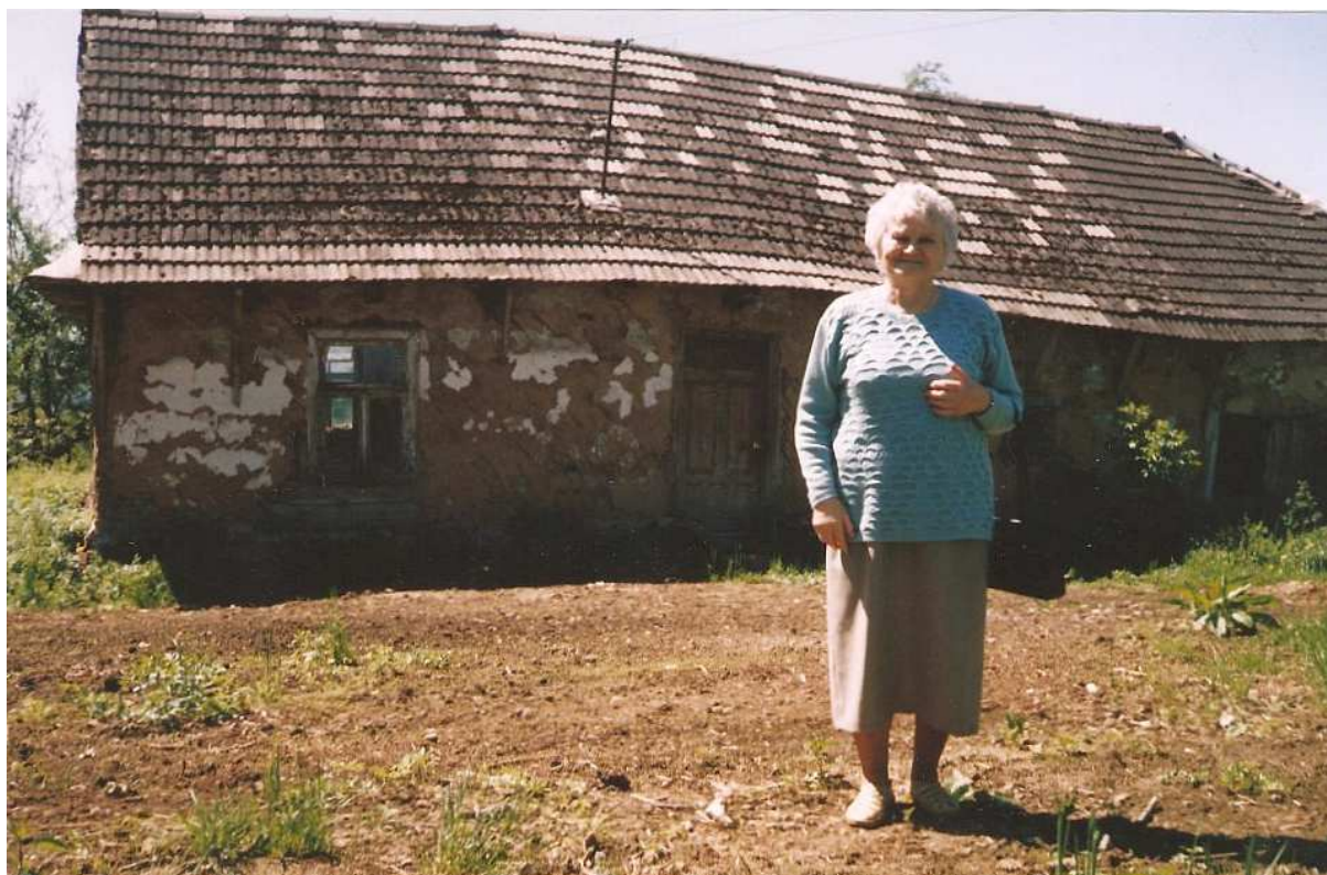
Fot. nr 198 (198-204). Chałupa z Górki Kunickiej (dziś ulica Graniczna 3?), przebudowana zapewne pod koniec lat 20. XX wieku o czym świadczą okna trójskrzydłowe. Na przełomie III. i IV. dekady XX wieku tu mieszkały podolańskie rodziny: Ludwika Wojasa i Piotra Gądka To tu kilka lat swego dzieciństwa spędziła widoczna na zdjęciu Genowefa Budek, najmłodsza córka Antoniny Chanek i Ludwika Wojasa. Fot. nr: 201-204– ujęcia od strony lokalnej drogi. Tu zdjęcie z wiosny roku 2005.
