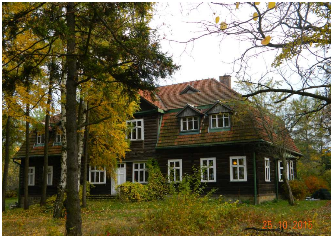
Fot. nr 304. Tylna część budynku dworskiego.
