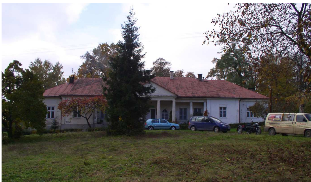
Fot. nr 225. Fasada. (31.10.2009)
