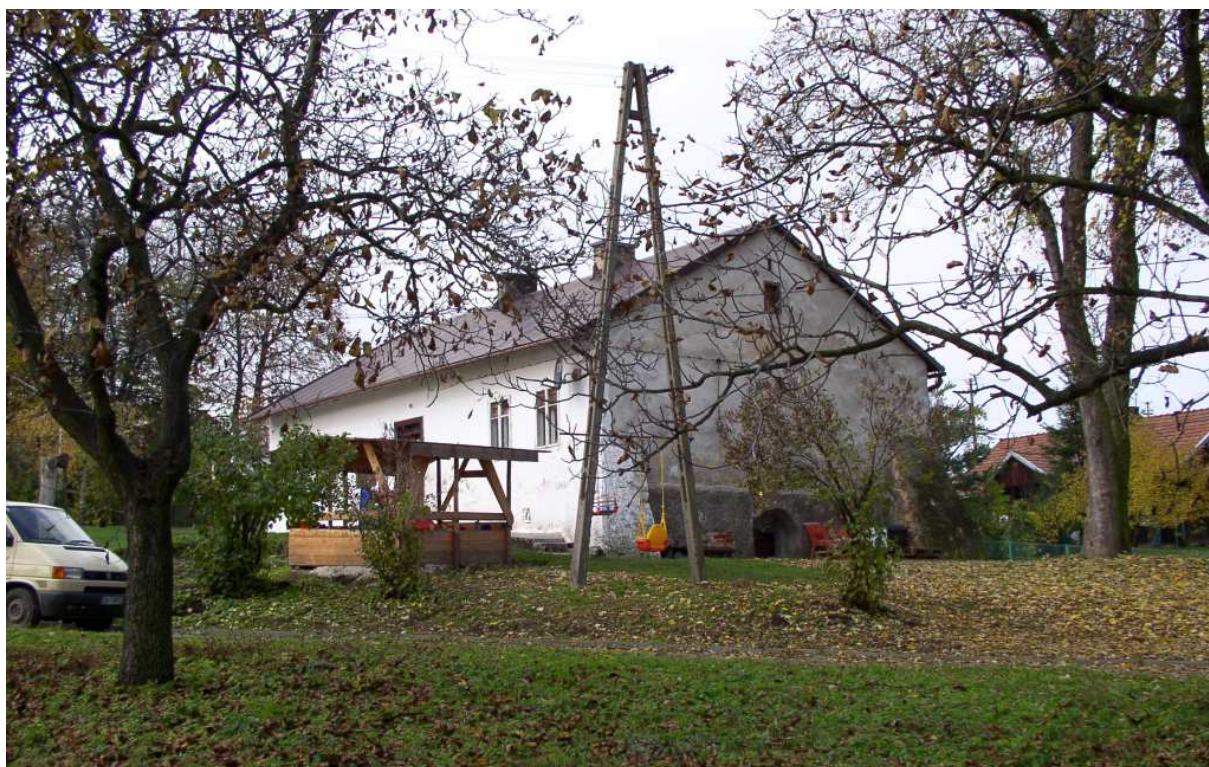
Fot. nr 223. Front budynku. (31.10.2009)
