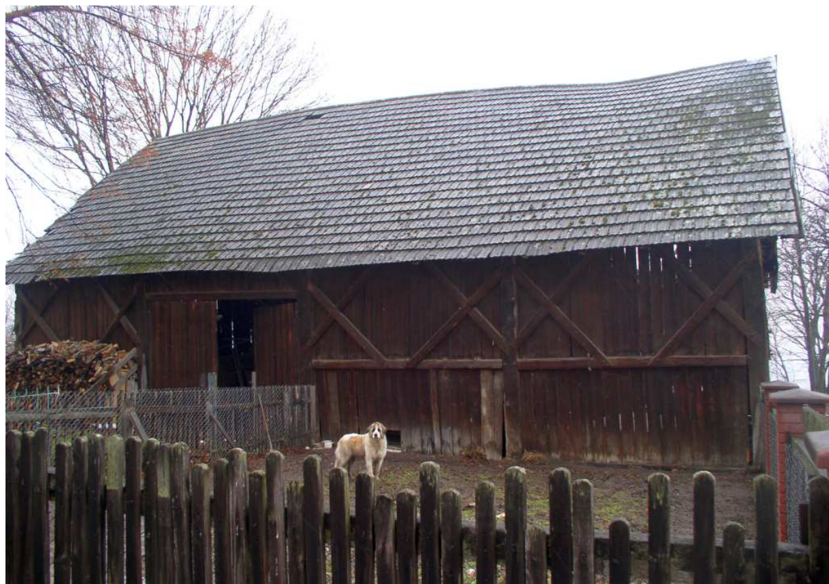
Fot. nr 252 (252-255). Ostatnie chwile stodoły plebańskiej w sąsiedztwie kościoła. (27.02.2010)
