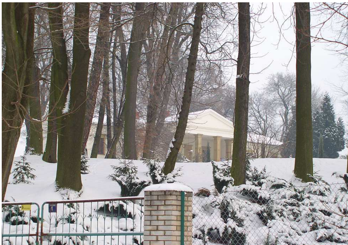
Fot. nr 58 (58-61). Widoczna z oddali fasada dworu Przychodzkich, potem Dunikowskich i Kopaczyńskich, który został przebudowany w II połowie XIX. wieku. (18.01.2010)
