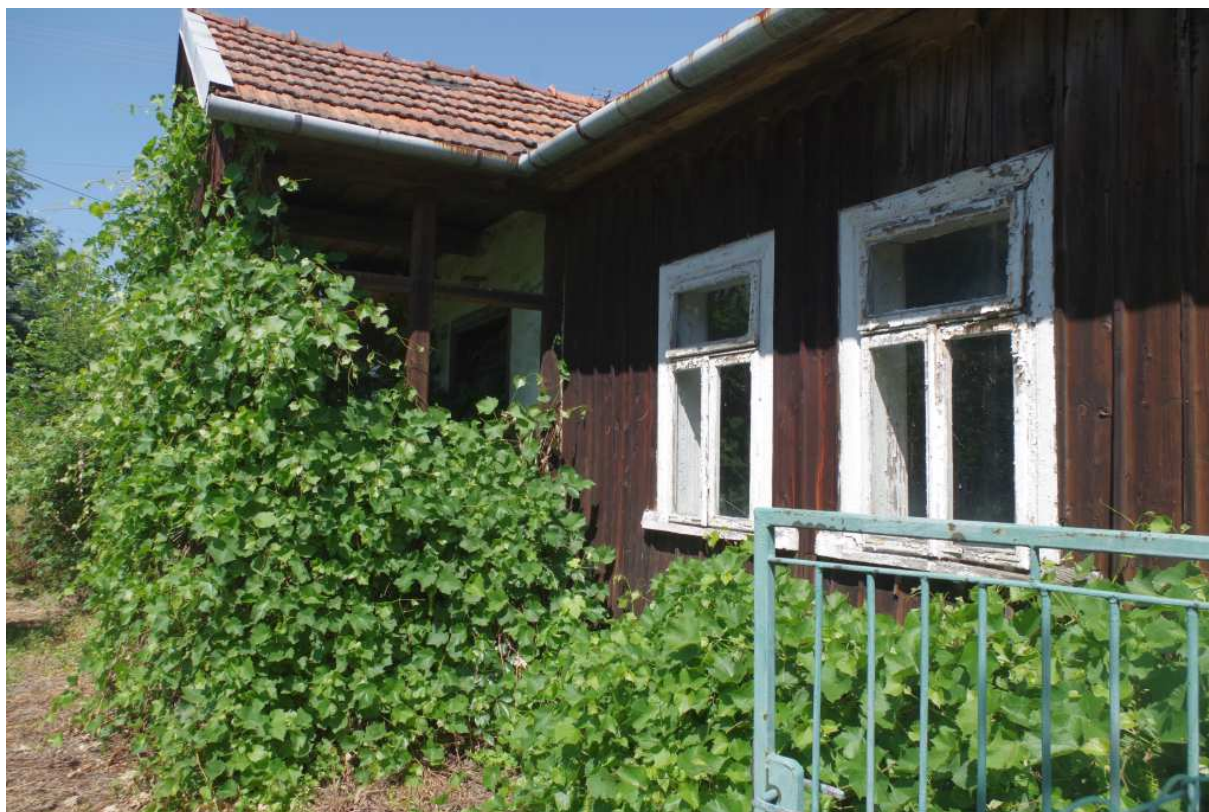
Fot. nr 267. Trójskrzydłowe okna.
