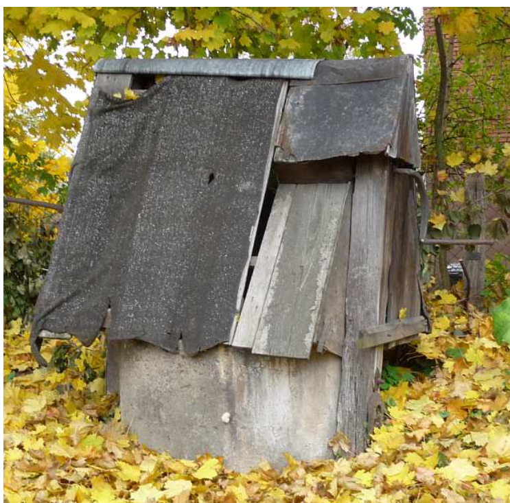
Fot. nr 133. Studnia na podwórku przed stodołą. (31.10.2011)
