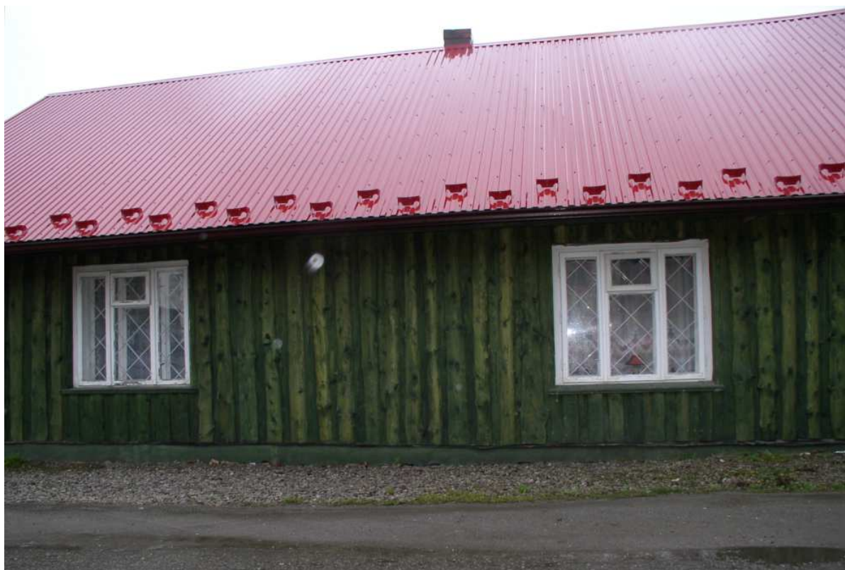
Fot. nr 291. Fragment oszalowanej fasady domu pod nr 17. (21.12.2008)
