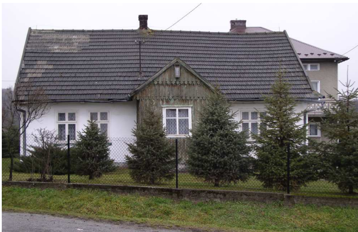
Fot. nr 87. Fasada domu, który mógł powstać w III. dekadzie XX wieku. (21.12.2008)
