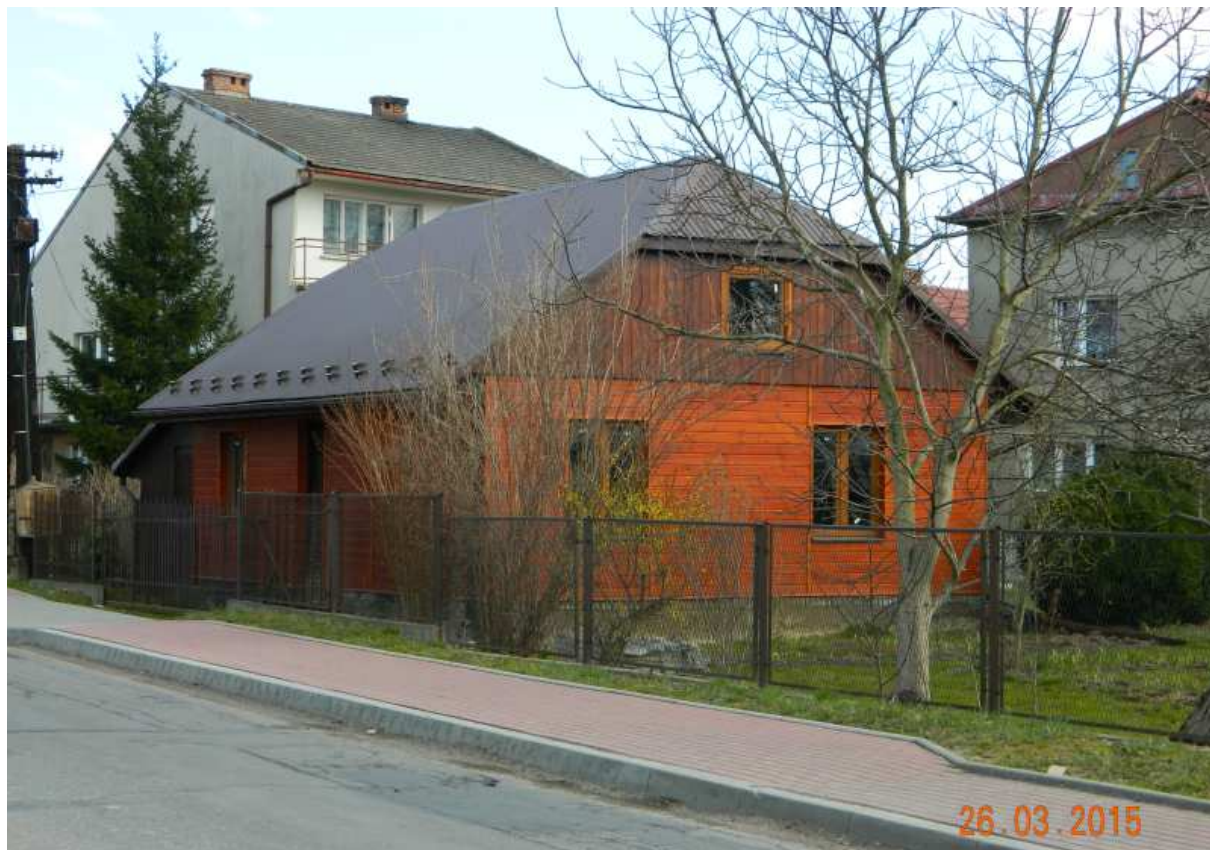
Fot. nr 52. Widok z ulicy Cegielnianej.
