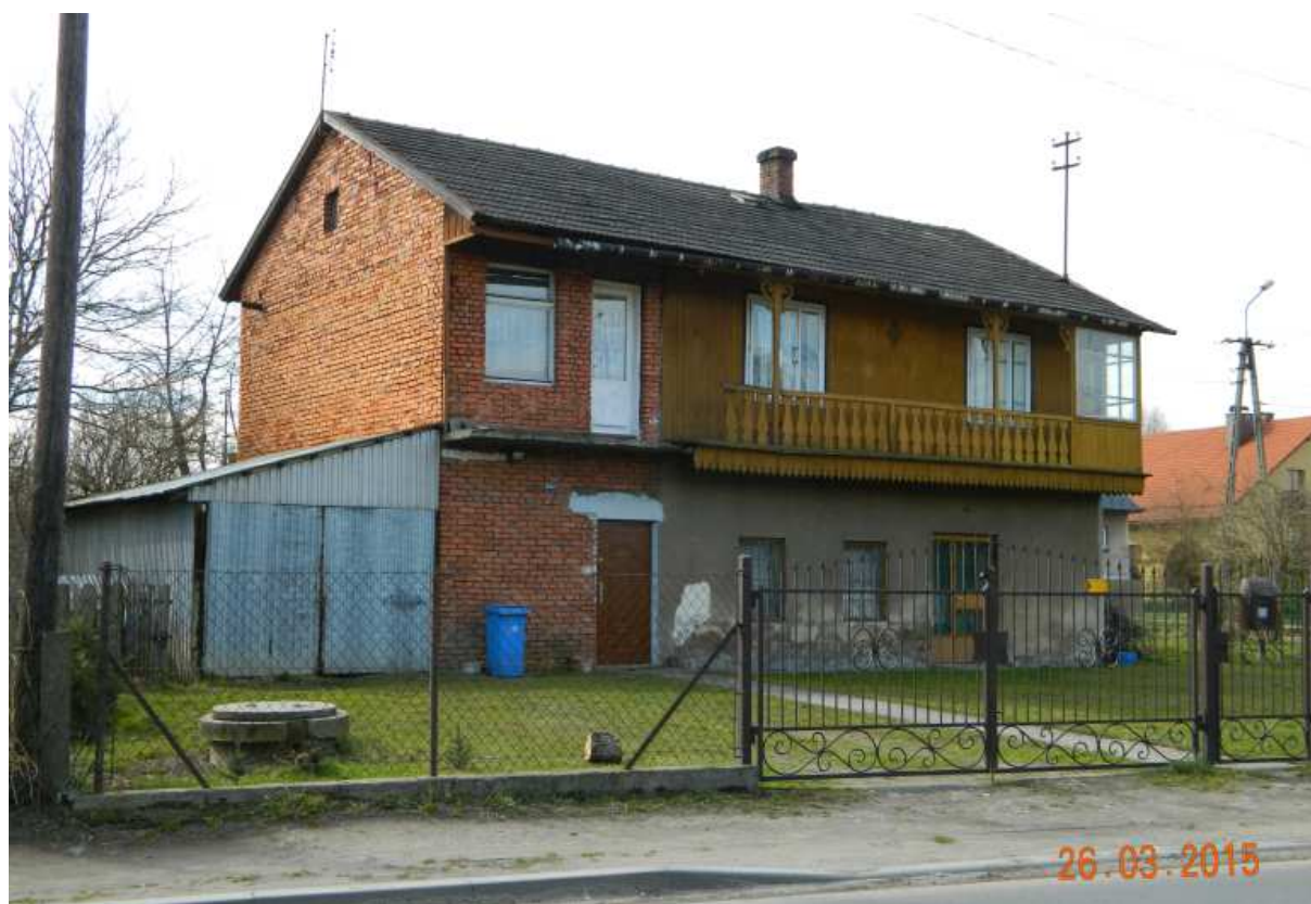
Fot. nr 125 (125-126). Częściowo przebudowana willa spod nr 345.
