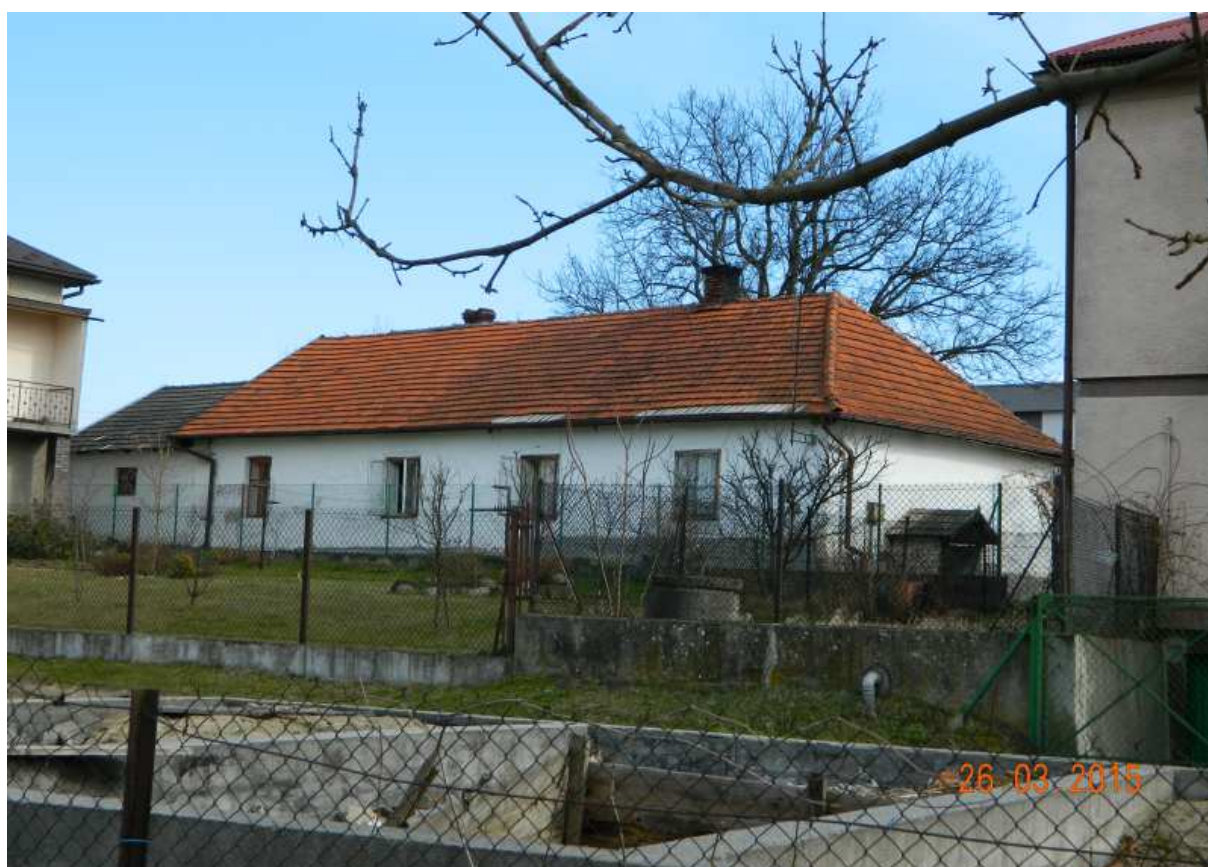
Fot. nr 39. Tył domu pod nr 188 z ulicy Bocheńskiej.
