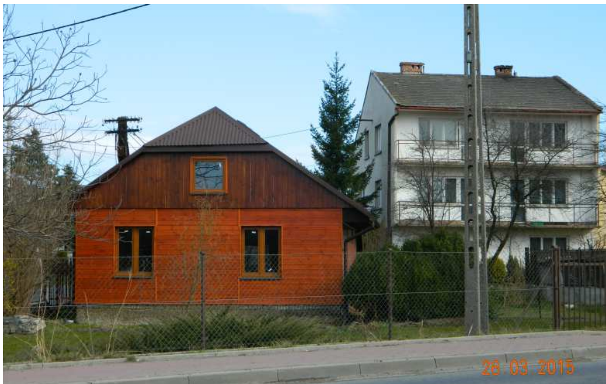
Fot. nr 51 (51-52). Przebudowany dom drewniany spod nr 316, który zajmuje naroże ulic: Bocheńskiej i Cegielnianej.
