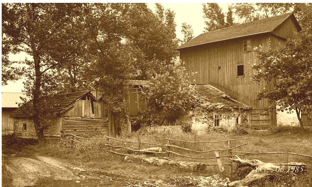
Fot. nr 3a (3a-3c). Dawny młyn Stefana Wojasa i przylegający do niego dom jego mieszkalny oraz zabudowania gospodarcze w ujęciach od zewnętrznej strony dziedzińca. (1985)
