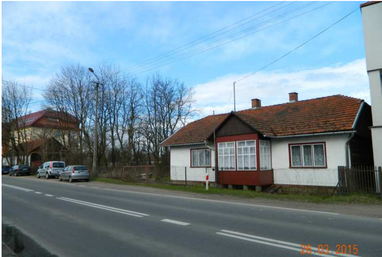
Fot. nr 50. Dom pod nr 131, którego początki z pewnością sięgają czasów przedwojennych.
