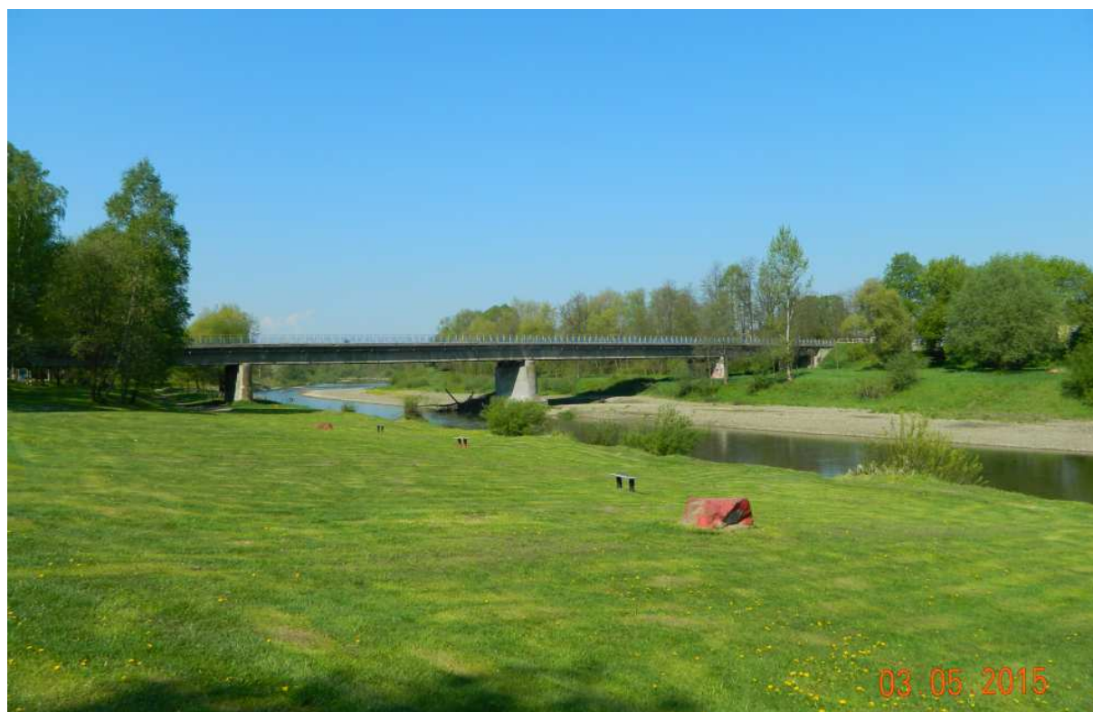
Fot. nr 162. Most na Rabie w Gdowie.
