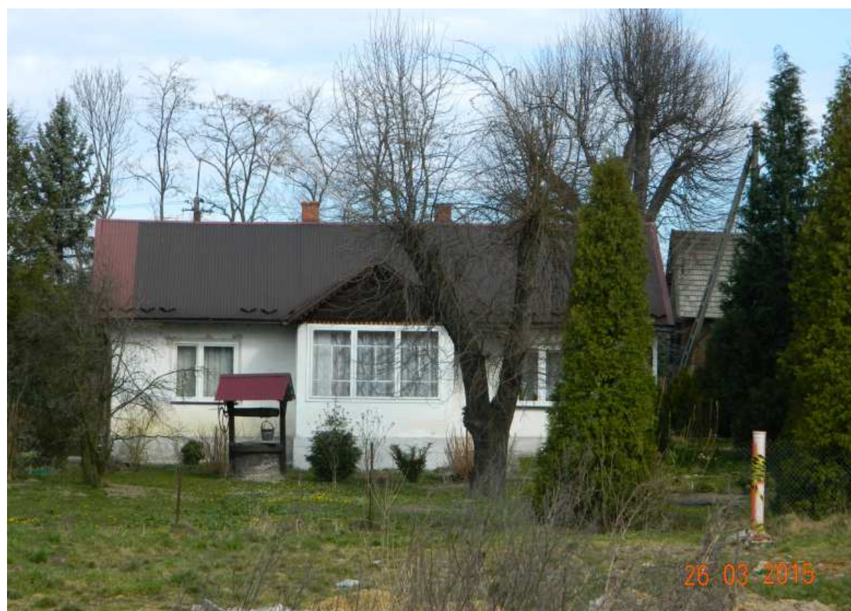
Fot. nr 37. Nieco już przebudowany dom pod nr 323.
