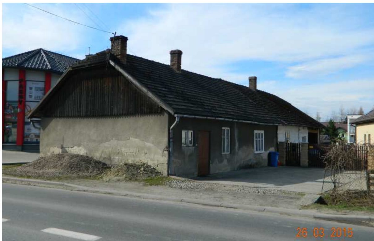
Fot. nr 96 (96-97). Tylna część domu.
