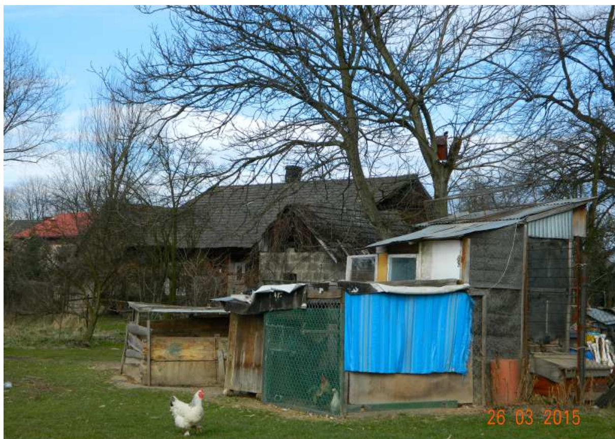
Fot. nr 61. Widok od strony Podwórka.
