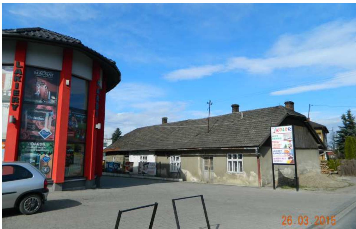
Fot. nr 93 (93-97). Dom pod nr 64 w narożu ulic: Łapanowskiej i Zacisze. Pawilon handlowy powstał niedawno w miejscu dawnego Baru Zacisze.
