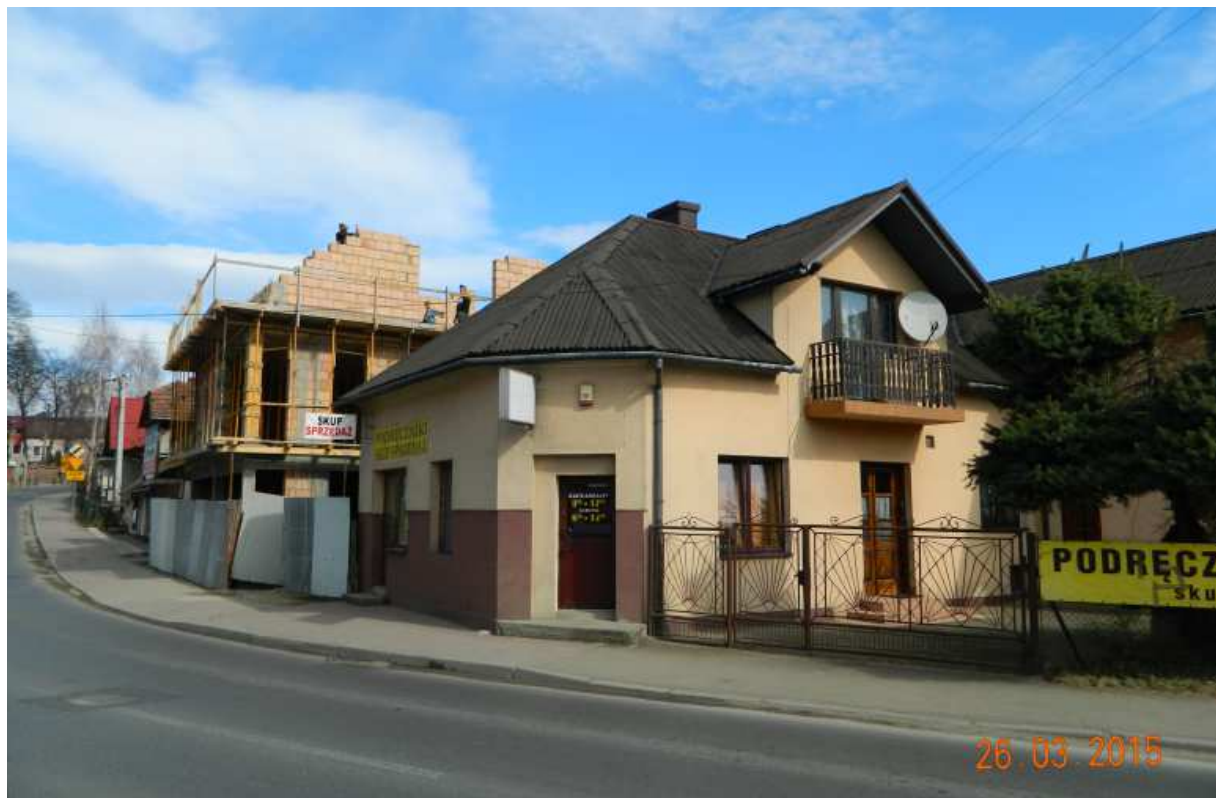
Fot. nr 131. Trwa przebudowa ulicy Łapanowskiej w sąsiedztwie wylotu ulicy Młyńskiej. Na pierwszym planie dawna piekarnia pod nr 56 i nowy dom pod 331, który powstaje w miejscu drewnianego poprzednika.
