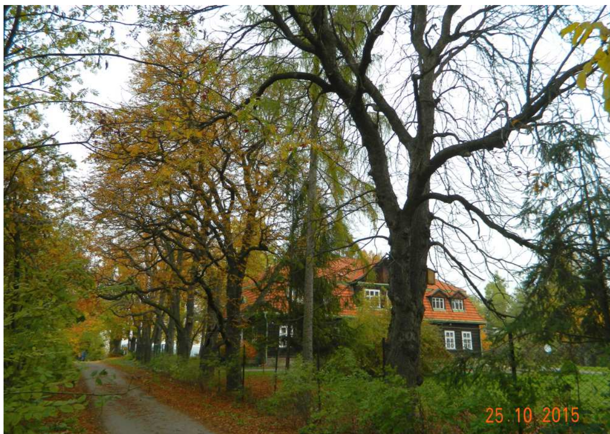
Fot. nr 190 (190-195). Dwór Feillów – tu widok od strony drogi.
