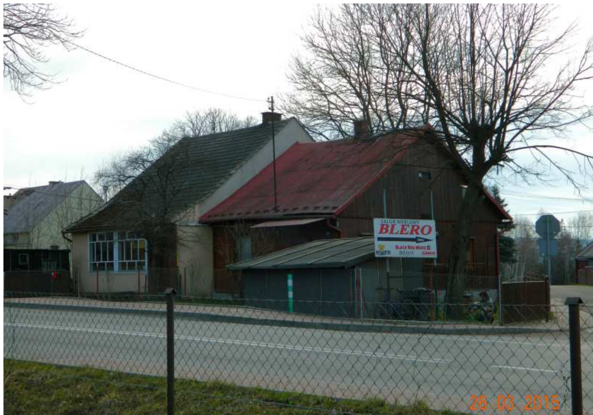
Fot. nr 54 (54-56). Przebudowany dom z naroża ulic: Bocheńskiej i Obrytka (pod nr 186).
