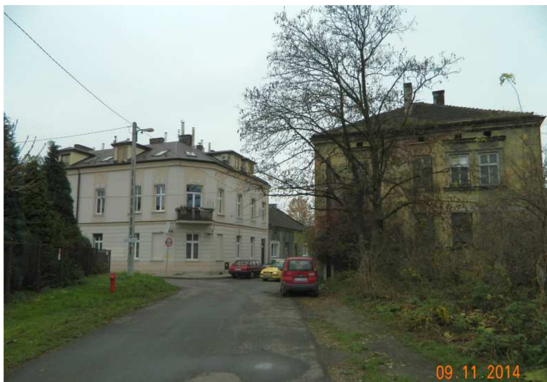
Fot. nr 157. Widok od strony Wilgi na styk z ulica Swoboda.
