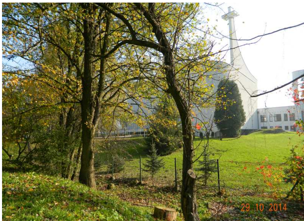
Fot. nr 151 (151-153). Kościół p.w. Matki Boskiej Fatimskiej i czytelne pozostałości wału oraz fosy ziemnego fortu piechoty (N) - St III przy ulicy Komandosów 18.
