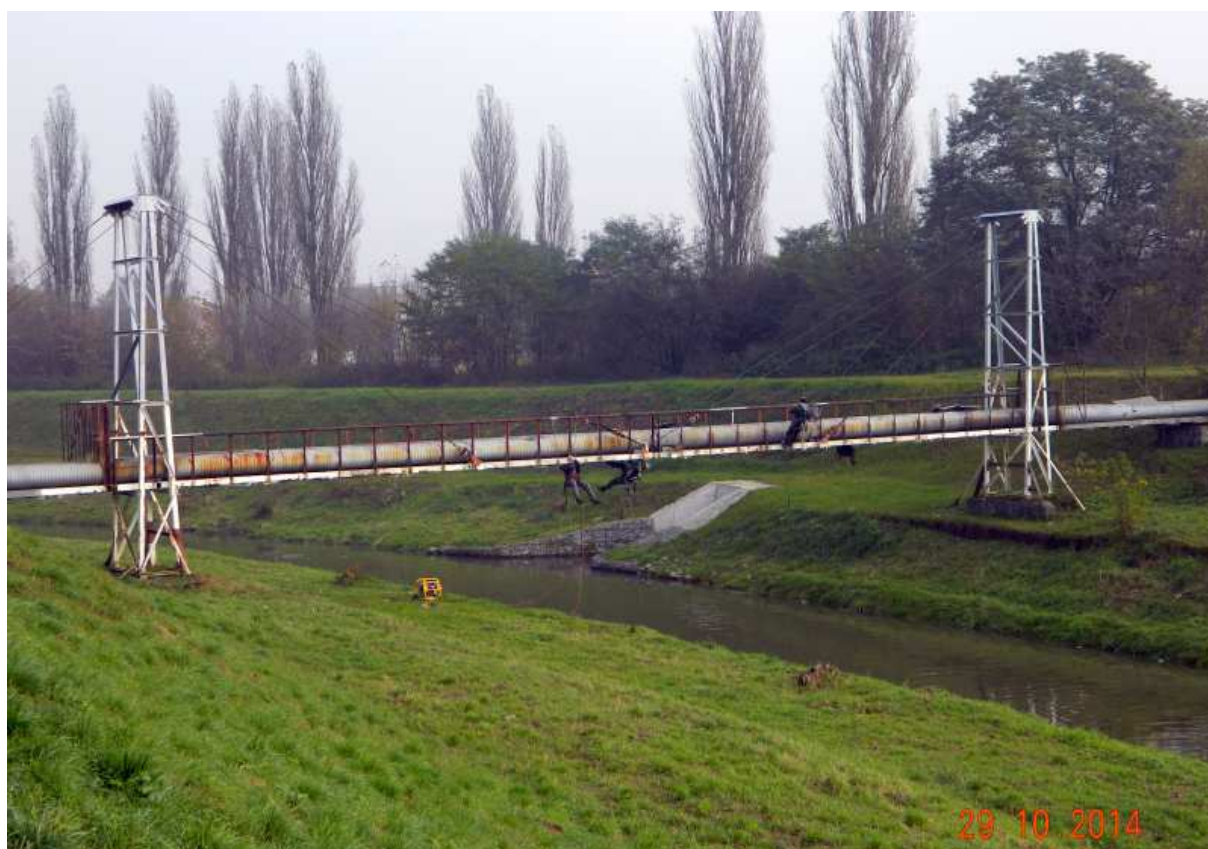
Fot. nr 137. Rurociąg na wysokości uzdrowiska na Matecznym.
