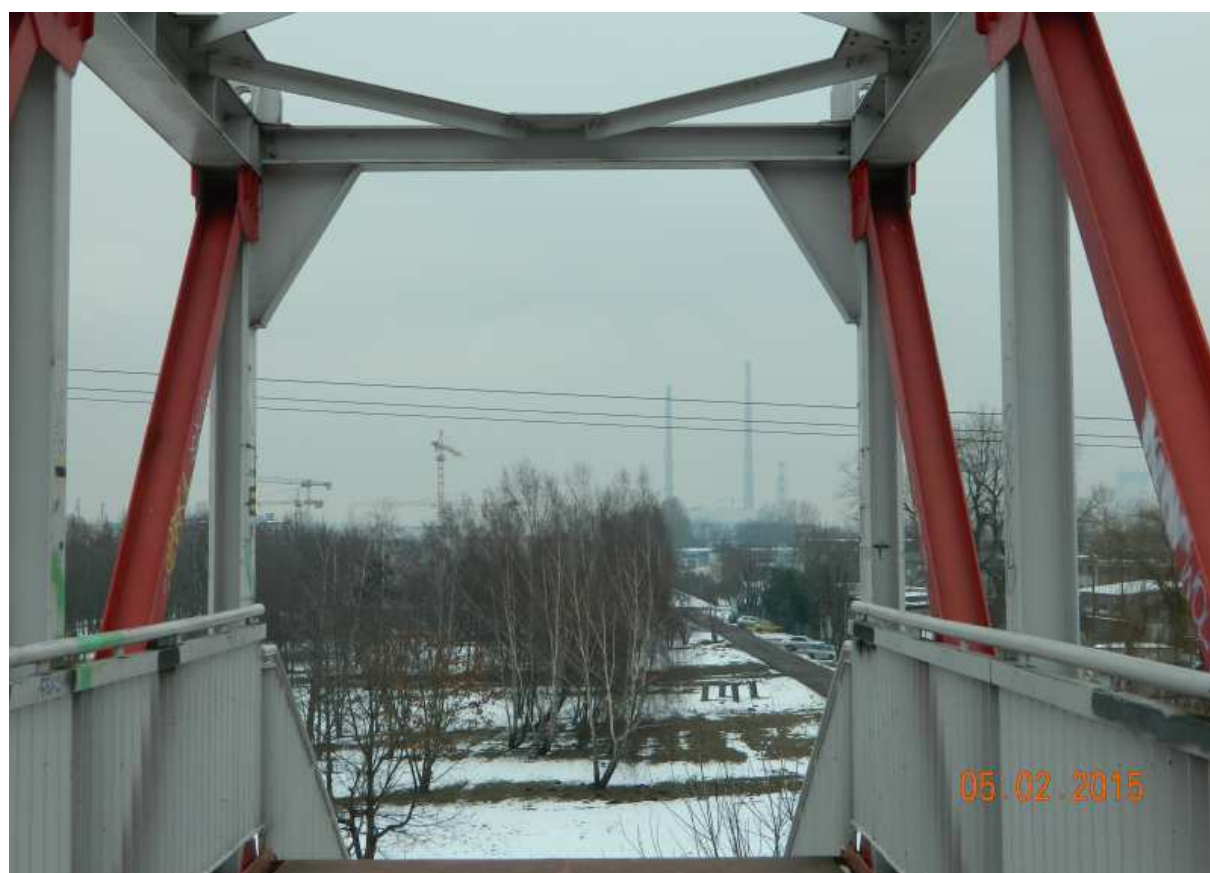
Fot. nr 282. Kominy elektrociepłowni w Łęgu.
