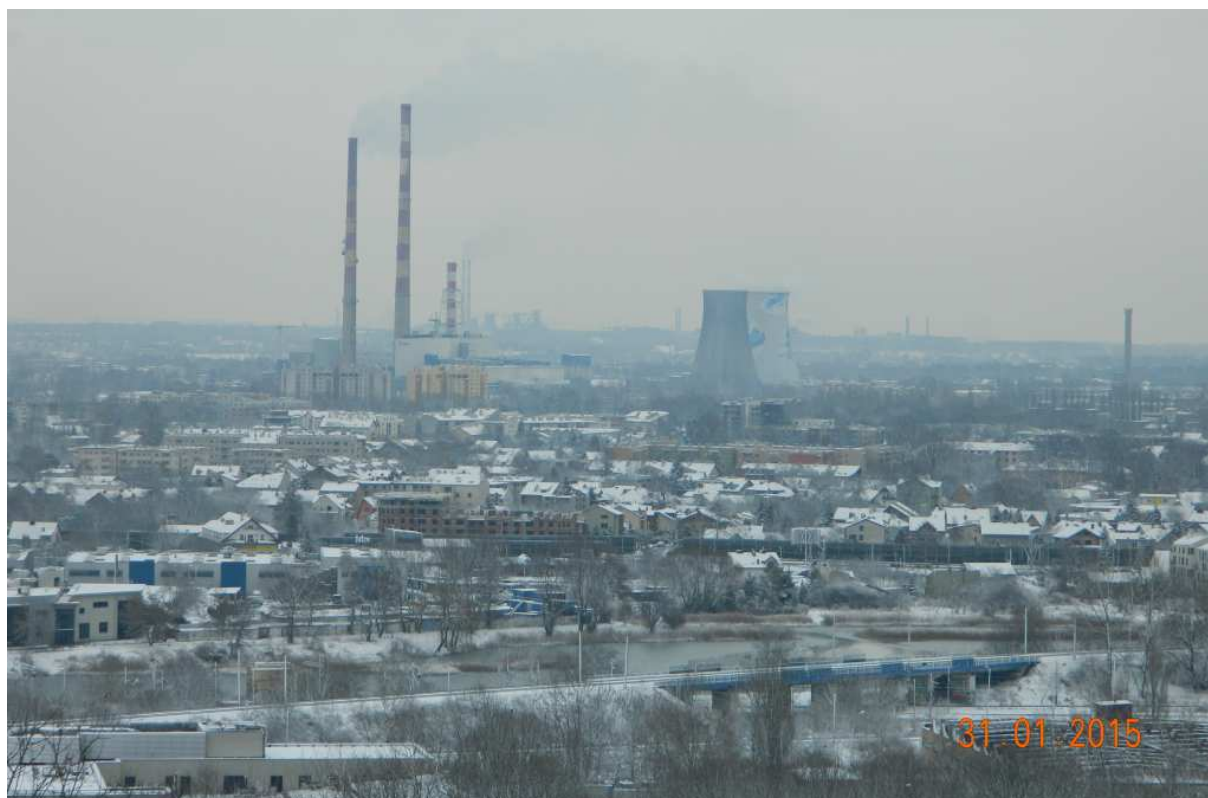
Fot. nr 219. Elektrociepłownia w Łęgu.
