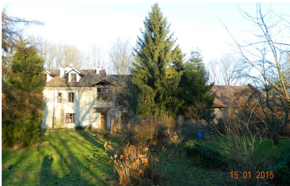
Fot. nr 254 (254-263). Stary Dwór Bemów. Fot. nr: 254-256 - fasada od strony ulicy Laszczki.
