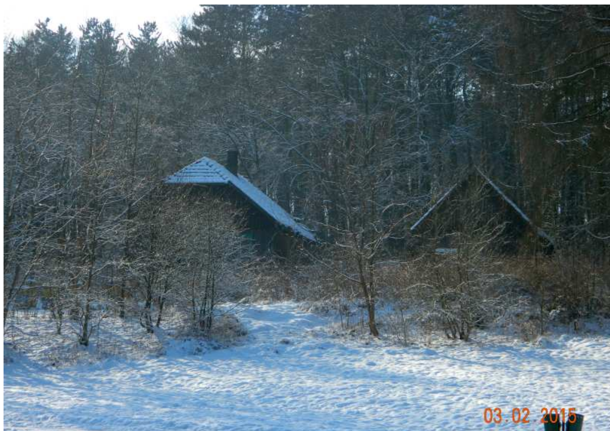
Fot. nr 121 (121- 122). Zakrywana przez zarośla powojenna leśniczówka przy ulicy Do Groty.
