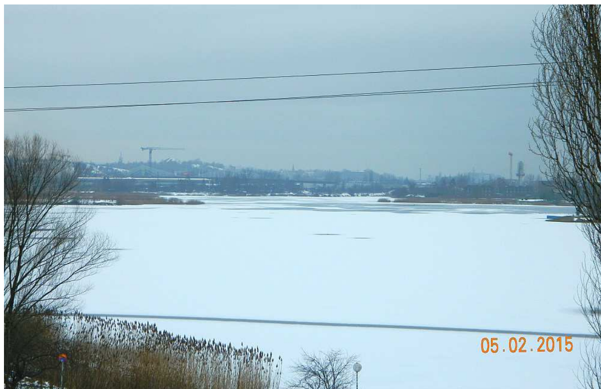
Fot. nr 279 (279-281). Nowa estakada w budowie ponad taflą Bagrów.
