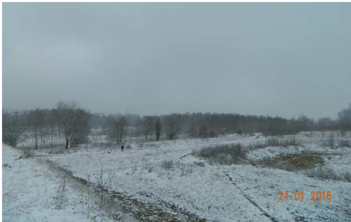
Fot. nr 331. Widok z nasypu ziemnego przy placu budowy w stronę ulicy Słona Woda
