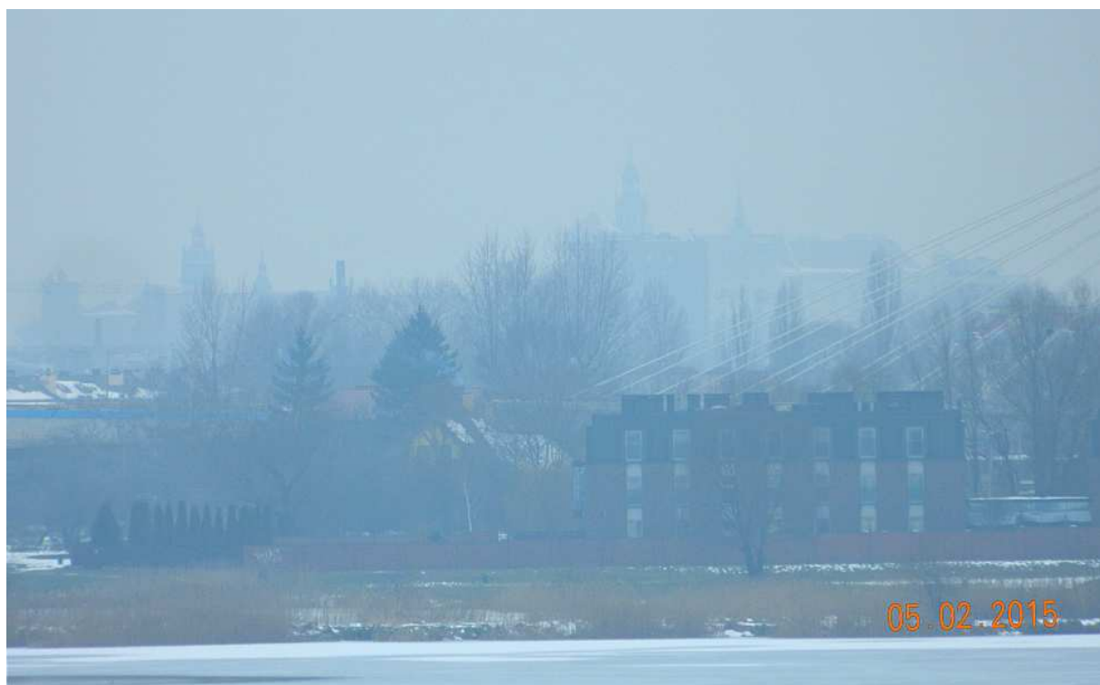
Fot. nr 280 (280-281). Liny konstrukcji mostowej ponad klasztorem Trynitarzy.
