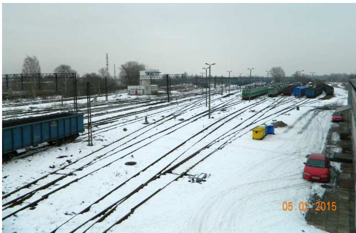
Fot. nr 313 (313-318). Widoki z kładki nad torami kolejowymi stacji rozrządowej w Prokocimiu. Fot. nr: 313-315 – w stronę Biezanowa.
