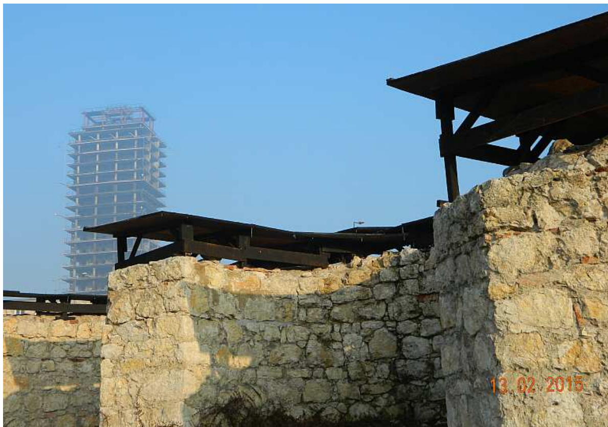
Fot. nr 36 (36-39). Różne ujęcia „szkieletora”. Fot. nr: 36-37 - ponad pozostałością fortu mogilskiego.
