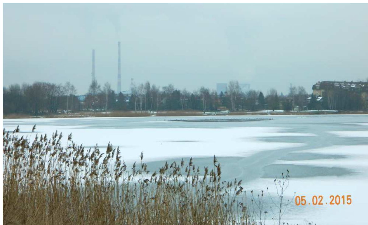
Fot. nr 289. Kominy elektrociepłowni w Łęgu.
