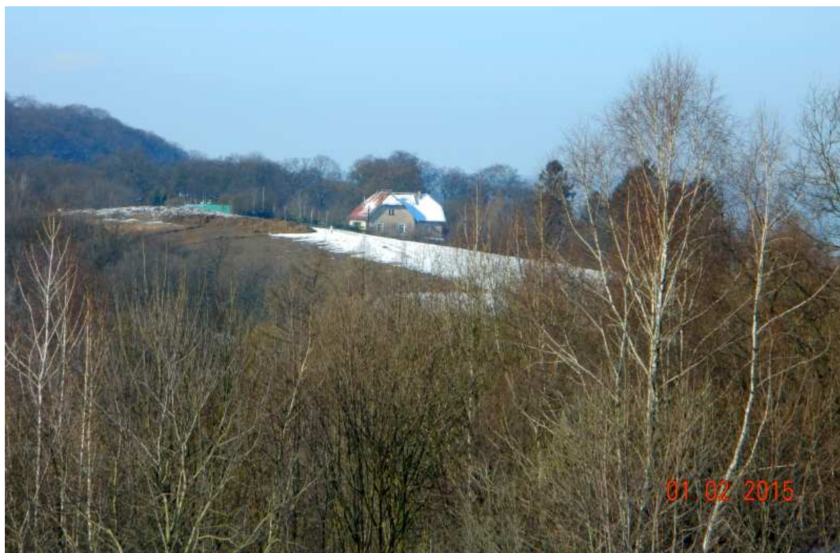
Fot. nr 109. W stronę leśniczówki przy ulicy Kukułczej, gdzie trwają jakieś roboty ziemne.
