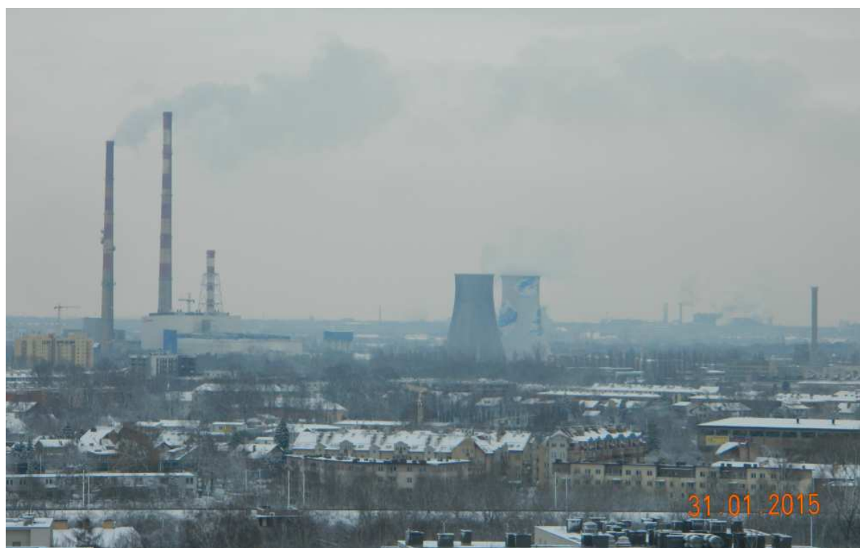
Fot. nr 246. Elektrociepłownia w Łęgu, a w tle dawny kombinat metalurgiczny w Nowej Hucie (dziś Arcelor Mittal).
