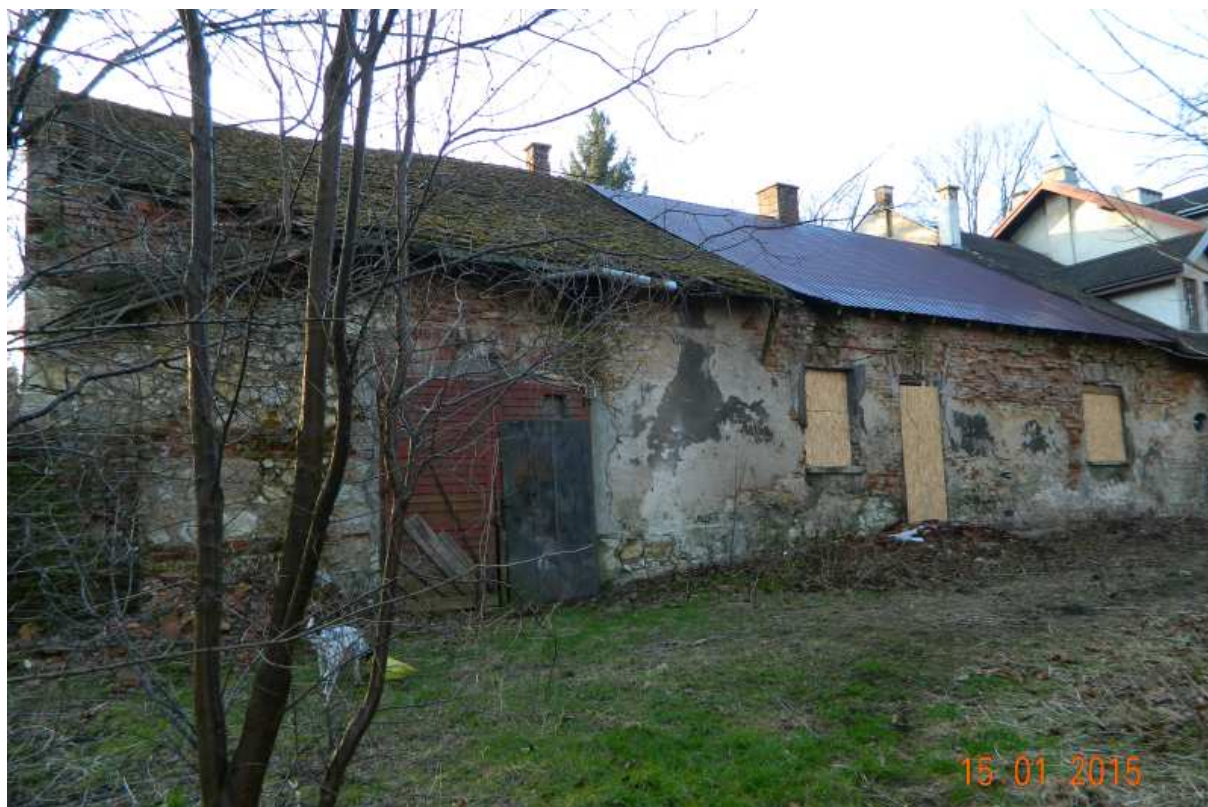
Fot. nr 261 (261-263). Wozownia – widoki od strony parku.
