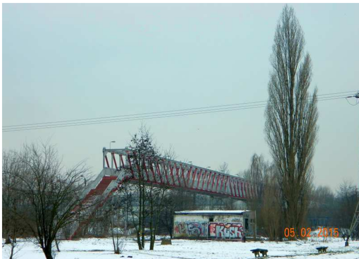
Fot. nr 312. Most nad torami kolejowymi likwidowanej stacji rozrządowej w Prokocimiu.
