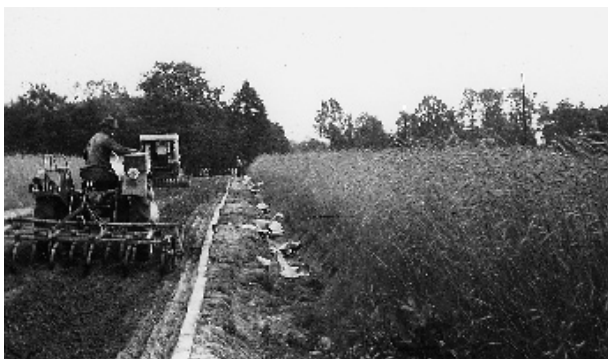
Teraz to wszystko trzeba dobrze wymieszać. Kultywator za ciągnikiem dobrze wykonają to zadanie.
