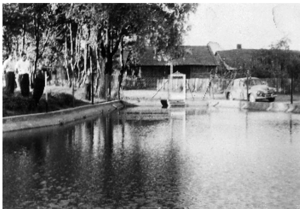
Zbiornik przeciwpożarowy w Zakrzowie.
