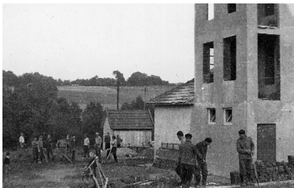
Prace społeczne przy budowie remizy w Sufczyźnie.
