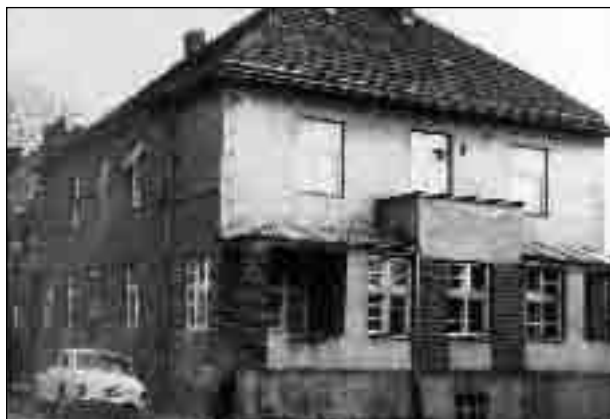
Właściwy budynek Ośrodka Zdrowia w Brzesku przy ul. 1 Maja.
