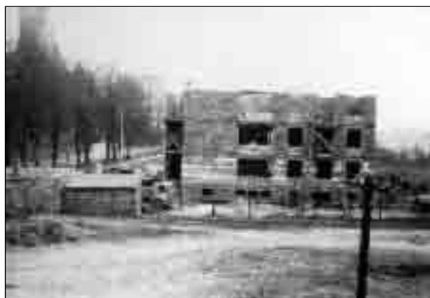
Ośrodek Zdrowia w Szczepanowie w budowie.
