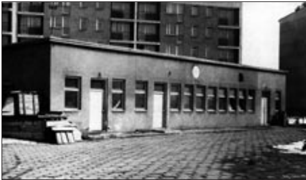
Powiatowa Spółdzielnia Pracy Nowość – zakład produkcji wyrobów z gumy przy ul. Mickiewicza w Brzesku.
