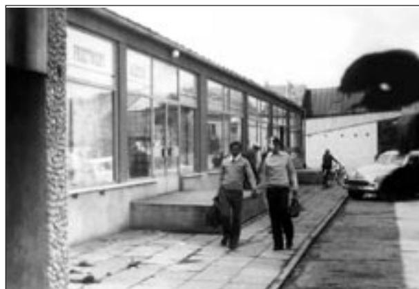
Pawilon Handlowy Gminnej Spółdzielni w Zakliczynie.
