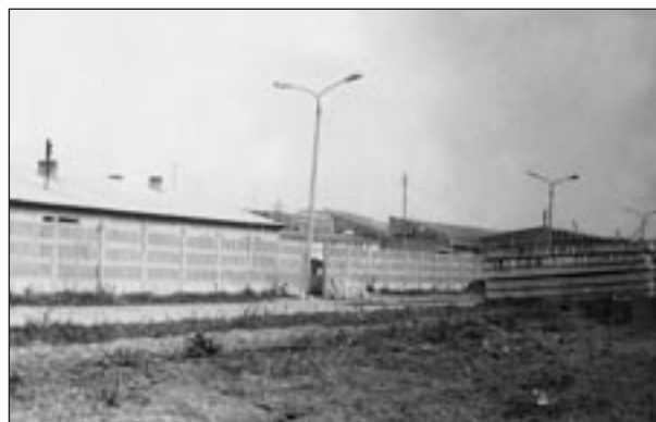
Zakłady Naprawcze Taboru Samochodowego w Brzesku – fragment budowy.
