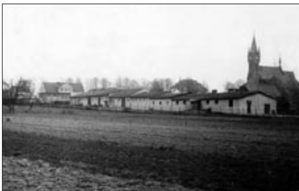
Sklepy i magazyny towarów masowych Gminnej Spółdzielni w Szczepanowie.
