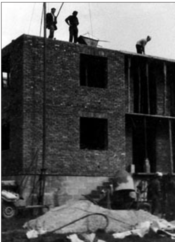
Budowa domu w Jadownikach, gmina Brzesko.
