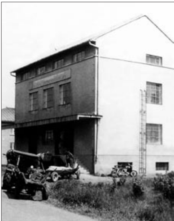
Przebudowany i unowocześniony młyn gospodarczy w Borzęcinie prowadzony przez Gminną Spółdzielnię.
