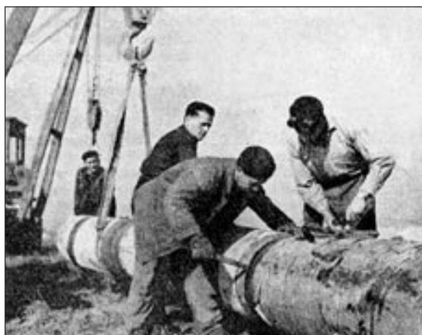
Prace przy układaniu rurociągu gazowego na terenie powiatu.
