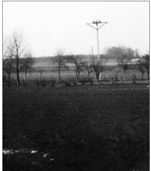
Pierwsza linia energetyczna Szczepanów-Brzesko w Szczepanowie. Ten odcinek linii i transformator postawili pracownicy Zarządu Gminy w czynie społecznym.
