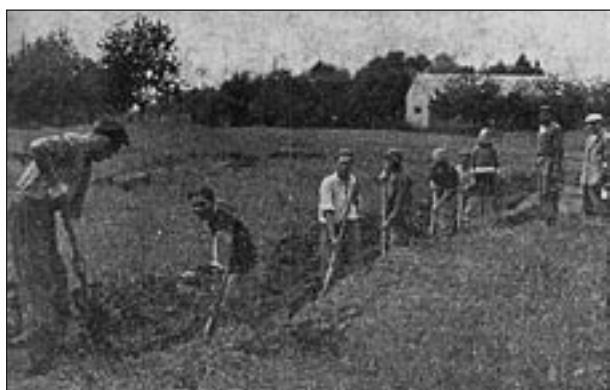
Prace przy drenowaniu pól.
