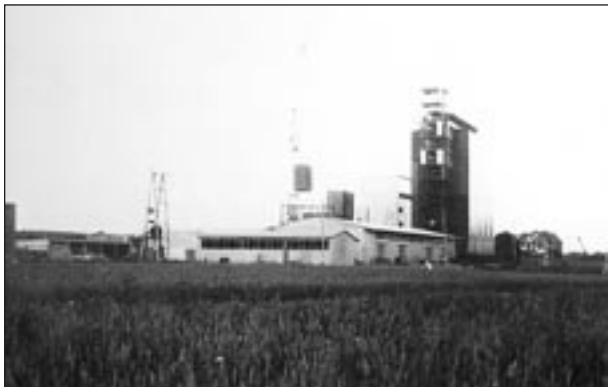
Wytwórnia Pasz Treściowych BACUTIL w Brzesku – w budowie.
