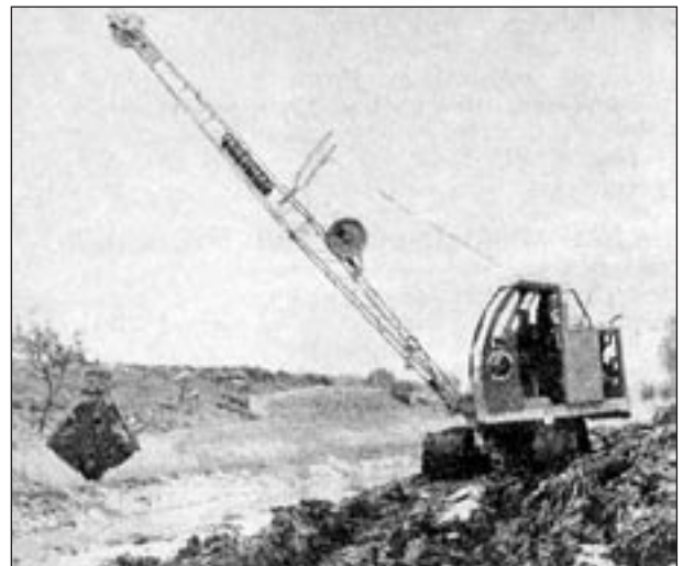
Regulacja rzeki Uszewki na terenie wsi Mokrzyńska – przysiółek Kosiarnia – sprzętem mechanicznym.
