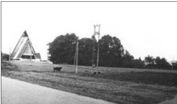
Sieć energetyczna w Rudy-Rysiu.
