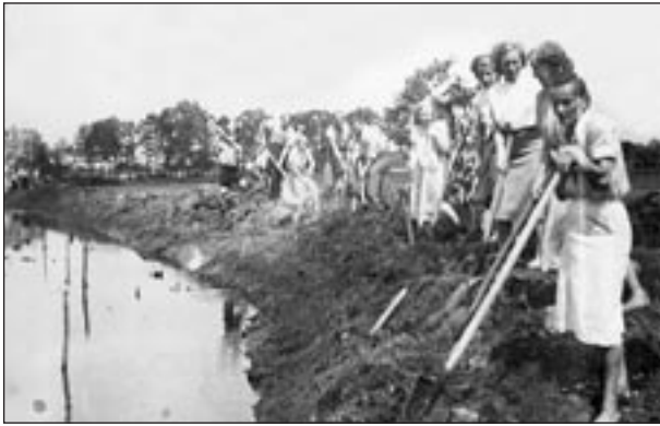
Prace przy regulacji Uszewki w Buczu. Pracują społecznie pracownicy Prezydium GRN i Gminnej Spółdzielni ze Szczepanowa.
