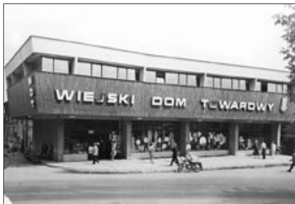
Wiejski Dom Towarowy Gminnej Spółdzielni Samopomoc Chłopska w Zakliczynie.
