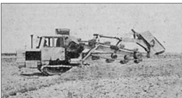
Mechaniczne kopanie rowów drenarskich na terenie wsi Strzelce Wielkie.
