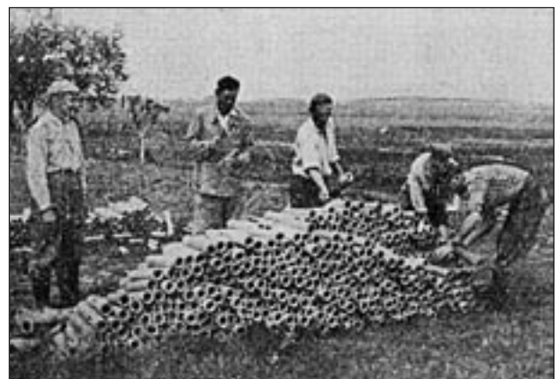
Prace drenarskie na terenie wsi Dębno – przygotowanie rurek drenarek.
