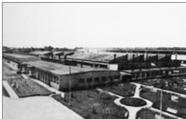
Fabryka Opakowań Blaszanych – Widok ogólny.
