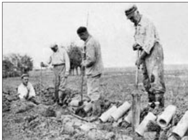
Ręczne kopanie rowków.
