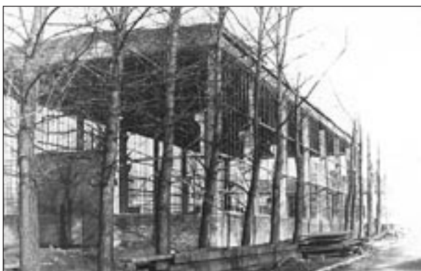
Hala remontu kombajnów – w budowie.
