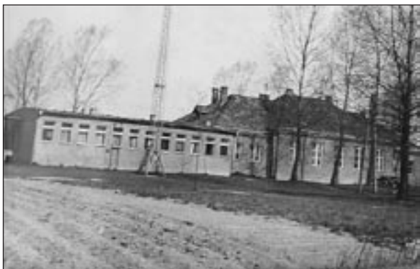
Państwowy Ośrodek Maszynowy w Dębnie. Budynek administracyjny.
