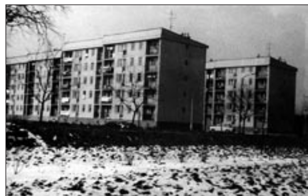
Osiedle mieszkaniowe przy ul. Ogrodowej w Brzesku.
