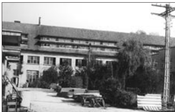
Zakład Ceramiczny Kamionka w Łysej Górze – budynek produkcyjny.
