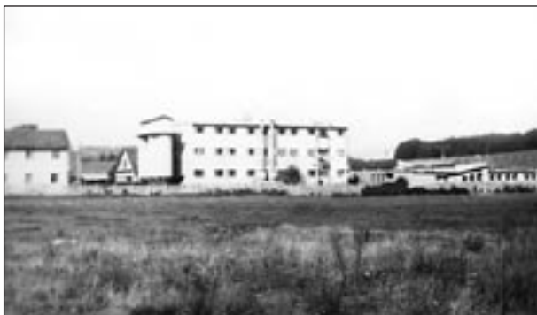
Ogólny widok zakładu z nowymi budynkami.
