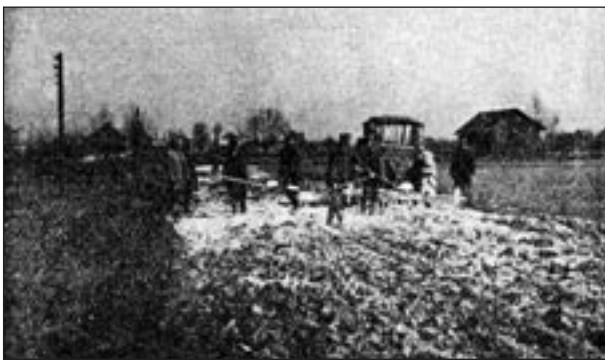
Praca przy budowie drogi lokalnej w Pojawiu systemem eksperymentalnym (utwardzanie nawierzchni cementem), podobnie jak w Buczu.
