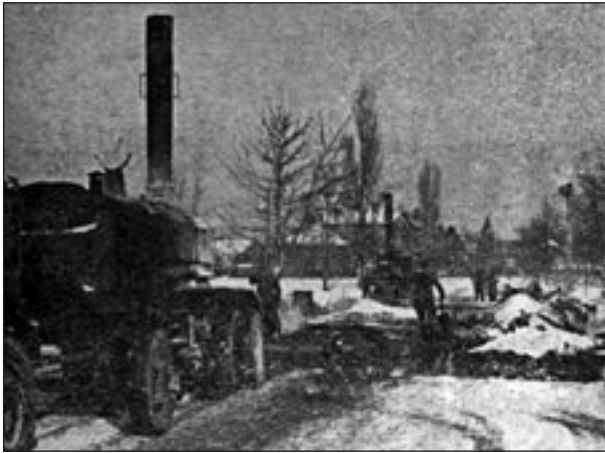
Praca przy budowie drogi państwowej.
