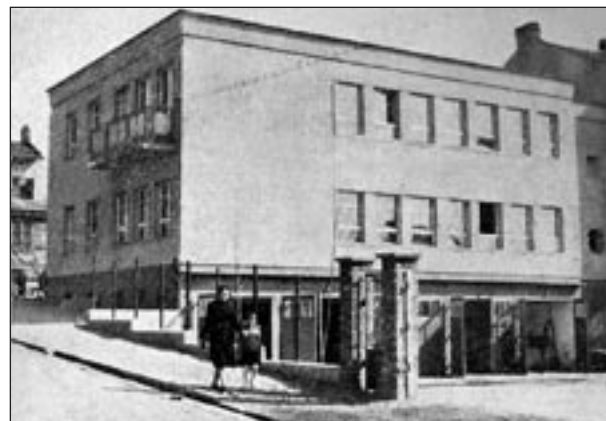
Budynek Pogotowia Ratunkowego w Brzesku.
