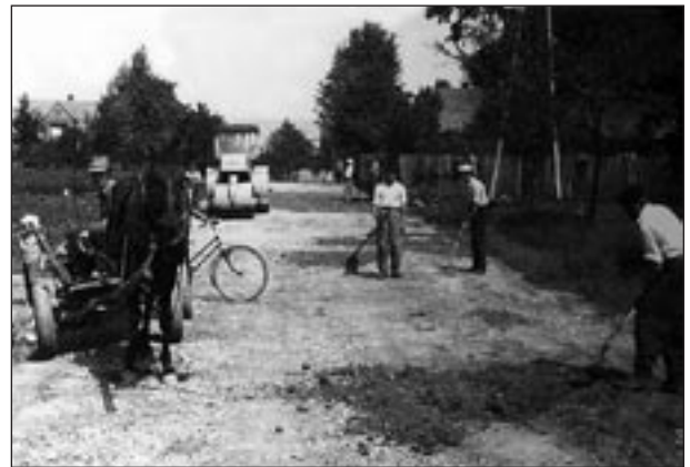
Prace przy budowie drogi przez wieś w Przyborowie i Jastwi.
