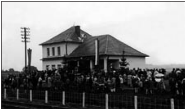
Uroczystość otwarcia przystanku kolejowego w Jasieniu pow. Brzeski dnia 29.V.1960 r. Udział biorą mieszkańcy Jasienia pow. Brzesko i mieszkańcy Jodłówki powiat Bochnia.
