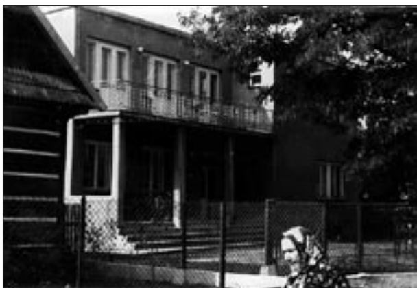
Dom Ludowy w Marcinkowicach.
