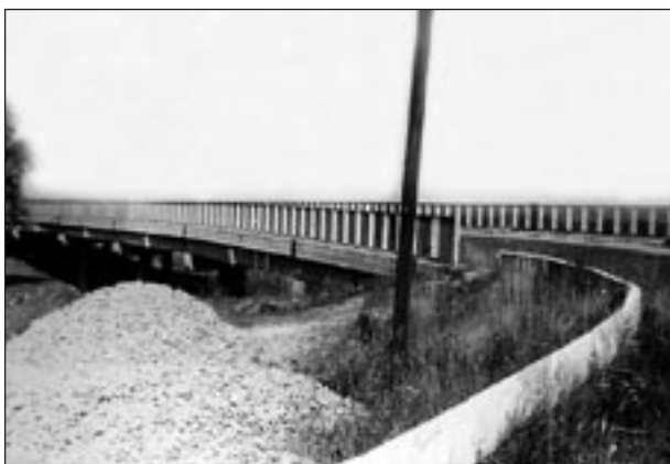
Most na Uszwicy w miejscowości Szczurowa-Włoszyn.
