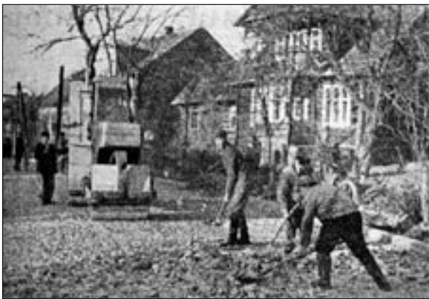
Budowa nawierzchni na drodze państwowej.
