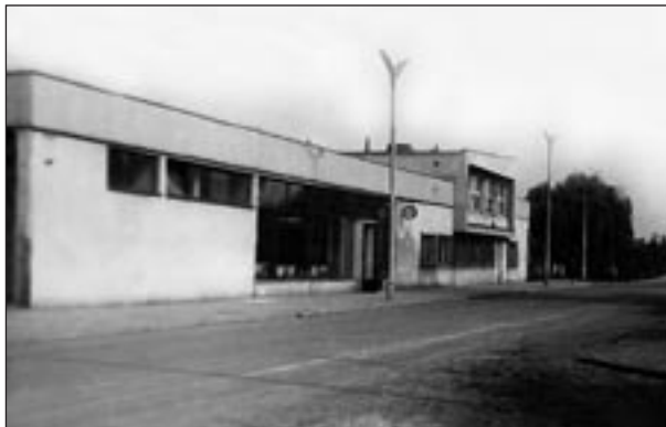
Dworzec kolejowy w Brzesku.
