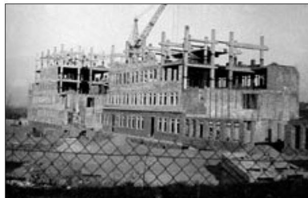
Szpital Powiatowy w Brzesku w budowie.
