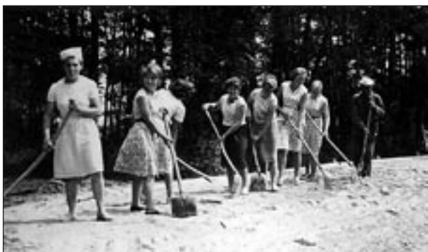
Rozsypywanie cementu.
