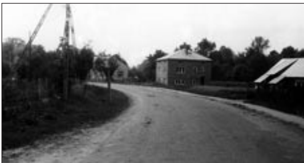
Droga lokalna wiejska w Zaborowie.
