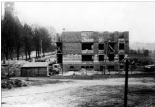
Ośrodek Zdrowia w Szczepanowie w budowie.
