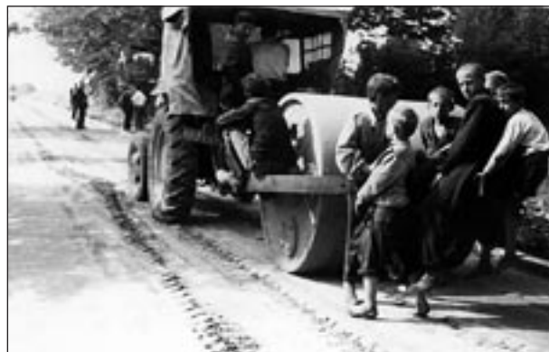
Walcowanie nawierzchni.
