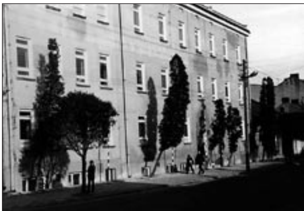
Budynek Szpitala Powiatowego w Brzesku wyremontowany ostatnio kosztem ok. 11 mln zł przy ul. Kościuszki.
