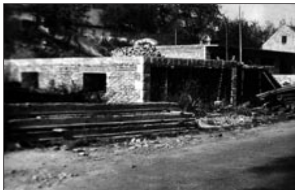
Budynek Apteki w Czchowie w budowie.
