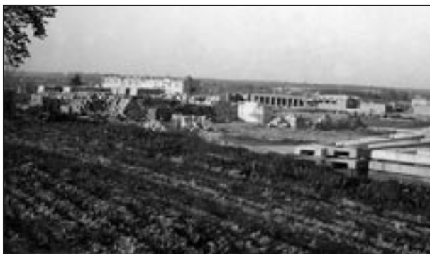
Szpital Powiatowy w Brzesku w budowie.
