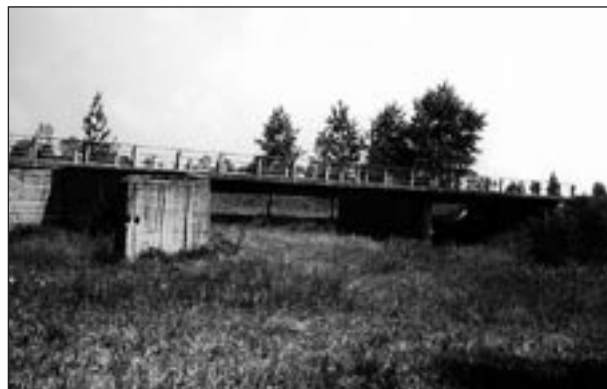
Most na Uszwicy w Wokowicach.
