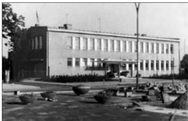
Budynek Komitetu Powiatowego Polskiej Zjednoczonej Partii Robotniczej w Brzesku, pl. Kazimierza Wielkiego.
