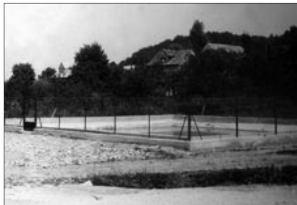
Zbiornik wodny przeciwpożarowy w Niedźwiedzy.
