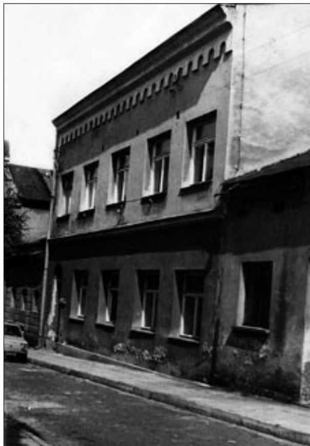
Siedziba Biblioteki Powiatowo-Miejskiej w Brzesku przy ulicy Puszkina.
