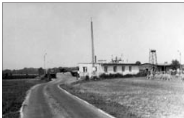
Powiatowy Zarząd Dróg Lokalnych – podległy Prezydium PRN w Brzesku. Wytwórnia mas bitumicznych PZDL w Woli Dębińskiej. Masę bitumiczną wytwarza się na potrzeby dróg lokalnych w powiecie.
