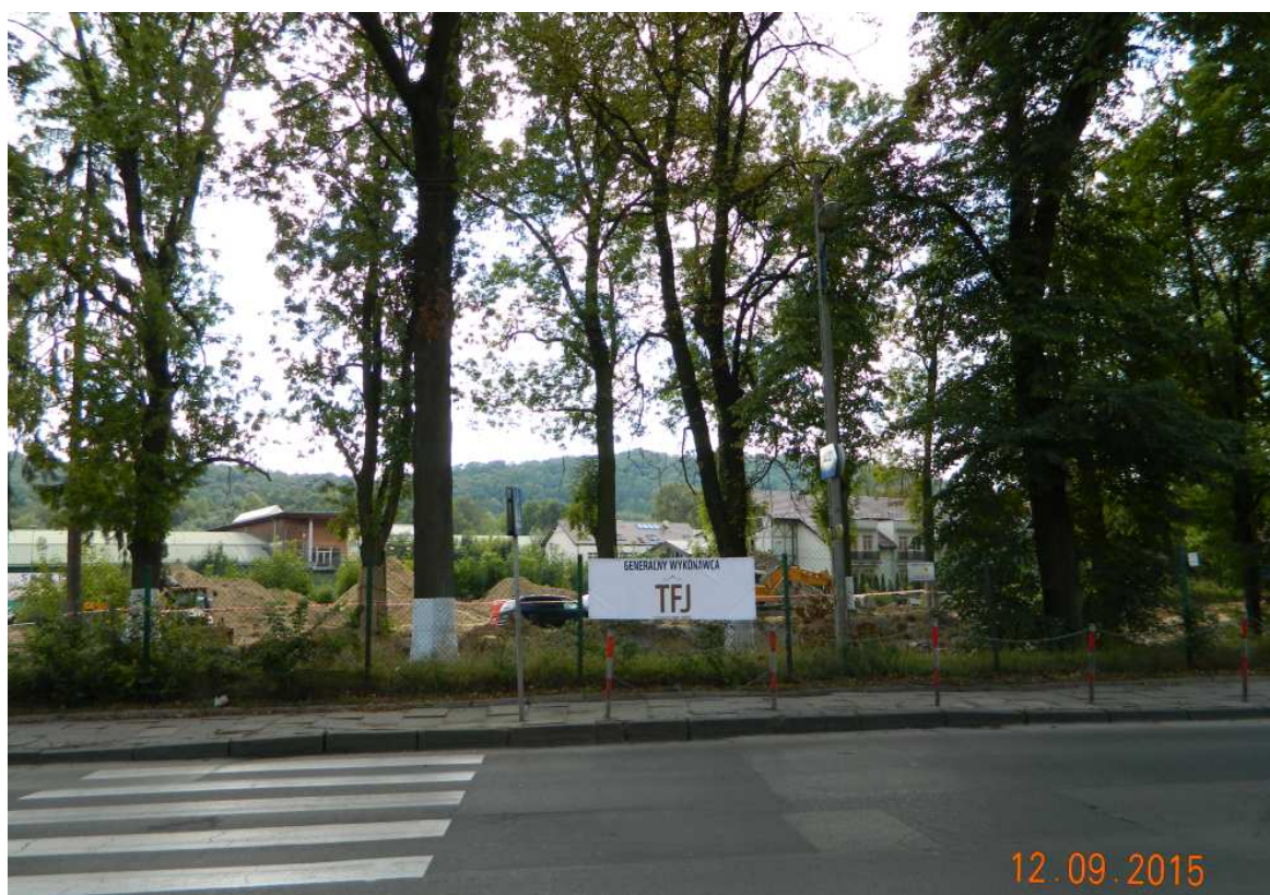
Fot. nr 125. Plac budowy ponad ulicą Królowej Jadwigi. To posesja pod nr 220.
