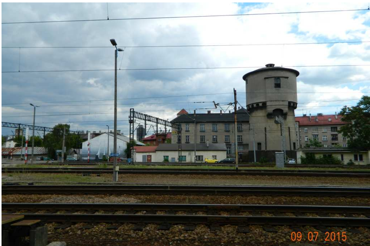
Fot. nr 27 (27-29). Kolejowa zabudowa i infrastruktura od strony ulicy Bosackiej.
