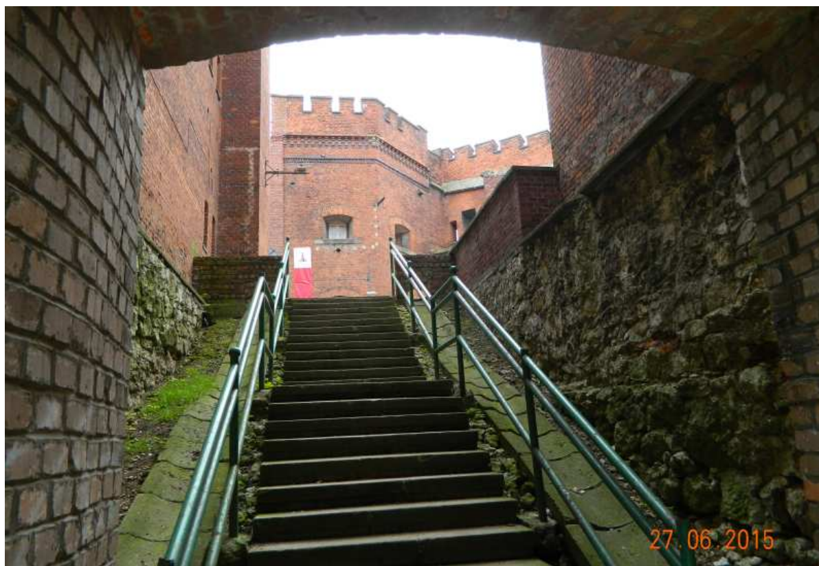
Fot. nr 92. Schody spod bastionu nr IV na dziedziniec wewnętrzny dawnych koszar.
