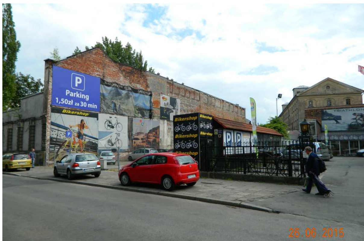
Fot. nr 59 (59-60). Widoki budynku fabrycznego dawniej „cygar fabryki”. Na pierwszym planie puste miejsce po niedawno zburzonej kamienicze spod nr 4.
