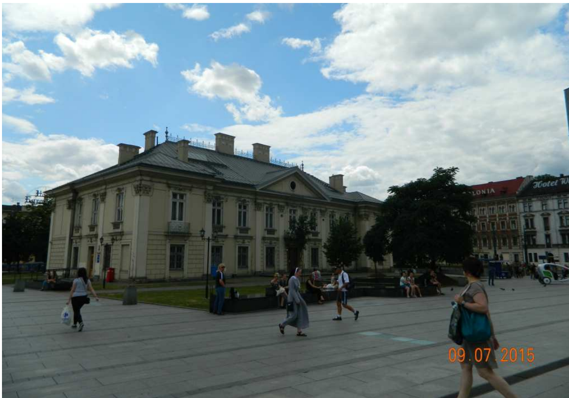
Fot. nr 23. Pałac Wołodkowiczów, który wygląda na zagubiony w nowym otoczeniu.
