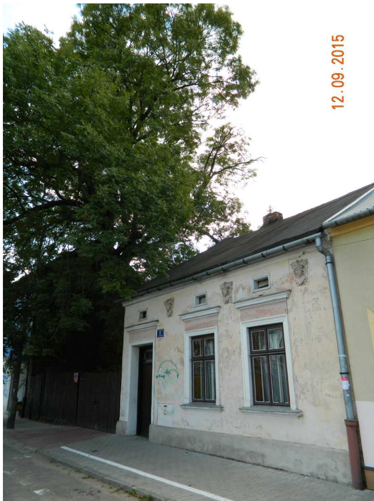
Fot. nr 160. Jeden z ostatnich reliktów podmiejskiej zabudowy Dębnik z ulicy Kilińskiego 13.
