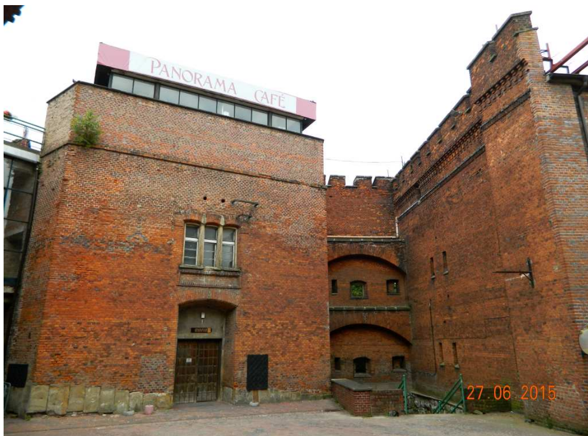
Fot. nr 95. Kawiarnia i punkt widokowy na dachu bastionu nr IV.
