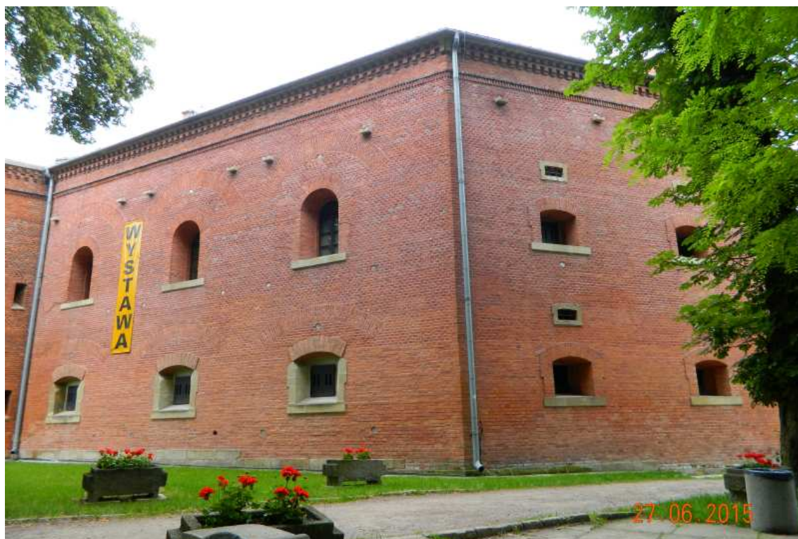
Fot. nr 85 (85-86). Bastion nr V fortu Kościuszko.
