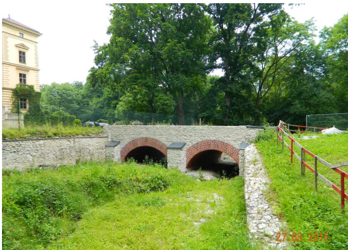
Fot. nr 131 (131-132). Niedawno zrekonstruowany mostek dojazdowy do willi Decjusza.
