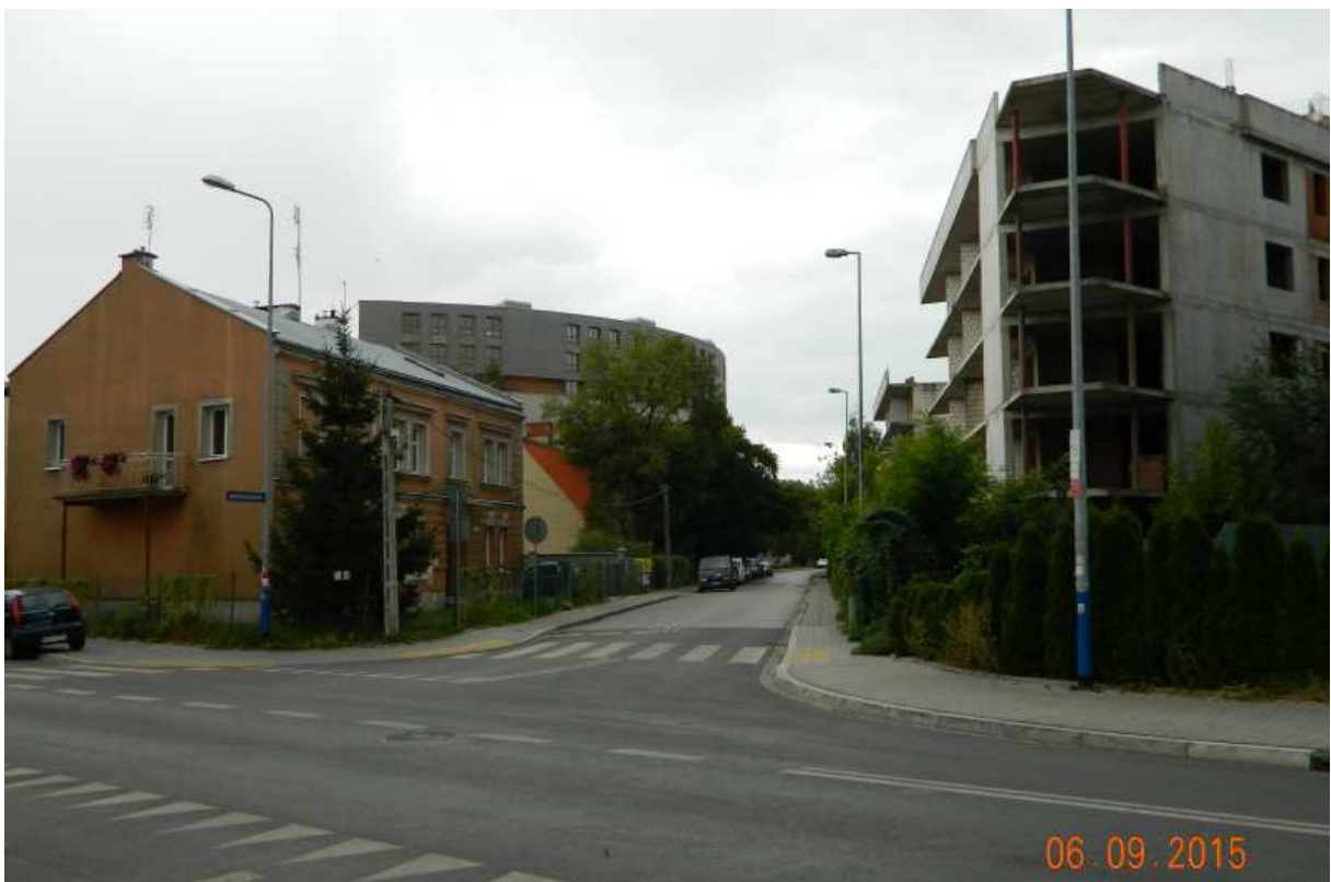
Fot. nr 164. Współczesny widok na początkowy fragment ulicy Twardowskiego, która praktycznie zatraciła już swój podmiejski wygląd. Po starej zabudowie pozostała już tylko kamieniczka pod nr 14.
