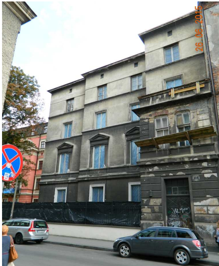
Fot. nr 72. Trwa remont kamienicy z ulicy Krupniczej 18.
