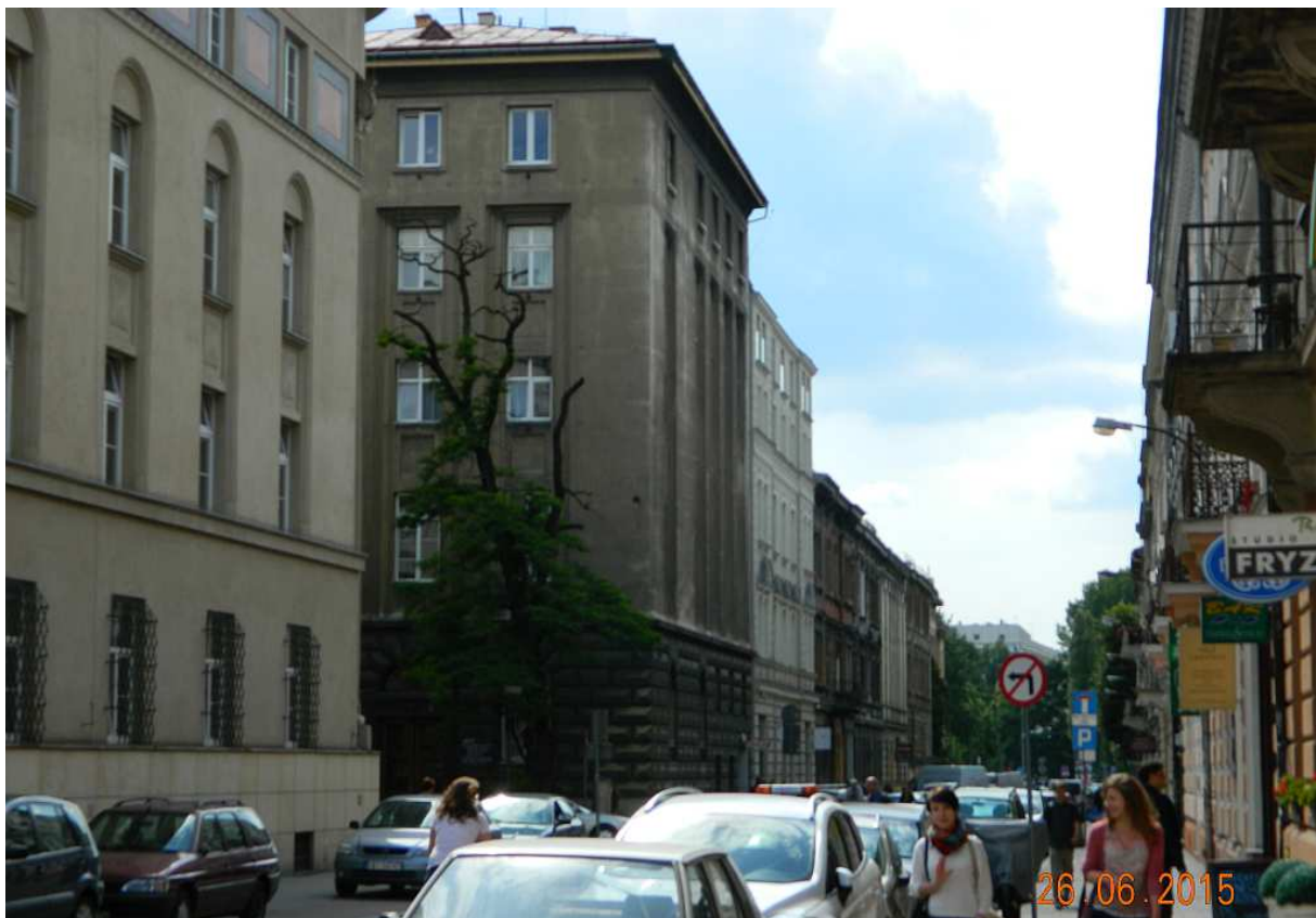
Fot. nr 63. Ulica Czysta. Kamienica pod nr 8 już po szpetnej dobudowie dwóch pięter.
