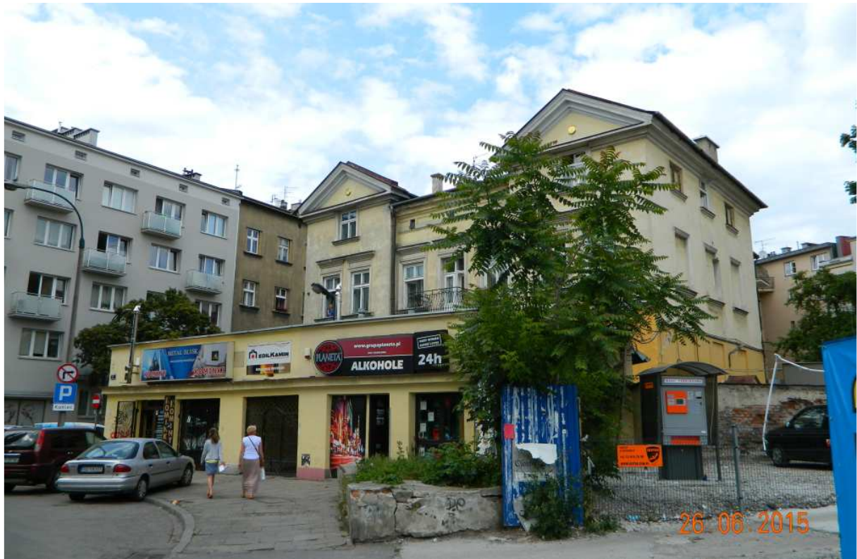
Fot. nr 52. Dawna willa z ulicy Czarnowiejskiej 1 i dobudówka handlowo-usługowa na jej przedpolu, która niebawem ma zostać rozebrana.
