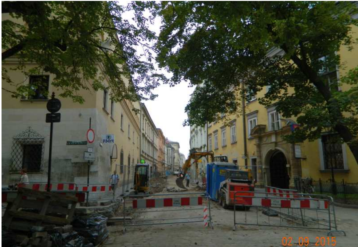
Fot. nr 10. Wymiana nawierzchni ulicy Wiślniej – widok z Plant.
