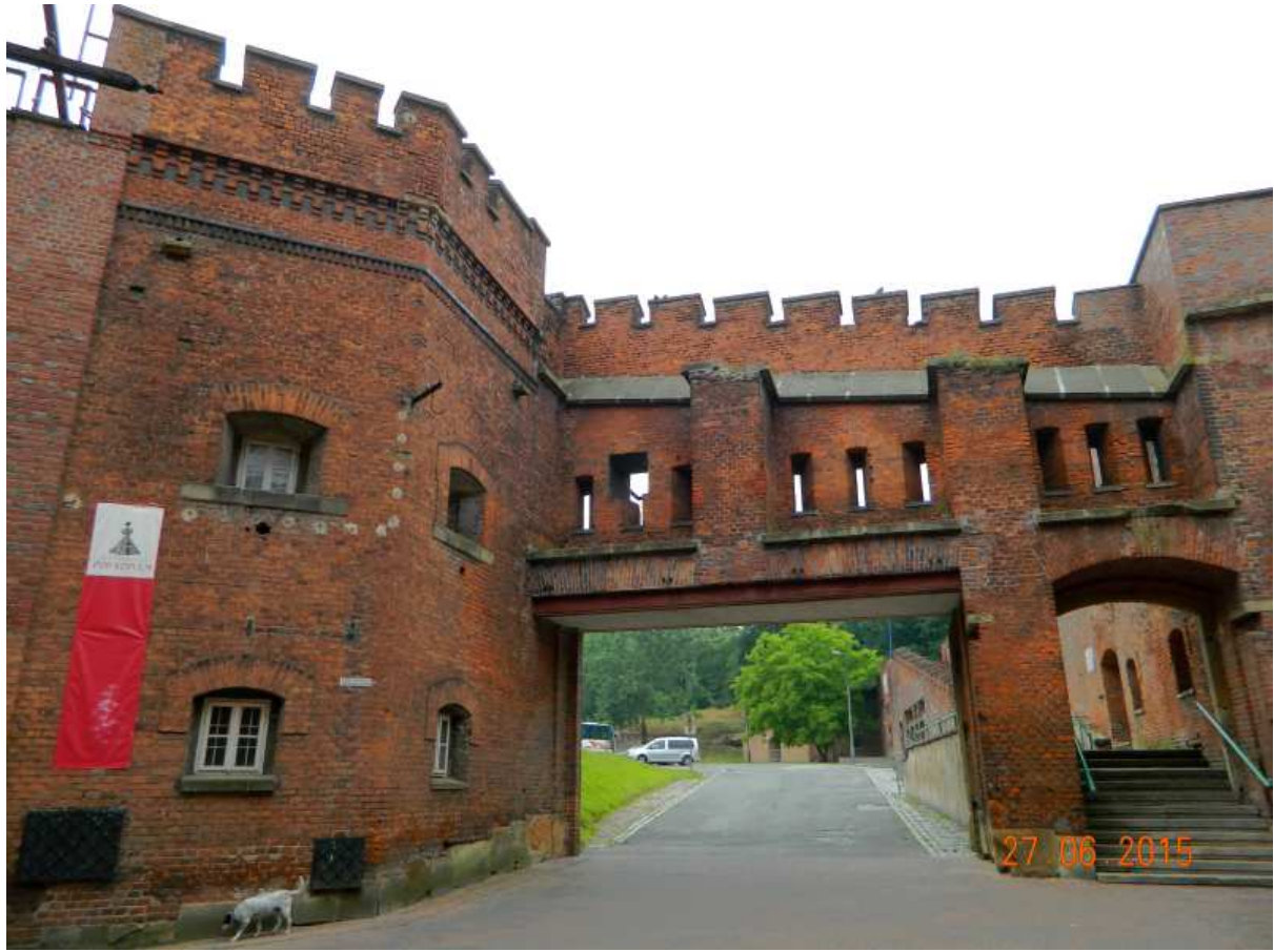
Fot. nr 96 (96-97). Zewnętrzna brama wjazdowa na dziedziniec wewnętrzny koszar.
