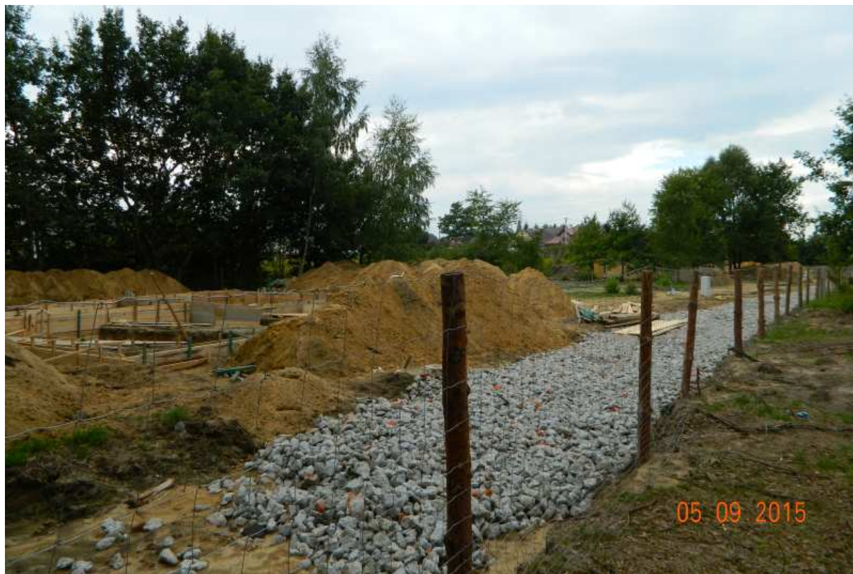
Fot. nr 296. Trwa zabudowa terenu pomiędzy ulicą Obronną, a rżackimi ugorami.
