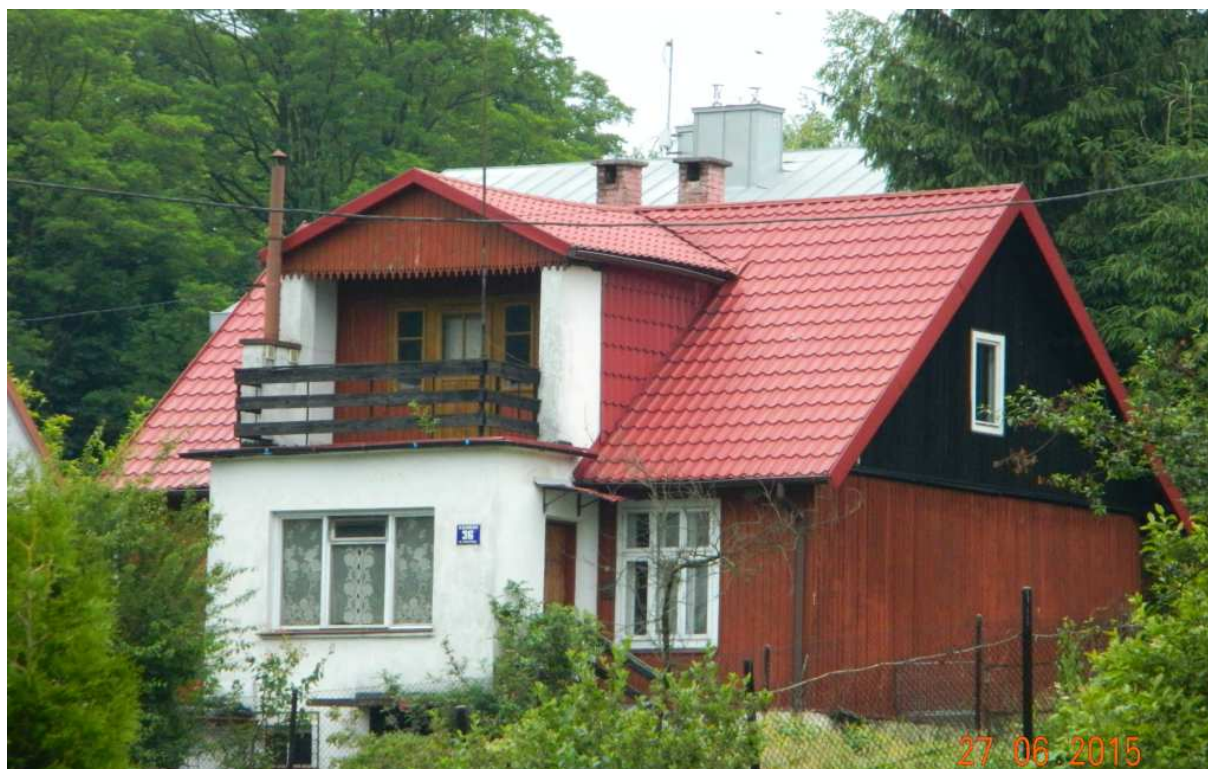
Fot. nr 130. Nieco przebudowany już podmiejski oryginał z sąsiedztwa willi Decjusza, zlokalizowany przy ulicy 28-Lipca 1943.
