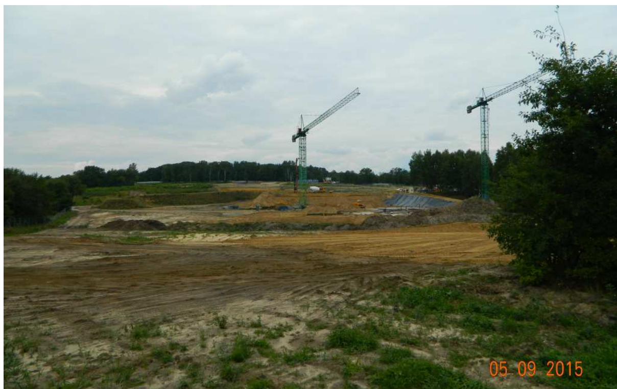
Fot. nr 287 (287-291). Po dwóch latach marazmu ruszyła wreszcie budowa centrum medycznego AM.
