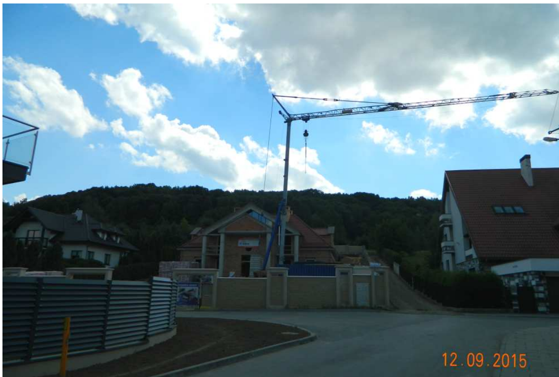
Fot. nr 121(121-122). Gęstnieje zabudowa na przedpolu Sikornika wzdłuż ulicy Lajkonika.
