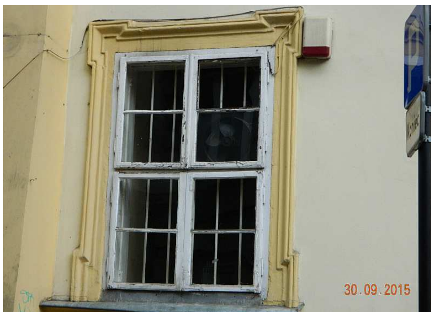
Fot. nr 4. Oryginalne, ośmiopolowe okno, które zachowało się na parterze kamienicy z naroża ulic: św. Tomasza 35 i św. Krzyża 15, charakterystyczne dla klasycystycznej zabudowy.
