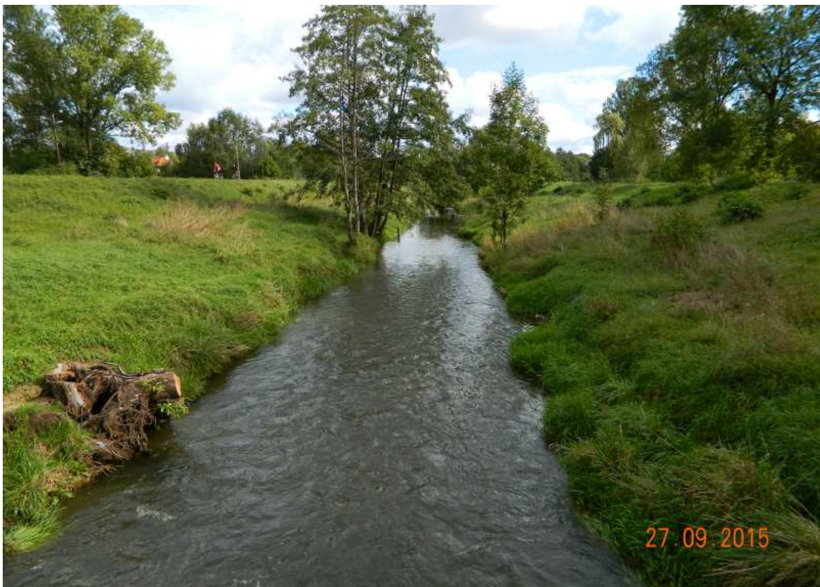
Fot. nr 95. Sącząca się spokojnie Rudawa – widok z wysokości dawnej drewnianej „ławy”, czyli „czerwonego mostku”.
