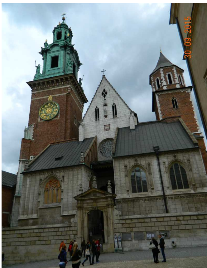
Fot. nr 69. Widok fasady z wieżami: Zegarową (z lewej) i Srebrnych Dzwonów.
