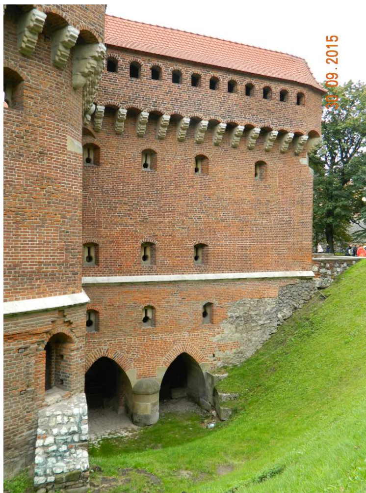
Fot. nr 12. Pierwotny poziom Barbakanu i wspomnienie otaczającej go fosy.
