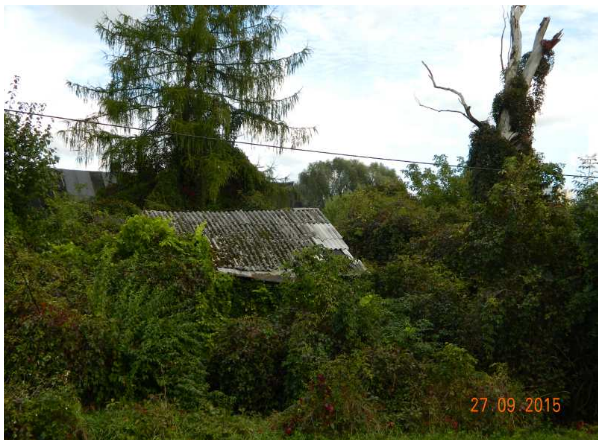
Fot. nr 93. Schowana w zaroślach dawna stodoła przy dawnej ogrodniczej osadzie na zakręcie ulicy Mydlnickiej (nr: 73-77), w miejscu dawnego jazu – widok z wału Rudawy.
