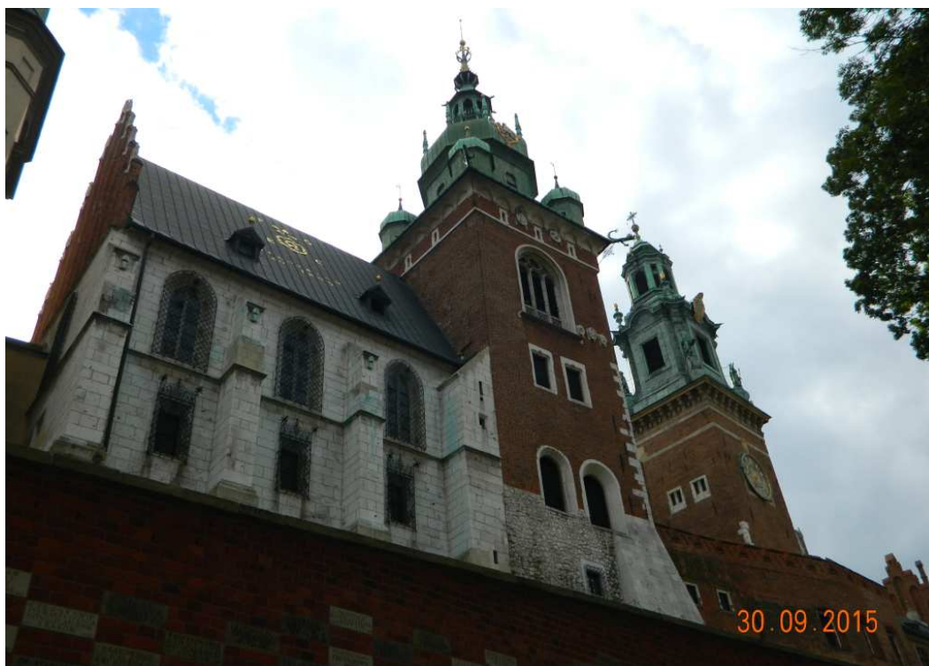
Fot. nr 43. Katedra na Wawelu, jej północny fragment od strony ulicy Podzamcze.
