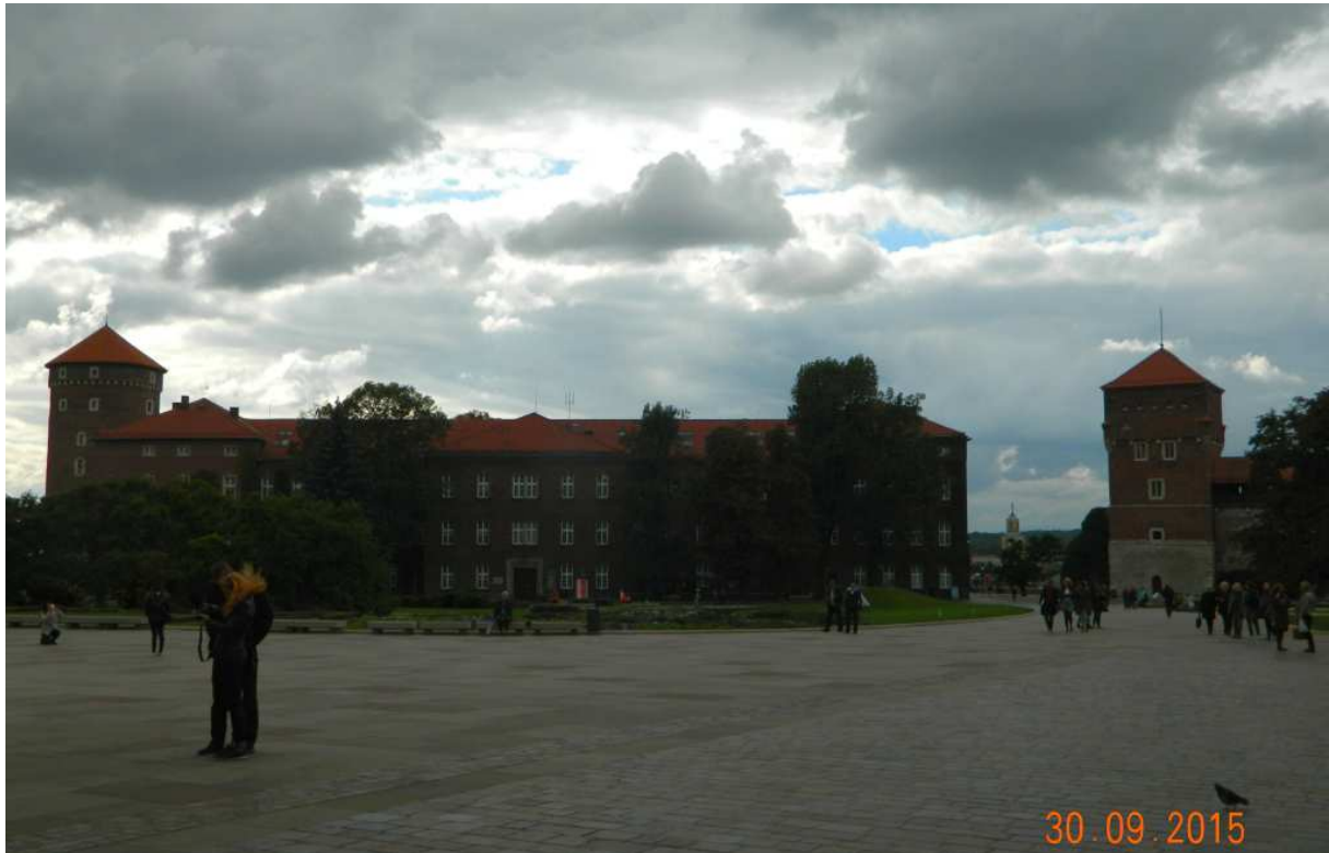
Fot. nr 56. Baszty: Sandomierska (z lewej) i Złódziejska, a pomiędzy nimi budynek pouastryckiego szpitala.
