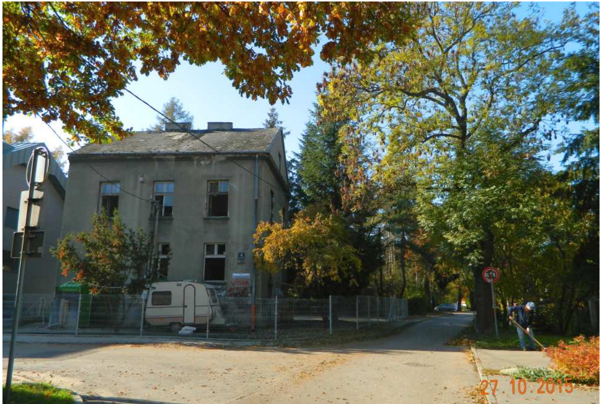
Fot. nr 142. Przedwojenna willa spod nr 20 na styku z ulicą Tondosa (nr 10).
