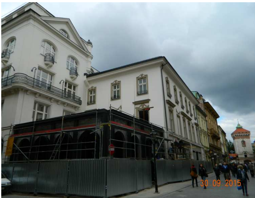
Fot. nr 17. Trwa budowa nowego pawilonu w narożu ulic: Floriańskiej i św. Marka.
