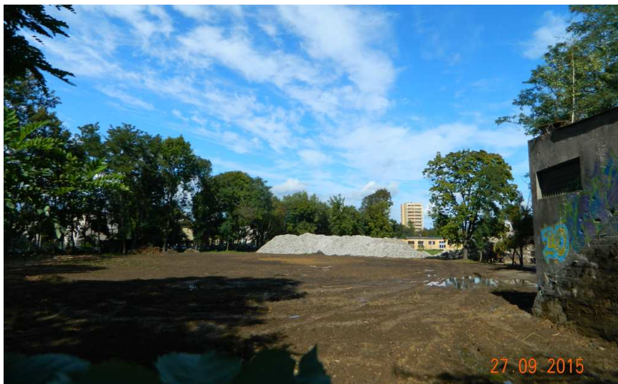
Fot. nr 89. Basen głęboki (460/220 cm) to już wspomnienie. Właśnie został zrównany z ziemią.
