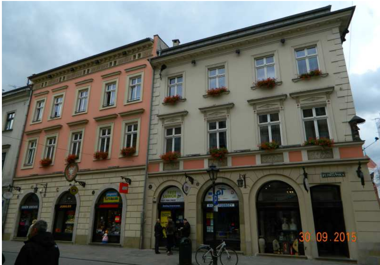
Fot. nr 16. Odnowione budynki w końcowym odcinku ulicy Floriańskiej 42 i 44.
