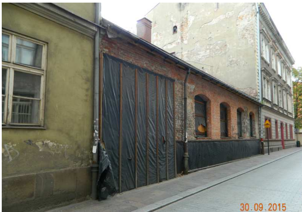
Fot. nr 5. Opornie postępuje remont dawnej kuźni Zieleniewskich z ulicy św. Marka 31. Tu widok od strony ulicy św. Krzyża (nr 12).
