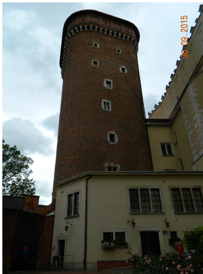
Fot. nr 66. Baszta Senatorska od strony północnej.
