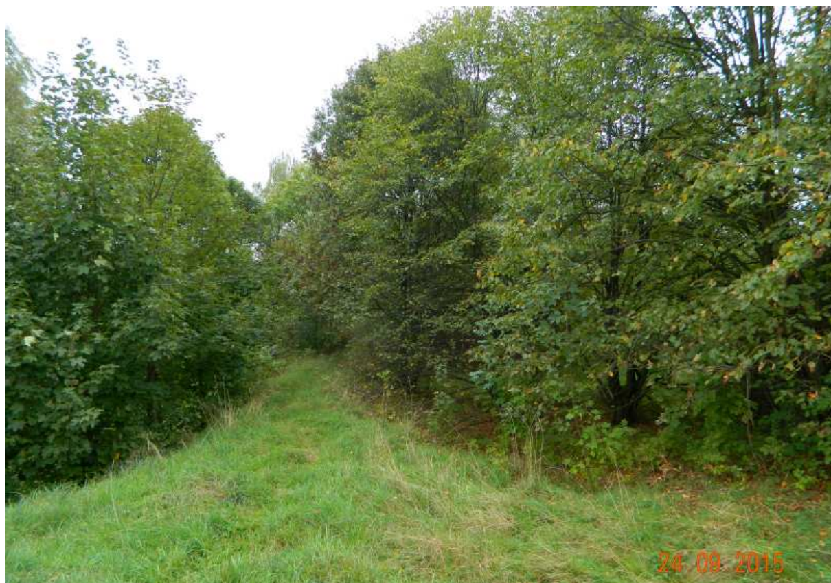
Fot. nr 44 (44-45). Szybko zarastające wnętrze szanca FS 29.
