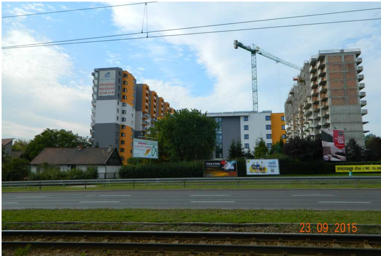
Fot. nr 128 (128-130). Nowy gigant mieszkalny pomiędzy ulicami: Wielicką i Polonijną, zwany dosadnie jednym z „filarów” nowej „bramy wielickiej”. Na przedpolu chatka pod nr 249.
