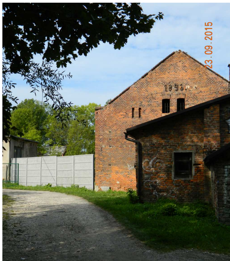
Fot. nr 139. Fragment dawnego folwarku Na Wrzosach; na szczycie data budowy: 1896.
