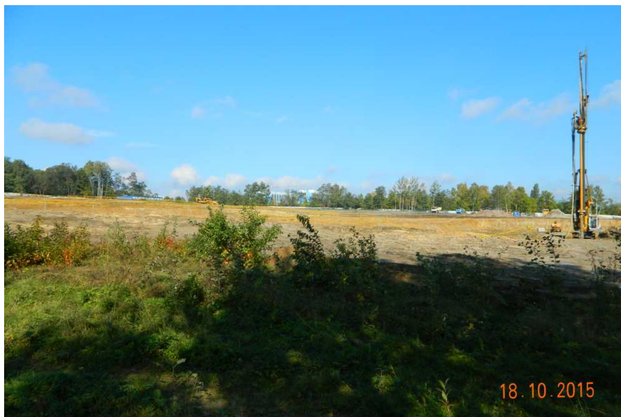
Fot. nr 187 (187-192). Budowa nowego centrum szpitalnego AM na rżączkich ugorach rozpoczęła się na dobre. Fot. nr: 187-189 – ujęcia od strony „ulicy” Słona Woda.
