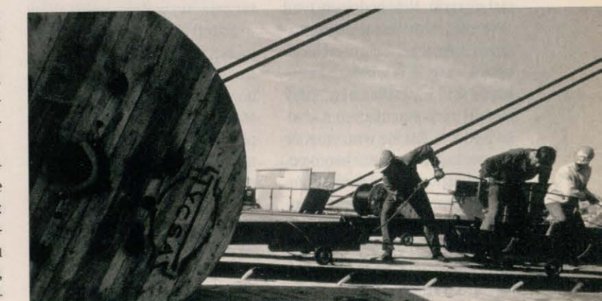
Francuscy robotnicy z firmy Freyssinet kładą kable (72 przewody w każdym).
