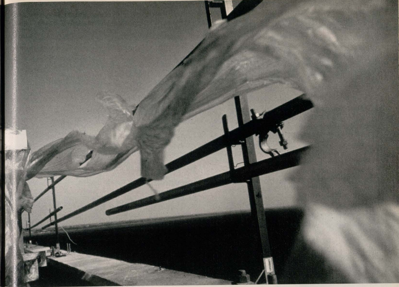
Dolna część mostu, którą będzie biegła linia kolejowa.
