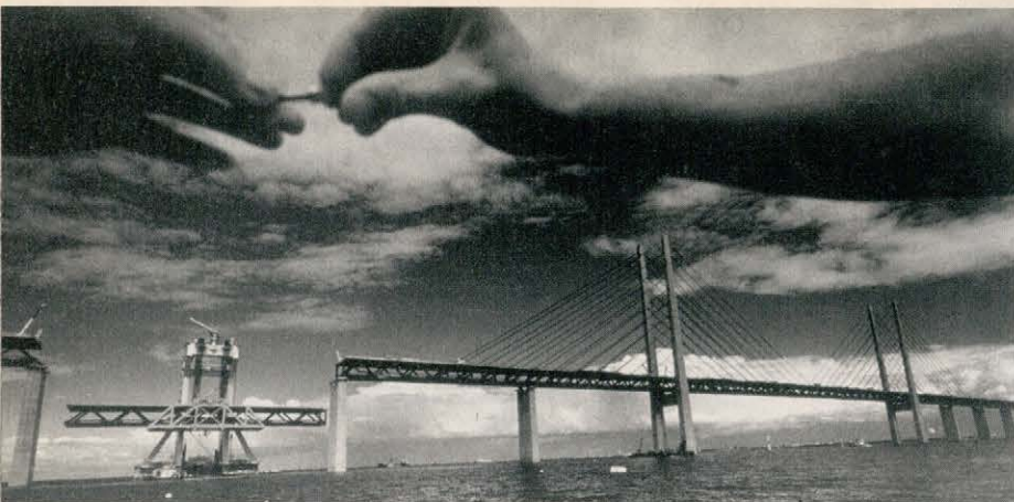
„Ręka Boga pomaga w usadowieniu ostatniego elementu mostu”.
