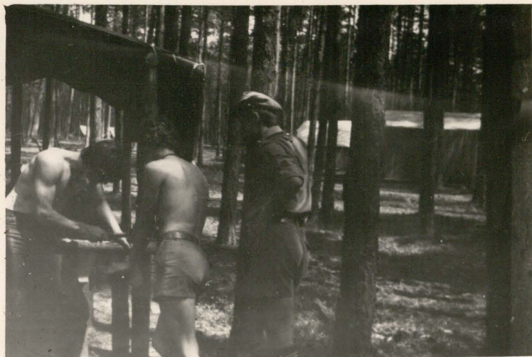
BUDOWA JADALNI...↑ ... I GOTOWA JADALNIA↓
