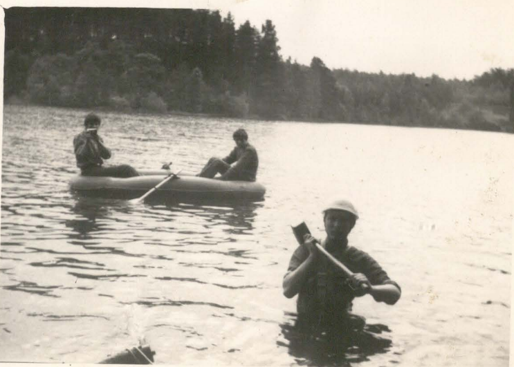
W WODZIE, ALE Z PŁYWA, (BUDOWA POMOSTU)↓
