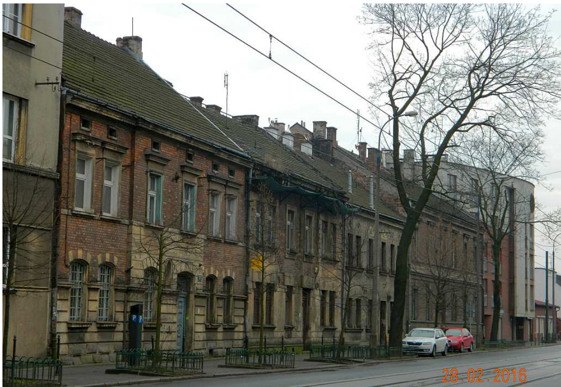
Fot. nr 120 (120-127). Zabytkowa już, bo pochodząca z około 1910 roku zabudowa ulicy Kościuszki o numerach: 60-66. Aktualnie jest to już pustostan i fragment ten, o typowo podmiejskim charakterze, ma zostać rychło wyburzony. Co tu powstanie, nietrudno się domyślić, wszak w okolicy wyższych budynków nie brakuje.
