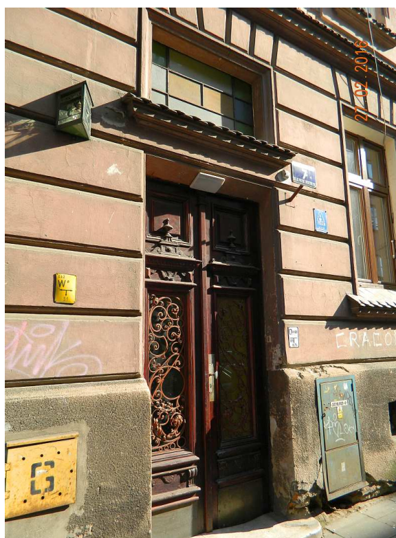
Fot. nr 44. Oryginalne drzwi wejściowe, a nad nimi mozaikowe okno.
