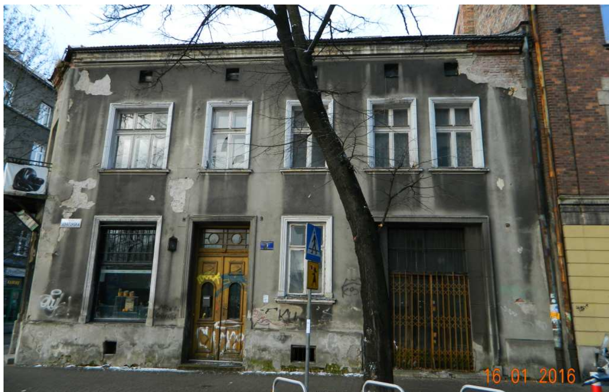
Fot. nr 25 (25-34). Kamieniczka z naroża ulic: Senatorskiej (nr 5) i Filarecka (nr 1), pochodząca z I dekady XX wieku, związana z wytwórnią wód gazowanych Jaworskiego.
