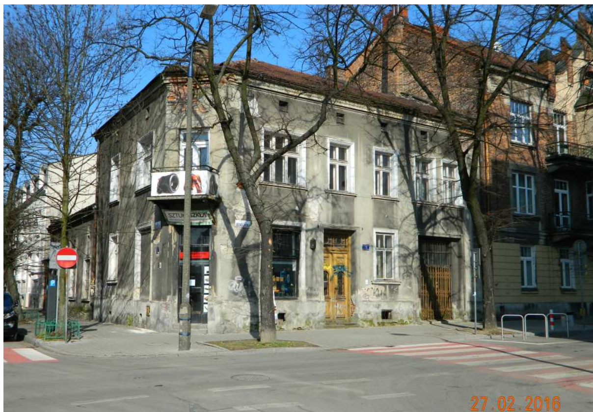
Fot. nr 31 (31-33). Widok z Placu Na Stawach. Jak słyszę ten narożny budynek ma wkrótce zostać zburzony.
