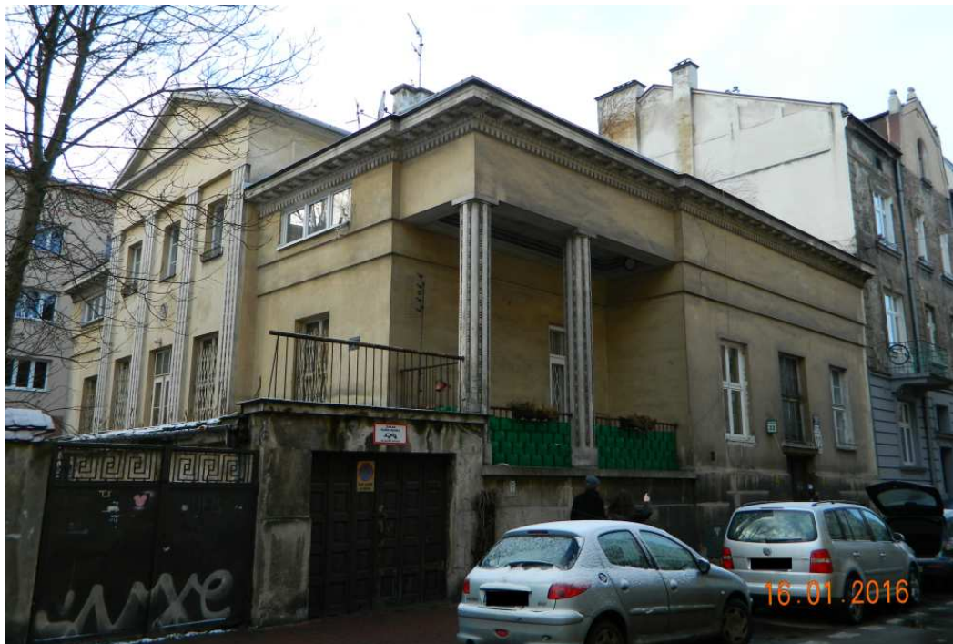
Fot. nr 46 (46-48). Willa z naroża ulic: Kraszewskiego 22 i Senatorskiej 9, wybudowana w roku 1923. Jej projektantem był Ludwik Wojtyczko.
