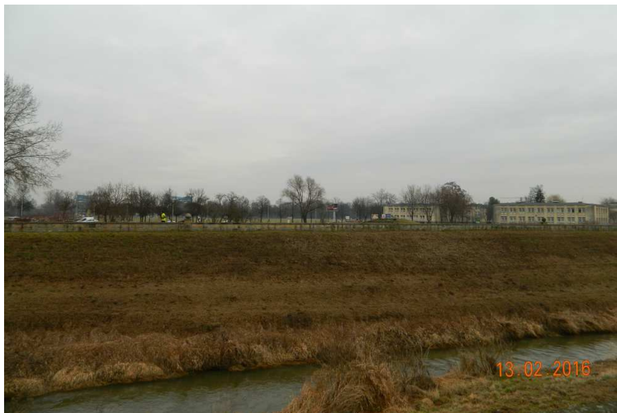
Fot. nr 139. Plac budowy hali w ujęciu zza Rudawy, znad ulicy Emaus.
