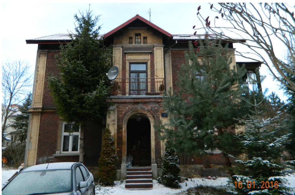
Fot. nr 60 (60-68). Eklektyczna willa z ulicy Salvatorskiej 31, wybudowana w IV ćwierci XIX wieku i jej detale oraz otoczenie. Choć cała ta przestrzeń zasługuje na uwagę, obiekt ten nie jest wpisany do ewidencji zabytków.
