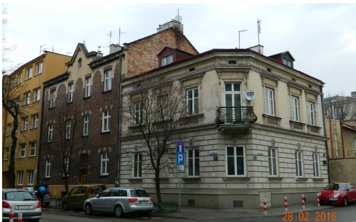
Fot. nr 42. Kamieniczka z naroża ulic: Filareckiej 19 i Salvatorskiej, wybudowana w latach 1936/37 wg projektu Stanisława Mehla.
