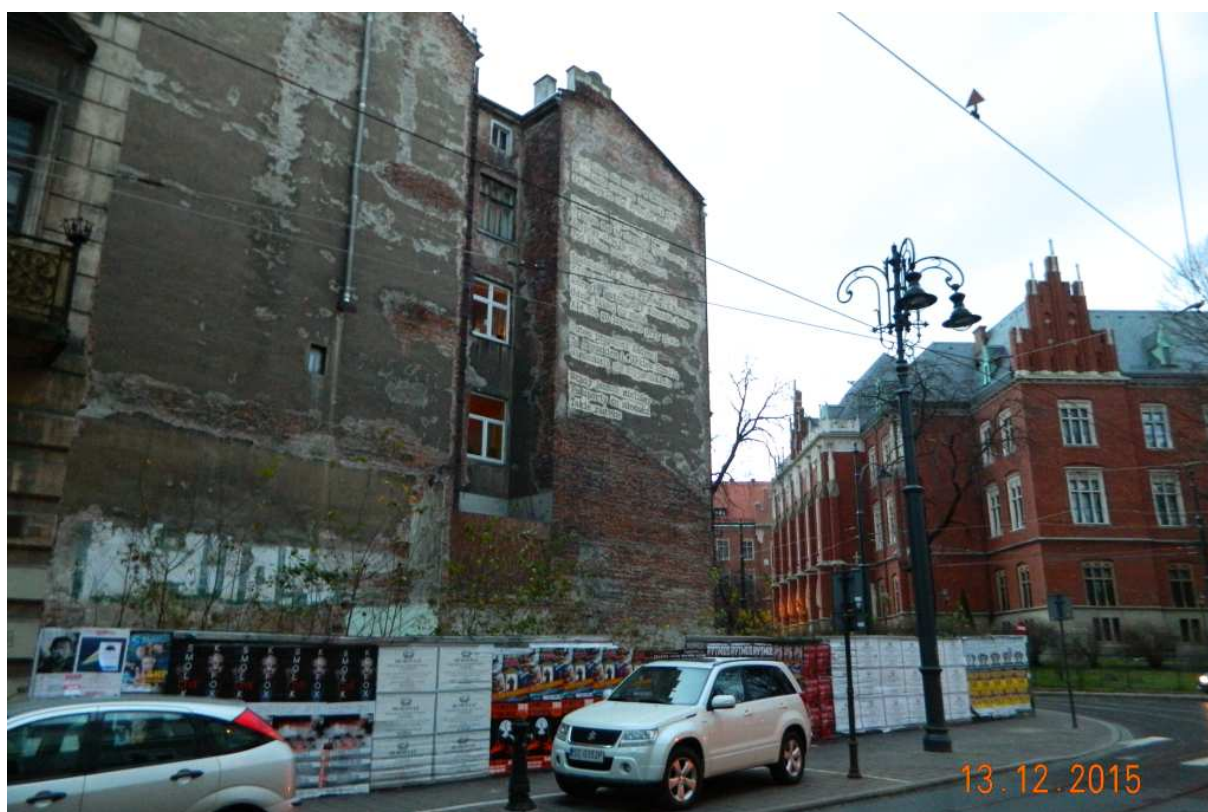
Fot. nr 8. Wspomnienie Barcelony, galicyjskiego duchem budynku z naroża ulic: Straszewskiego i Piłsudskiego, gdzie mieścił się słynny szynk, potem bar piwny, a na końcu schludna jadłodajnia. Ma tu powstać wielkie gmaszysko, ale póki co rośnie tu las.
