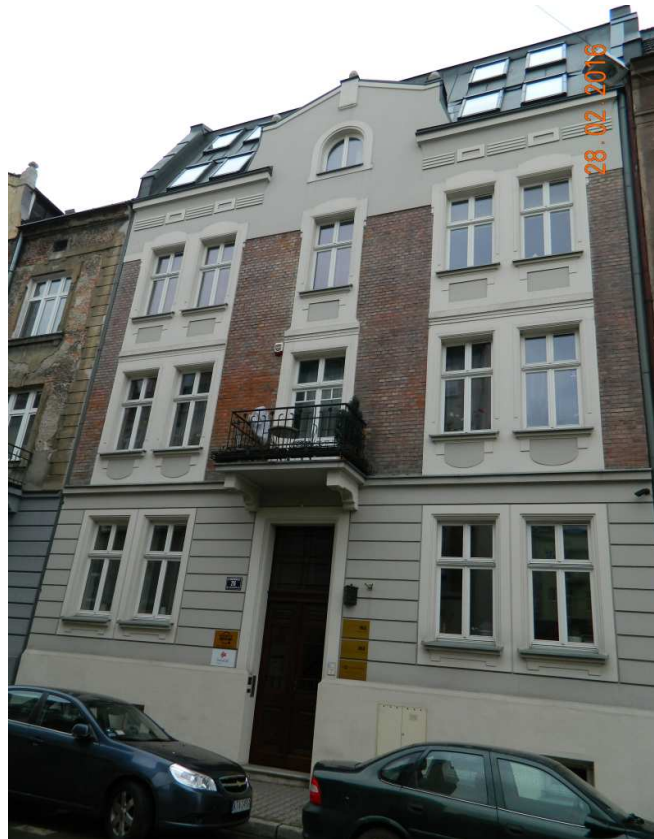
Fot. nr 49 (49-50). Udanie odnowiona kamienica z ulicy Kraszewskiego 26, która powstała w roku 1912 wg projektu Józefa (?) Wilczyńskiego.
