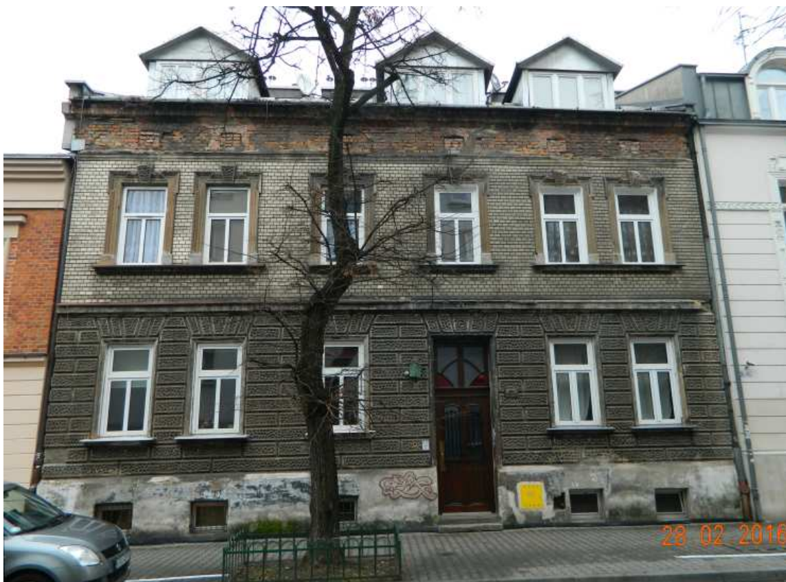
Fot. nr 37 (37-38). Ze zgrozą patrzy się do góry na dom z ulicy Filareckiej 5. (ok. 1900)
