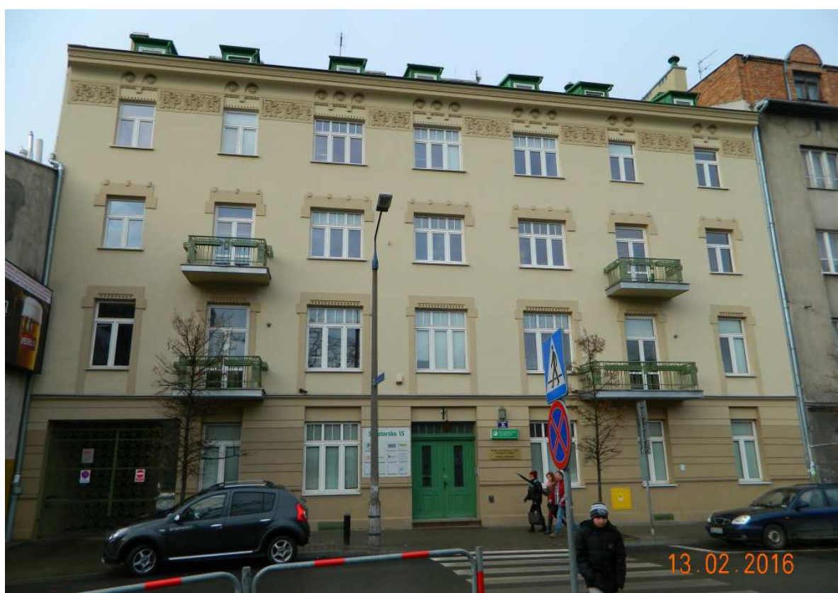
Fot. nr 76. Modernistyczna kamienica z ulicy Senatorskiej 15, wybudowana w roku 1912 wg projektu Józefa Wilczyńskiego i Antoniego Kramarskiego. Pierwotnie mieściło się w niej Biuro Urządzania Lasu i Geodezji Leśnej.
