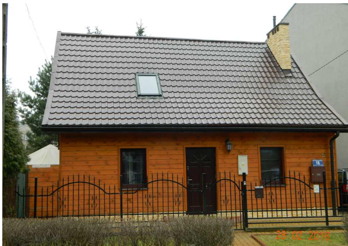
Fot. nr 134. Dawny dom Malików z ulicy Kasztelańskiej 16, przykład niszczącej zabytkową fasadę przebudowy.
