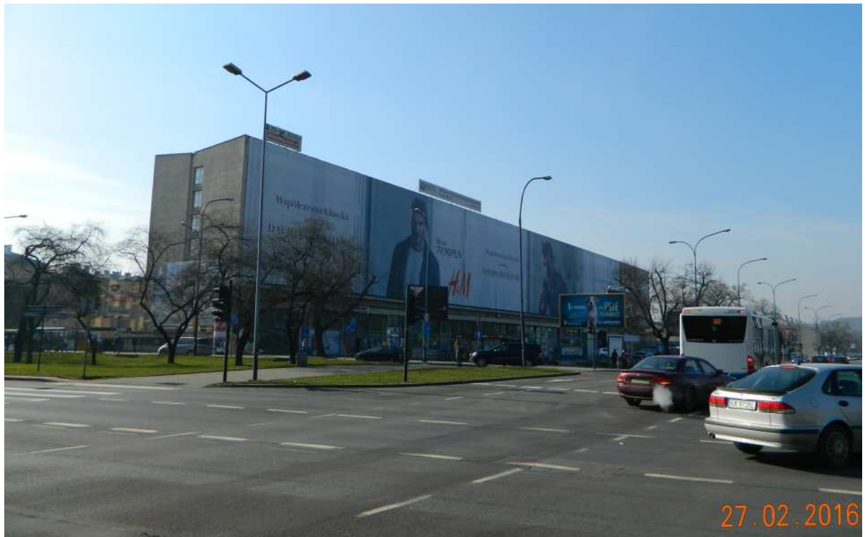
Fot. nr 17 (17-18). Powstał pół wieku temu i był synonimem zachodniego luksusu, a dziś jest spór o przyszłość tego budynku i póki co jest banerem reklamowym. Jaki los czeka dawny Hotel Cracovia?
