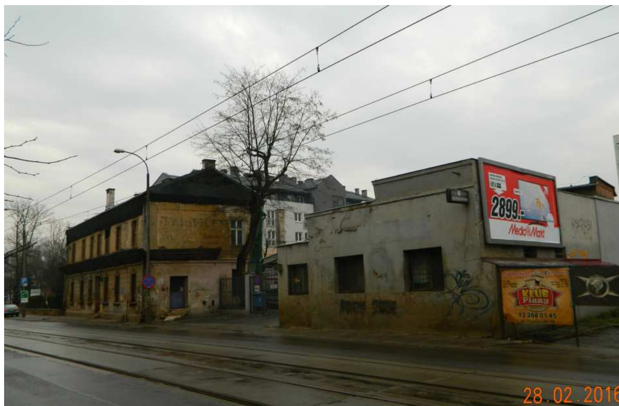
Fot. nr 110 (110-116). Z ulicy Kościuszki z pewnością znikną już niebawem dawne zabudowania przedwojennych Garaży Meta (w głębi posesji pod nr 49), które zostały wybudowane w roku 1928, jak i budynek spod nr 51, przylegający do garaży od strony ulicy, który jest starszy, zapewne z okolicy przełomu I i II dekady XX wieku. W czasach PRL swoją siedzibę miała tu WKTS. Trudna do rozszyfrowania jest reklama na jego ścianie bocznej, na której nakładają się dwie warstwy.
