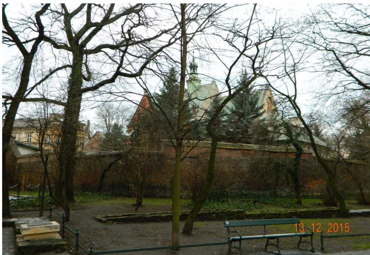
Fot. nr 15. Zespół klasztorny Reformatów w ujęciu od strony Plant.
