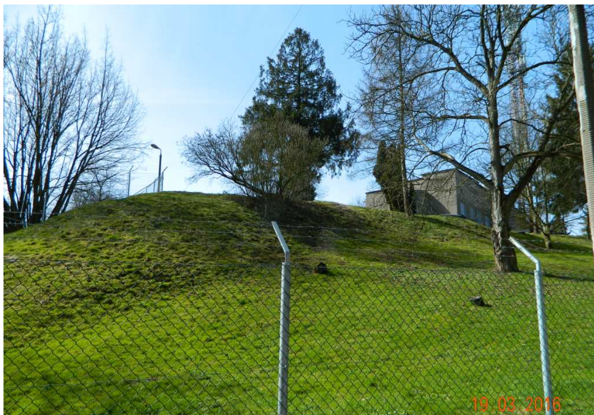
Fot. nr 128 (128-129). Budynki radiostacji krakowskiej w miejscu fortu N-1 Zwierzyniec, który również stanowił składnik Bramy Bielańskiej. Pozostały po nim: wał i fosa.
