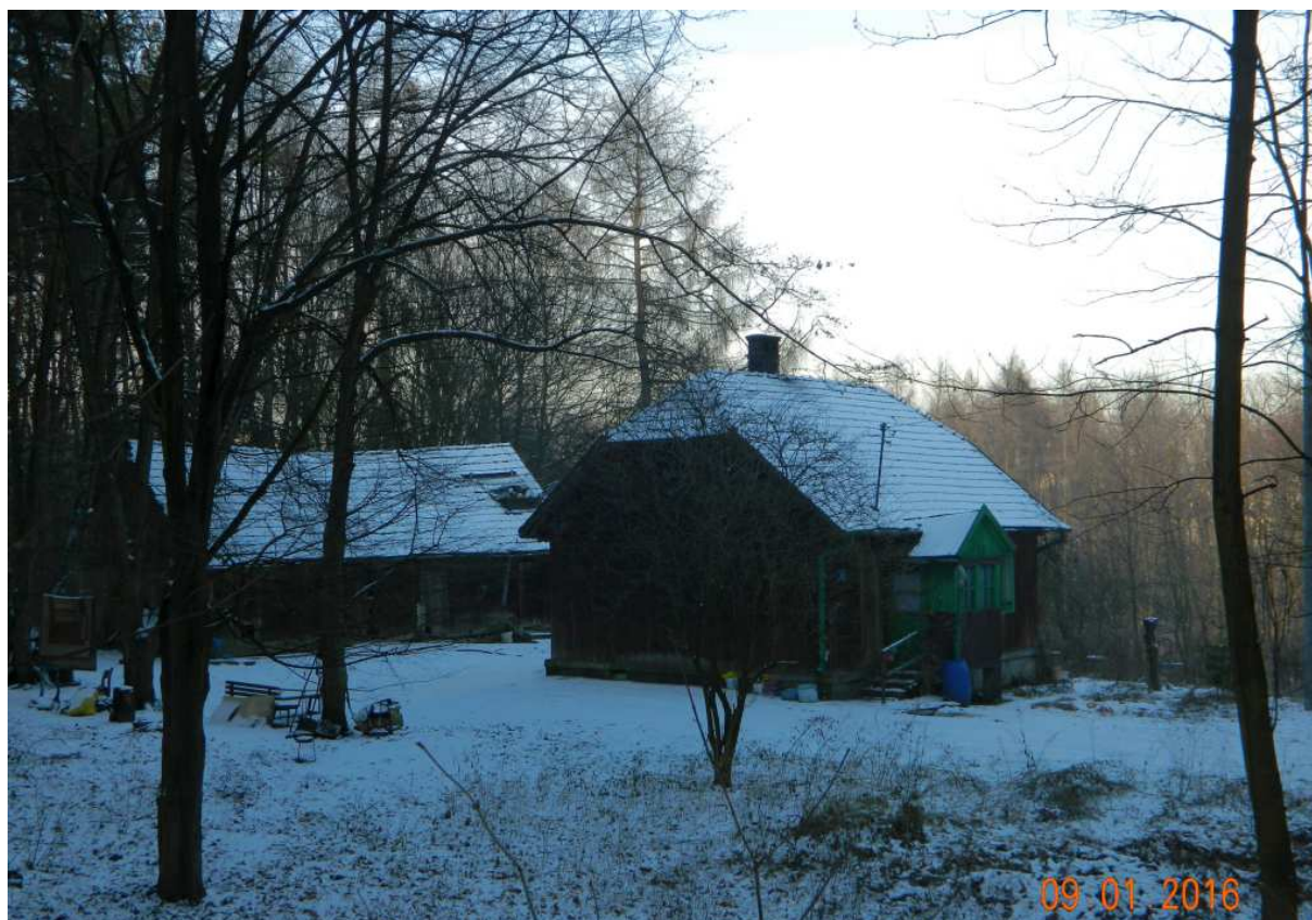
Fot. nr 252 (252-253). Przedwojenna leśniczówka przy ulicy Zielnej 105.
