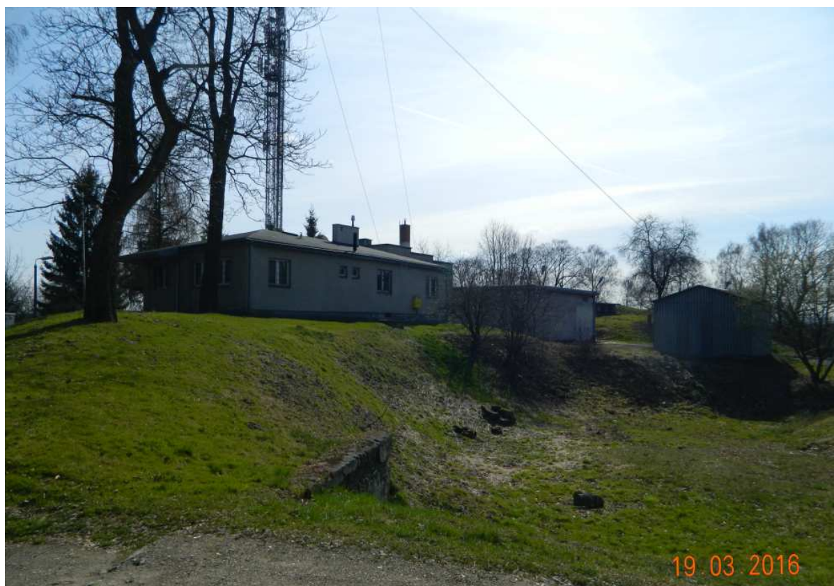
Fot. nr 129. Widok od strony bramy wjazdowej.
