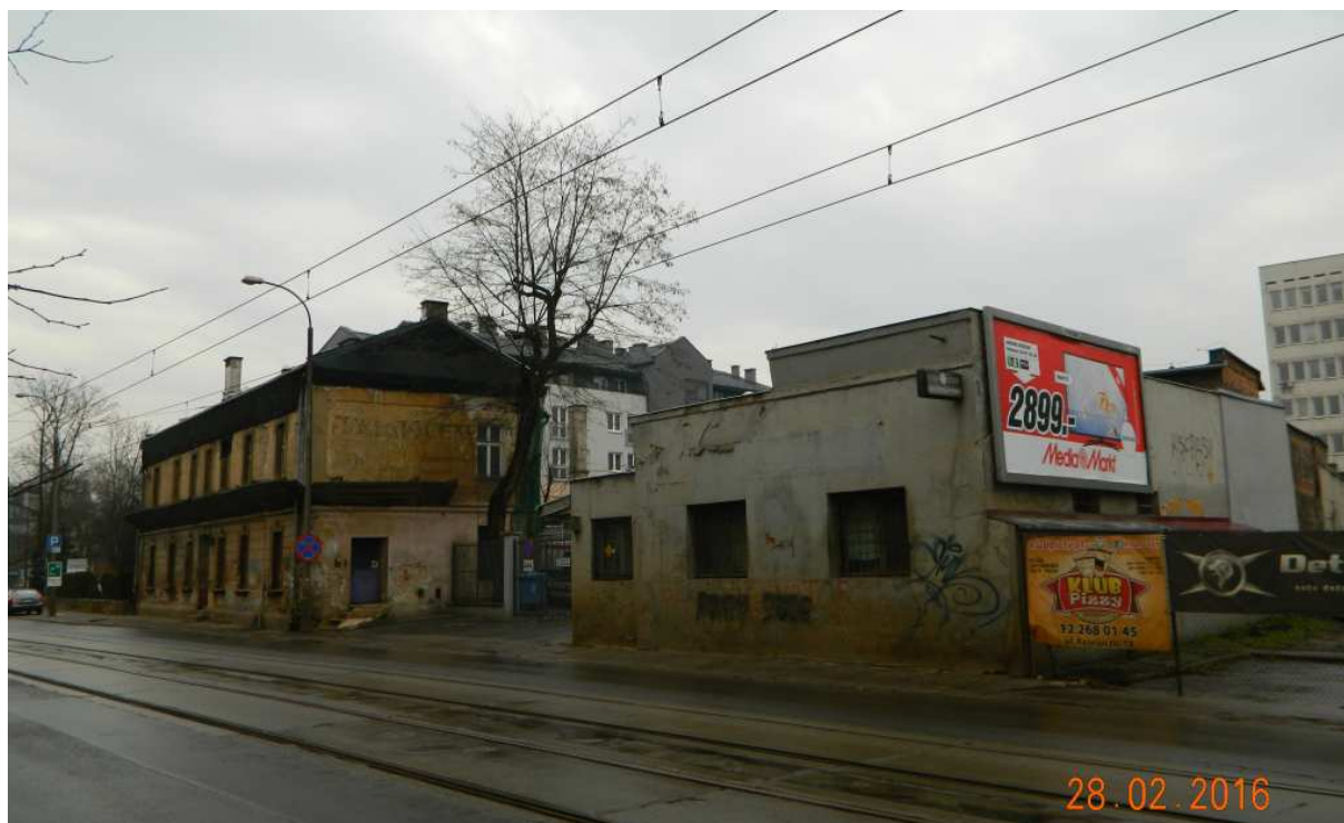
Fot. nr 95. Dawne Garaże Meta z ulicy Kościuszki 49 i przylegający do nich stuletni budynek pod nr 51. Po tych niskich budynkach pewnie też niedługo nie będzie już śladu, a młode pokolenie nie będzie miało pojęcia jak kiedyś wyglądało podmiejskie Półwie.
