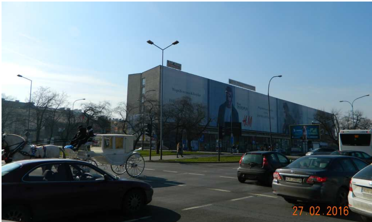
Fot. nr 88 (88-90). Dawny Hotel Cracovia w swym wcielenie jako baner reklamowy – widoki z wylotu ulicy Piłsudskiego.
