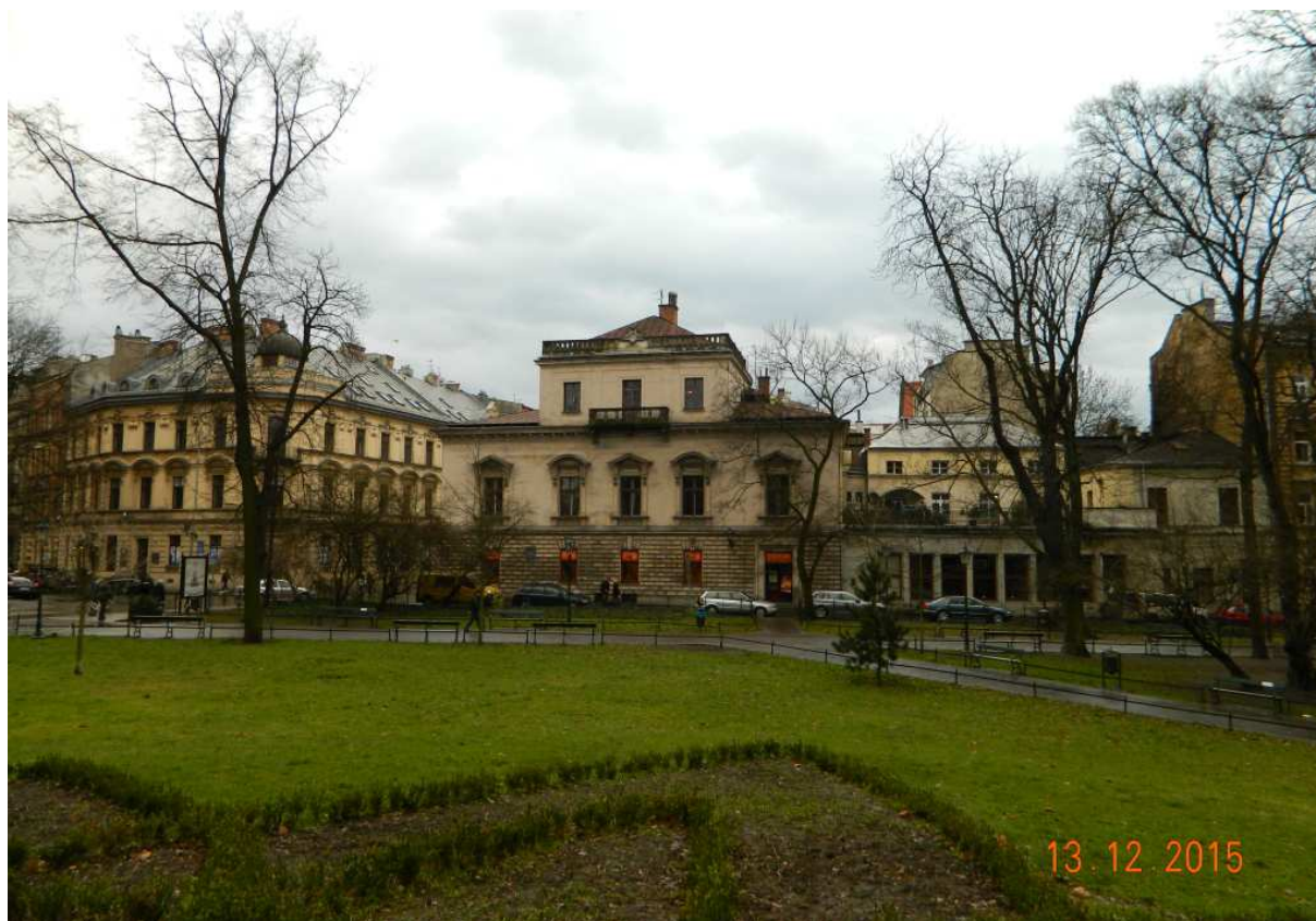
Fot. nr 14. Zabudowa wzdłuż ulicy Pijarskiej przy wylocie ulicy Sławkowskiej – widok z Plant. Można tylko wspominać dawną Kawiarnię Literacką (lokal z prawej).
