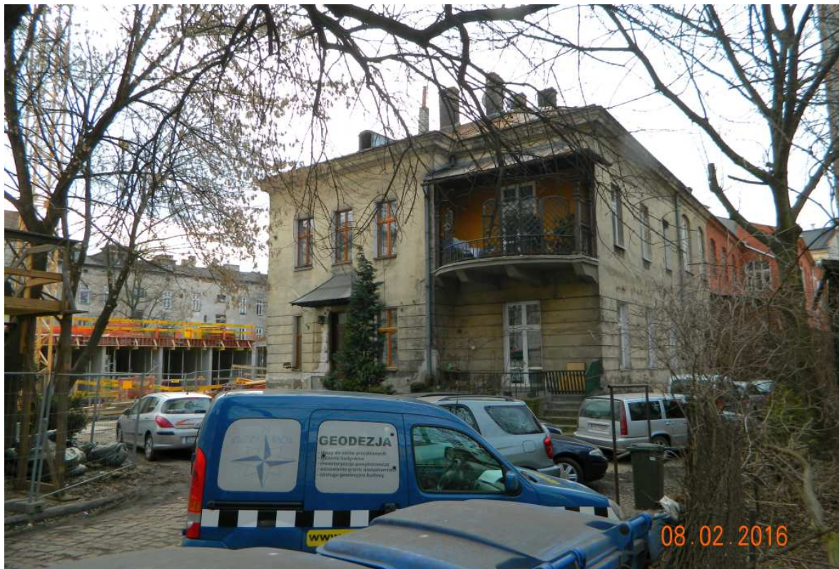
Fot. nr 66. Trwa zabudowa działki (pod nr 91) w sąsiedztwie dawnej willi Zofii Stryjeńskiej przy ulicy Starowiślniej 89.
