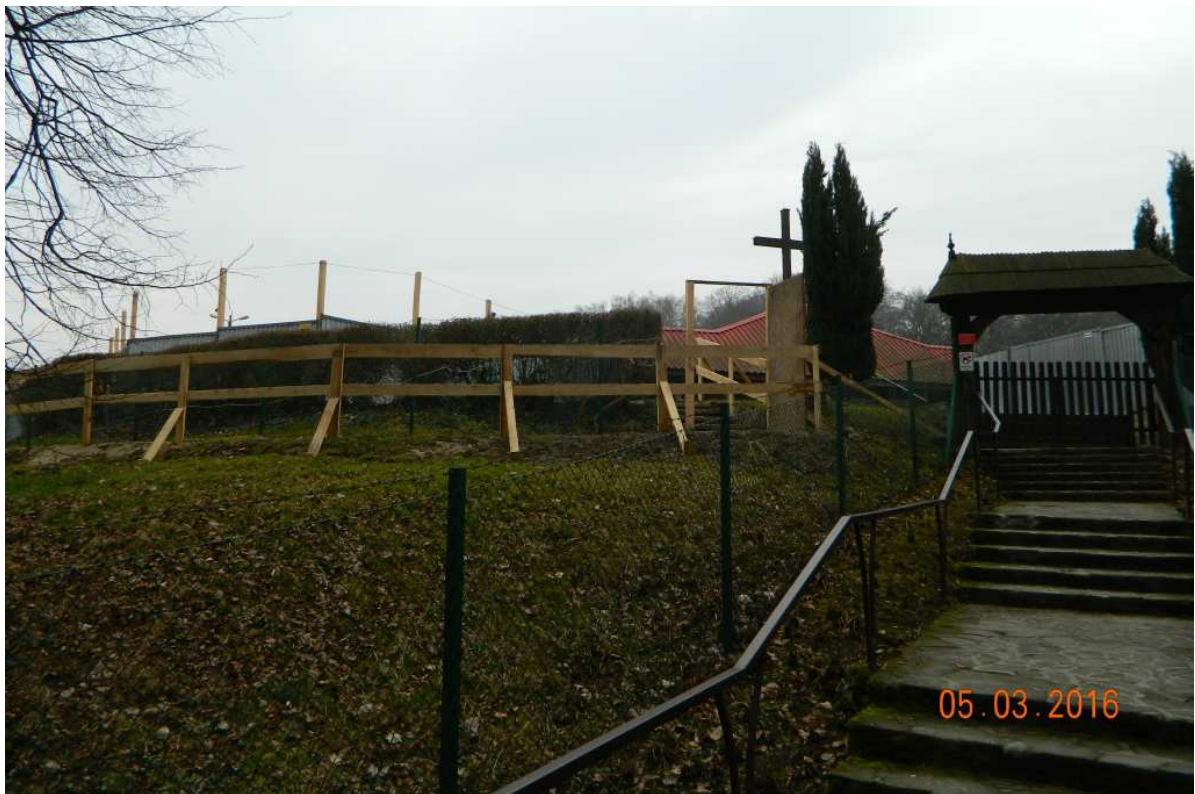
Fot. nr 159 (159-160). Plac budowy kościoła – widoki od strony Alei Panieńskich Skał.
