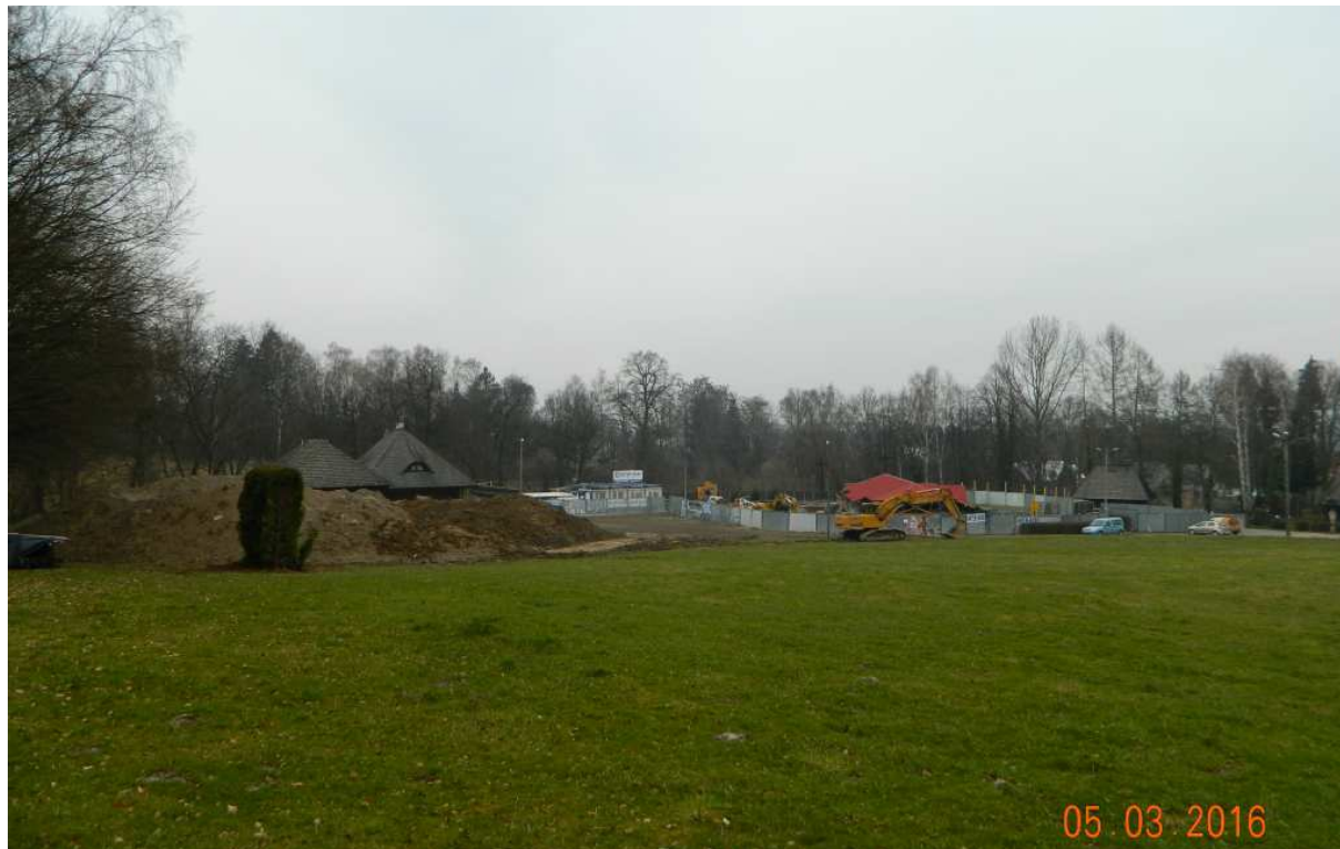
Fot. nr 161 (161-164). Widoki na plac budowy od strony ulicy Cisowej
