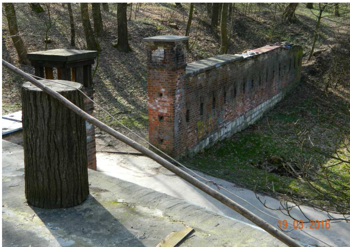
Fot. nr 144. Filary bramy i mur strzelniczy. Widok z dachu ostrogu.
