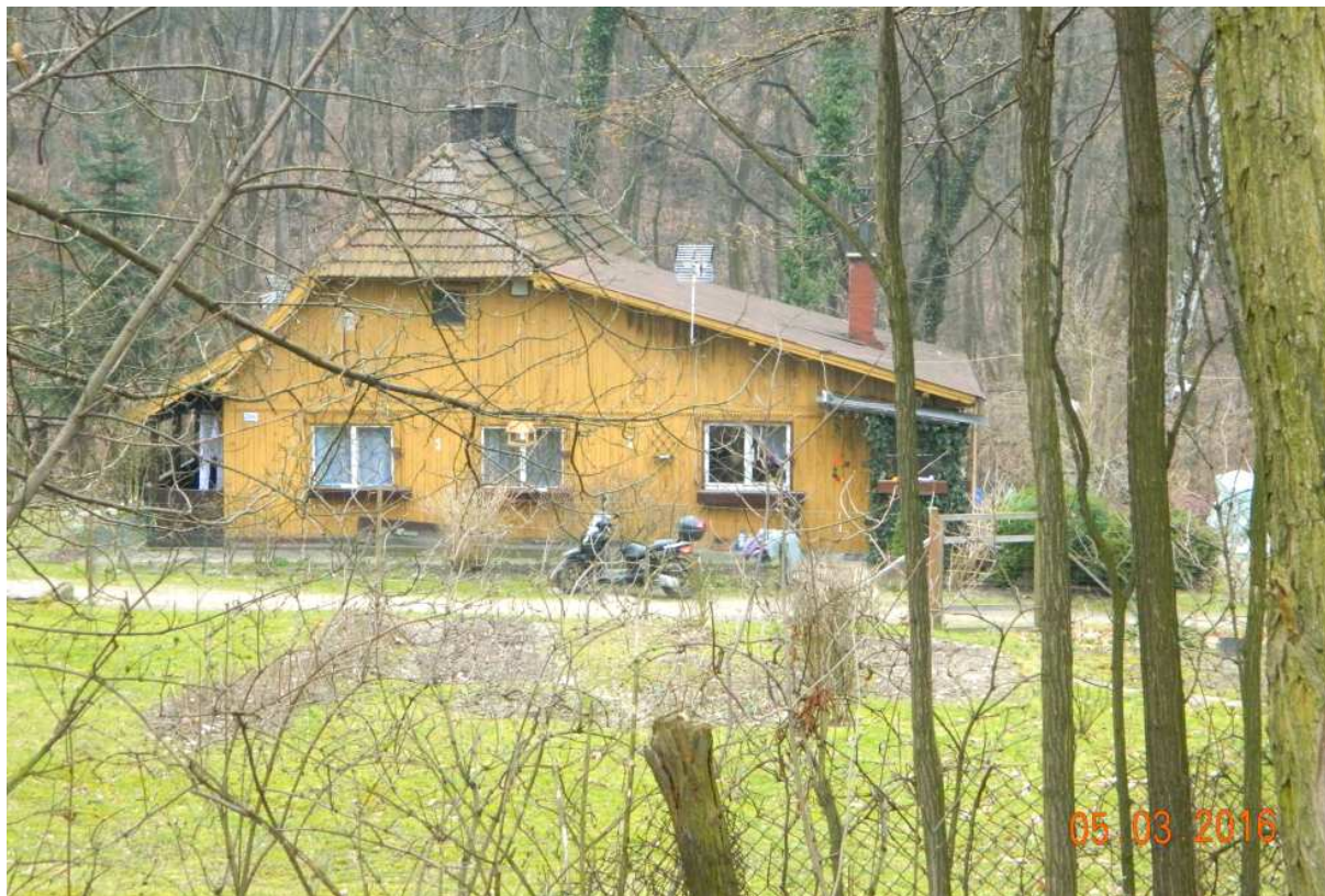
Fot. nr 178. Leśniczówka na styku ulic: Kukułczej i Leśnej.
