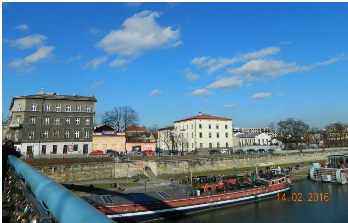
Fot. nr 83. Fragment zabudowy pomiędzy ulicami: Mostową i Gazową, z dawnym budynkiem kina Wisła pośrodku.
